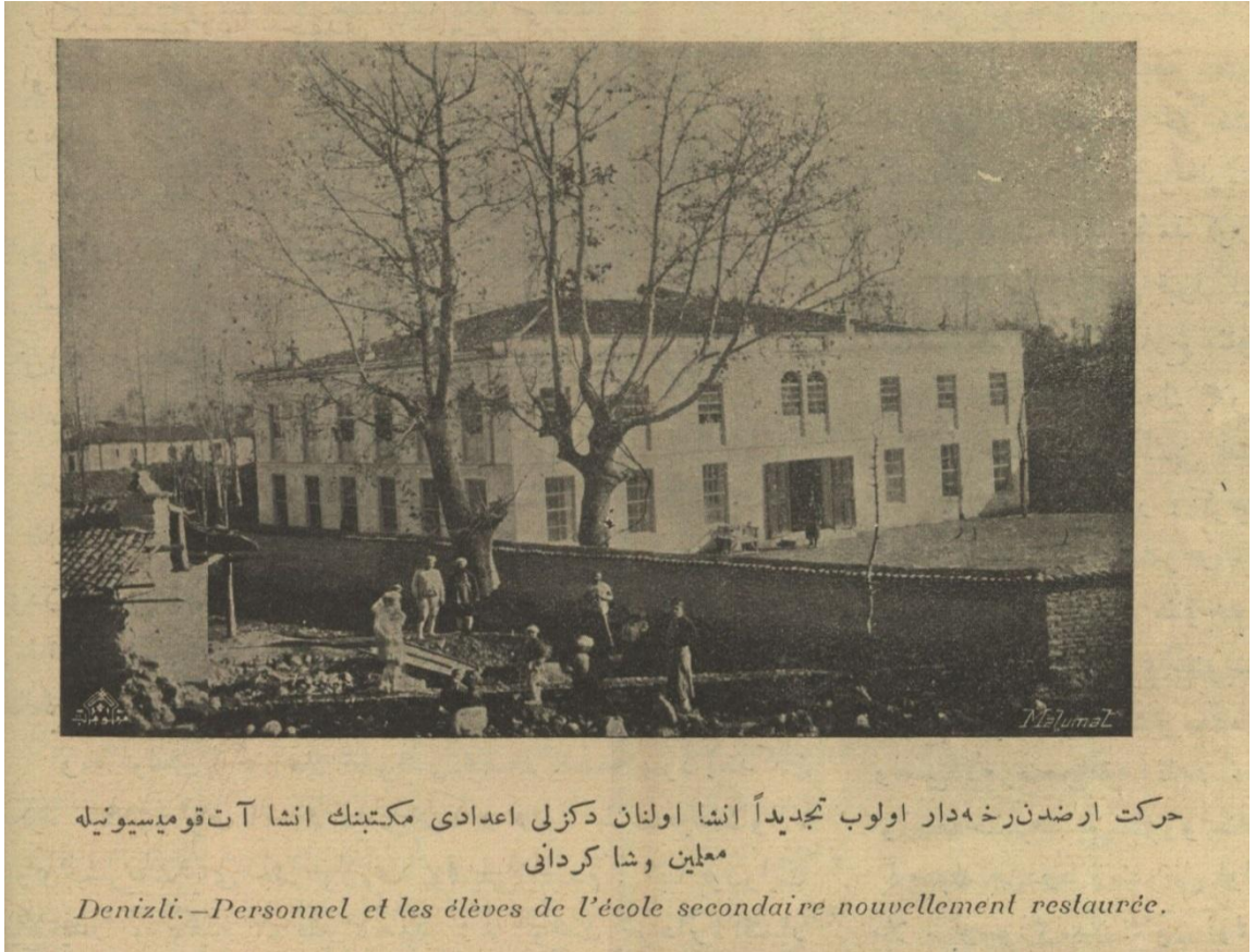
Resim 19. Hareket-i arzdan rahnedâr olup tecdîden inşâ olunan Denizli İdâdî Mektebi'nin inşaat komisyonuyla muallimîn ve şâkirdânı. (Malumat Dergisi'nden-17 Ocak 1901)
