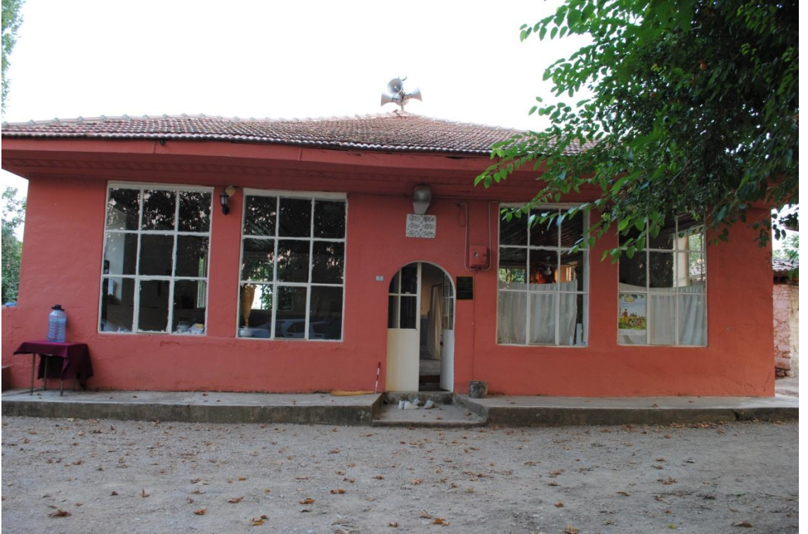
Fotoğraf 170: Hacı Ahmet Kahvesi Mescidi Kuzey Cephe.
