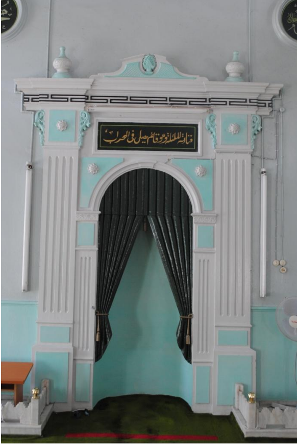
Fotoğraf 95: Saburhane Camii Mihrap Nişi.
