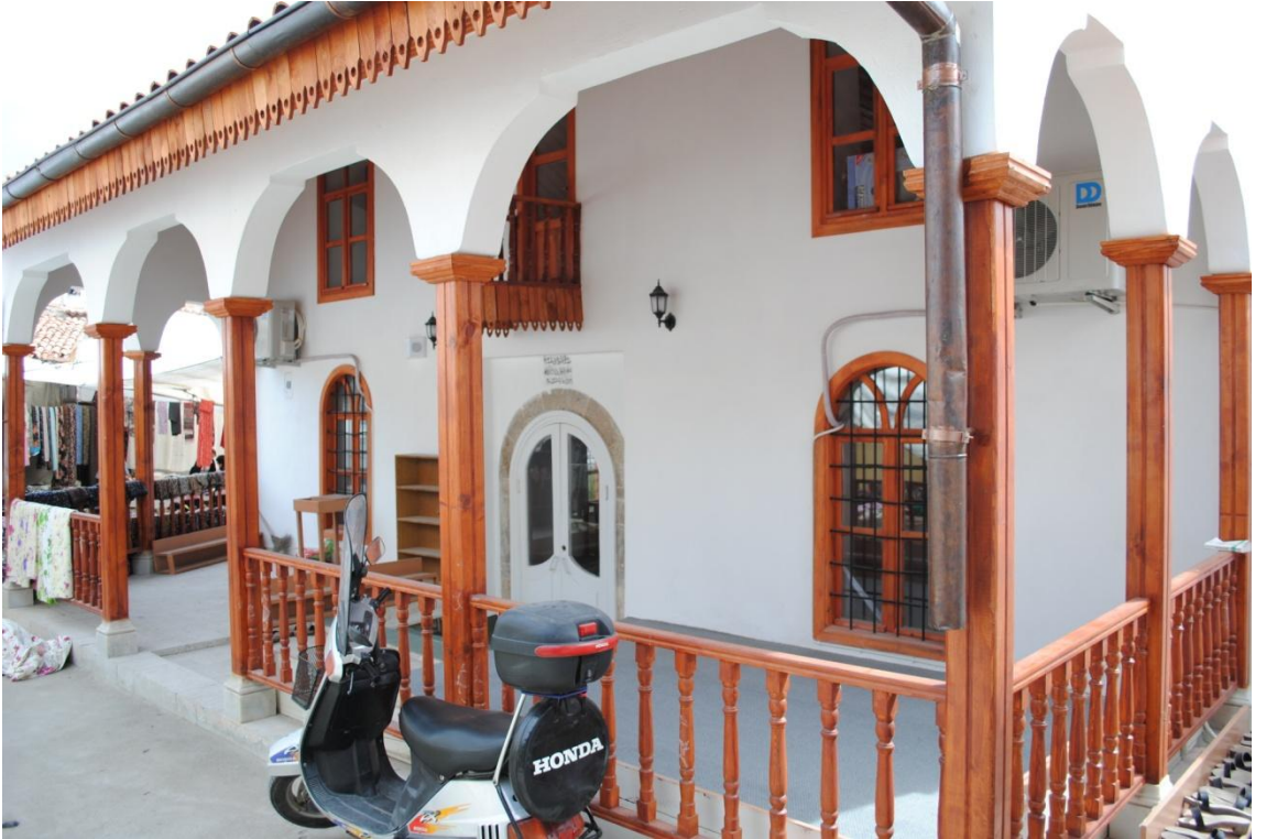
Fotoğraf 80: Pazar Camii Kuzey Cephe.
