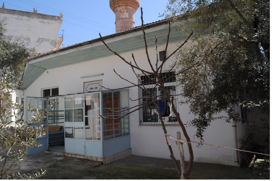
Fotoğraf 117: Sekibaşı Camii Kuzey Cephe.
