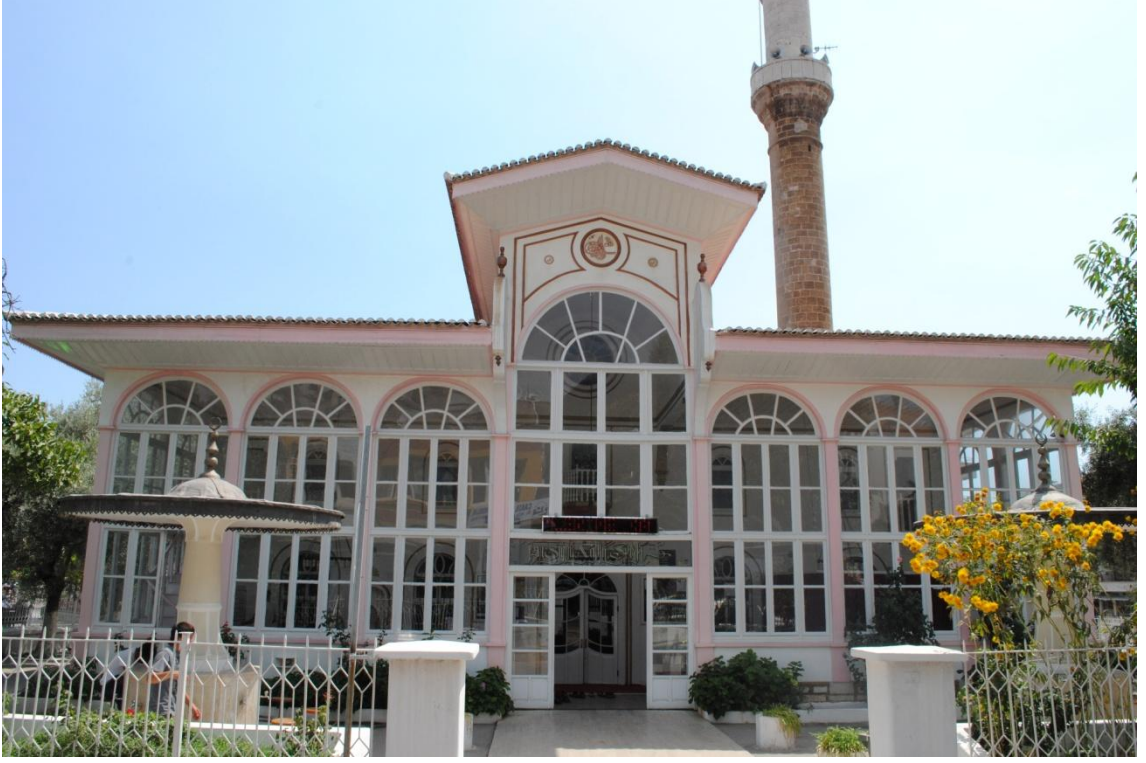
Fotoğraf 15: Kurşunlu Camii Kuzey Cephe.
