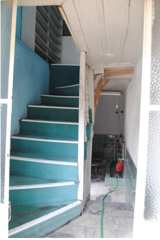
Fotoğraf 129: Konakaltı Camii Üst Kata Çıkan Merdivenler ve Abdestlik Mekanı.
