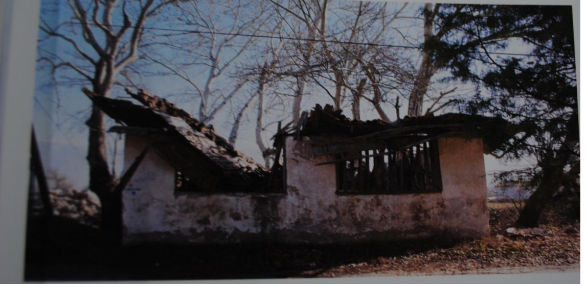
Fotoğraf 207: Kır Kahvesi Mescidi Restorasyondan Önceki Durumu (MKTVKK'dan).
