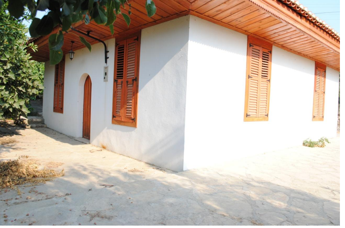
Fotoğraf 195: Yeni Bakkallar Mescidi Kuzey ve Batı Cephesi.
