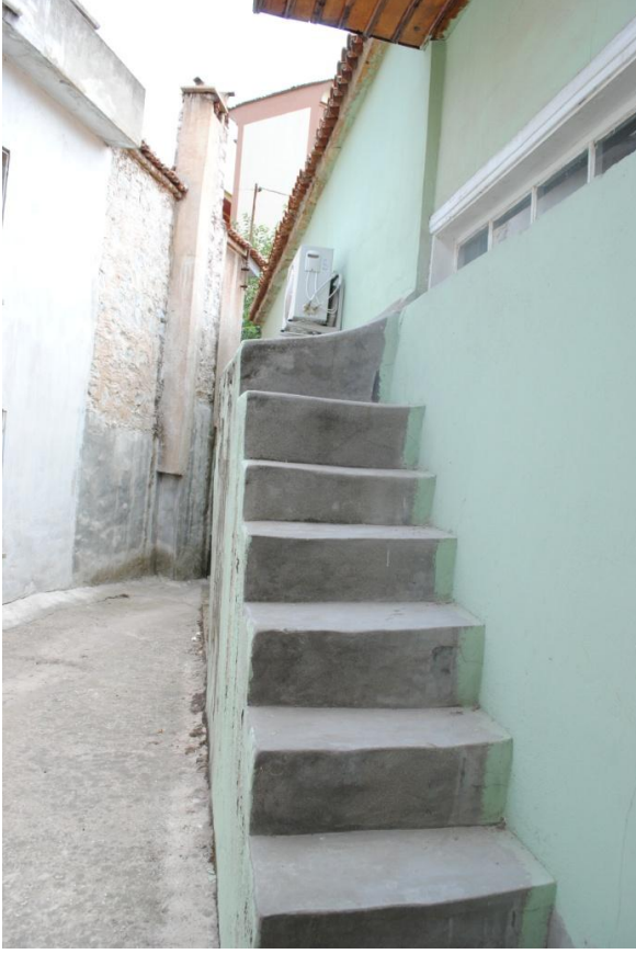
Fotoğraf 73: Kurbanzade Camii Kuzeydoğuda Yer Alan Günümüzde İşlevi Olmayan Merdiven.
