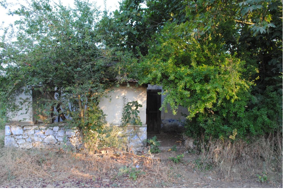
Fotoğraf 215: Kadı Kahvesi Mescidi Kuzey Cephesi ve Kuzeydoğuda Yer Alan Müştemilat.
