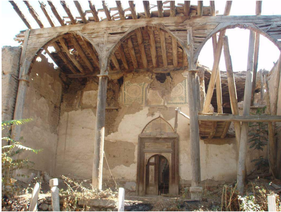
Resim 294: Denizli, Çivril Savranşah Cami, 1798-1799, Restorasyon Öncesi Dış Cepheden Görünüm (Tuğçe Yurtsal'dan).
