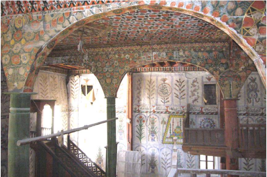
Resim 328: Denizli, Baklan Boğaziçi Cami, 1774-1876, Ahşap Örtü ve Kalem İşi Süslemeler.
