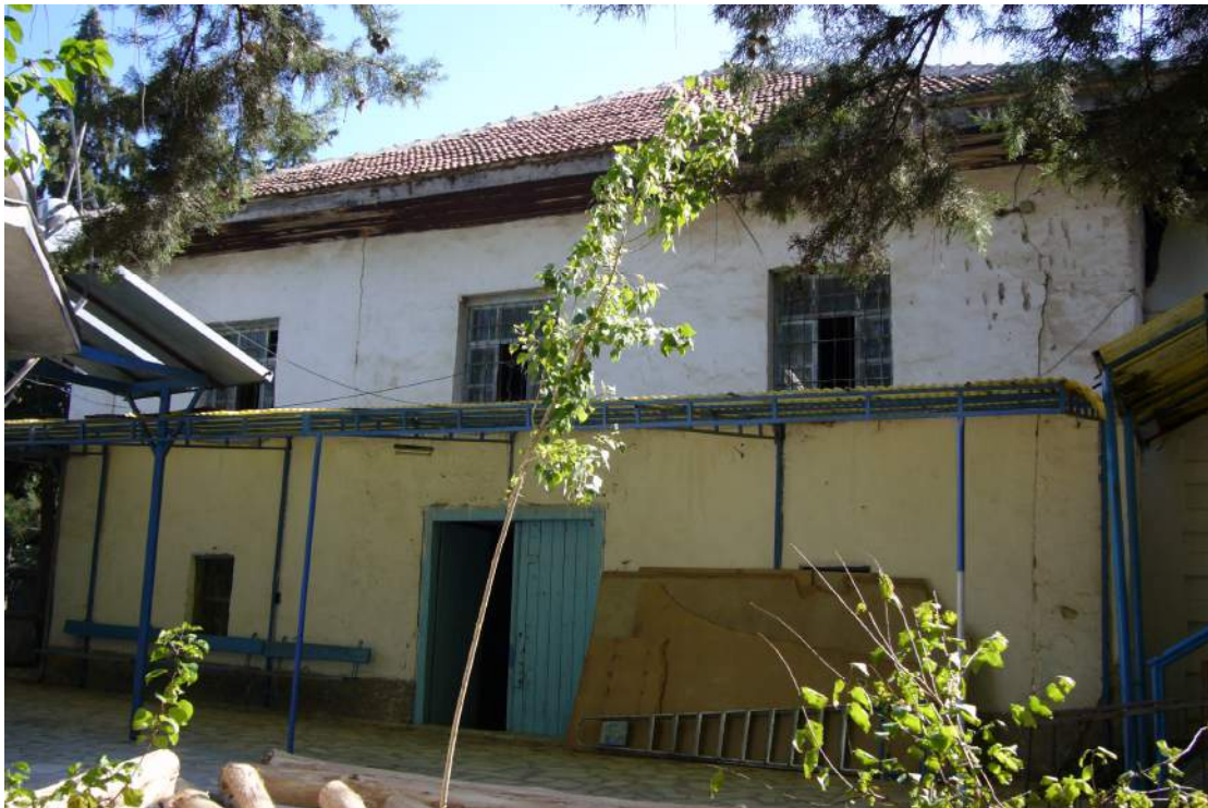
Resim 326: Denizli, Baklan Boğaziçi Cami, 1774-1876, Kuzey Cepheden Görünüm.
