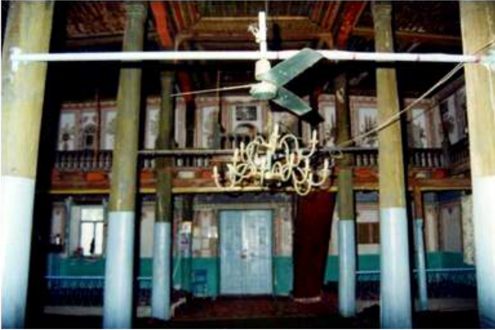
Resim 297: Denizli, Acıpayam Yazır Kasabası Cami, 1802-1803, Örtüyü Taşıyan Destekler ve İçten Görünüş.
