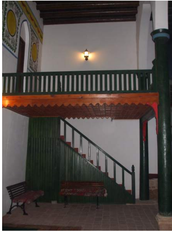
Resim 272: Denizli, Çivril Sıvransah Cami, 1798-1799, Harime Kapısının Sağındaki Mahfil Katı.
