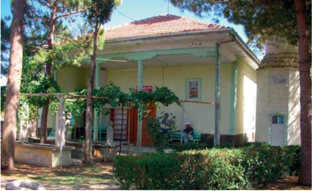
Resim 399: Denizli, Çivril Bulgurlar Köyü Cami, 18.Yüzyılın Üçüncü Çeyreği 19.Yüzyılın Sonları, Kuzeyden Görünüm.
