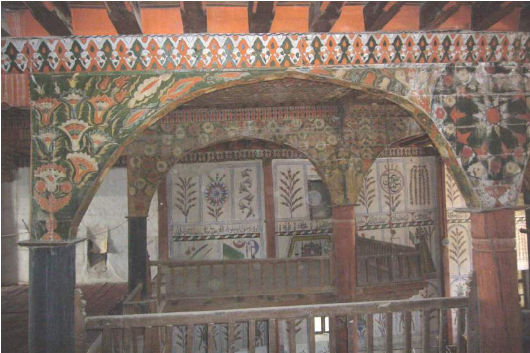
Resim 330: Denizli, Baklan Boğaziçi Cami, 1774-1876, Taşıyıcı Sistemi ve Tavandan Görünüm.
