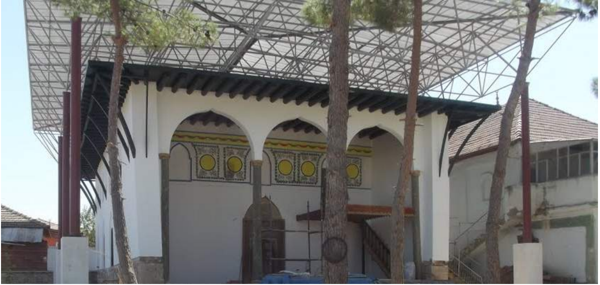
Resim 273: Denizli, Çivril Savranşah Cami, 1798-1799, Restorasyon Sonrasında Eklenen Çelik Örtü.
