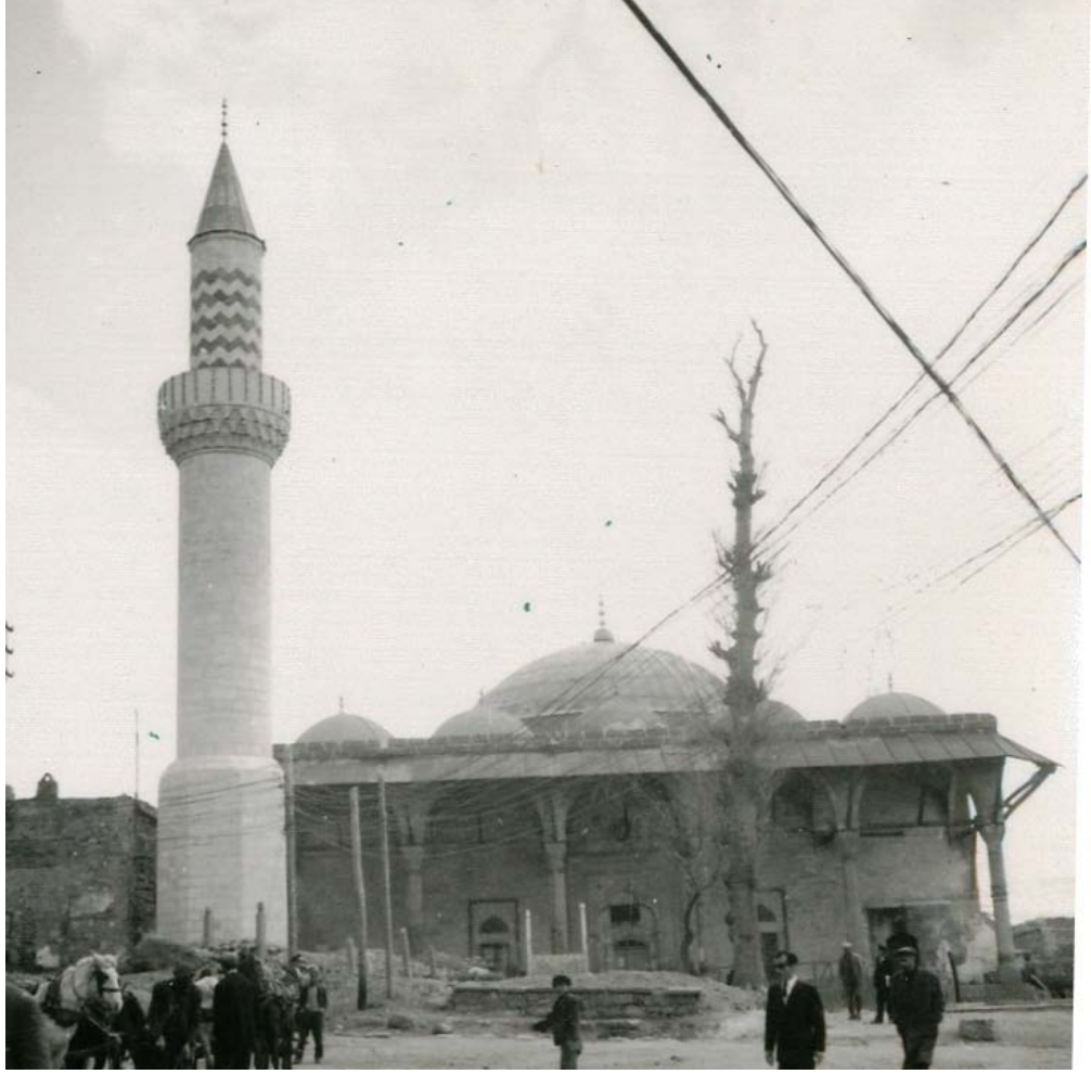
Fotoğraf 28: Murad Paşa Camii 1960 Yılında Yapılan Minare (VGM).
