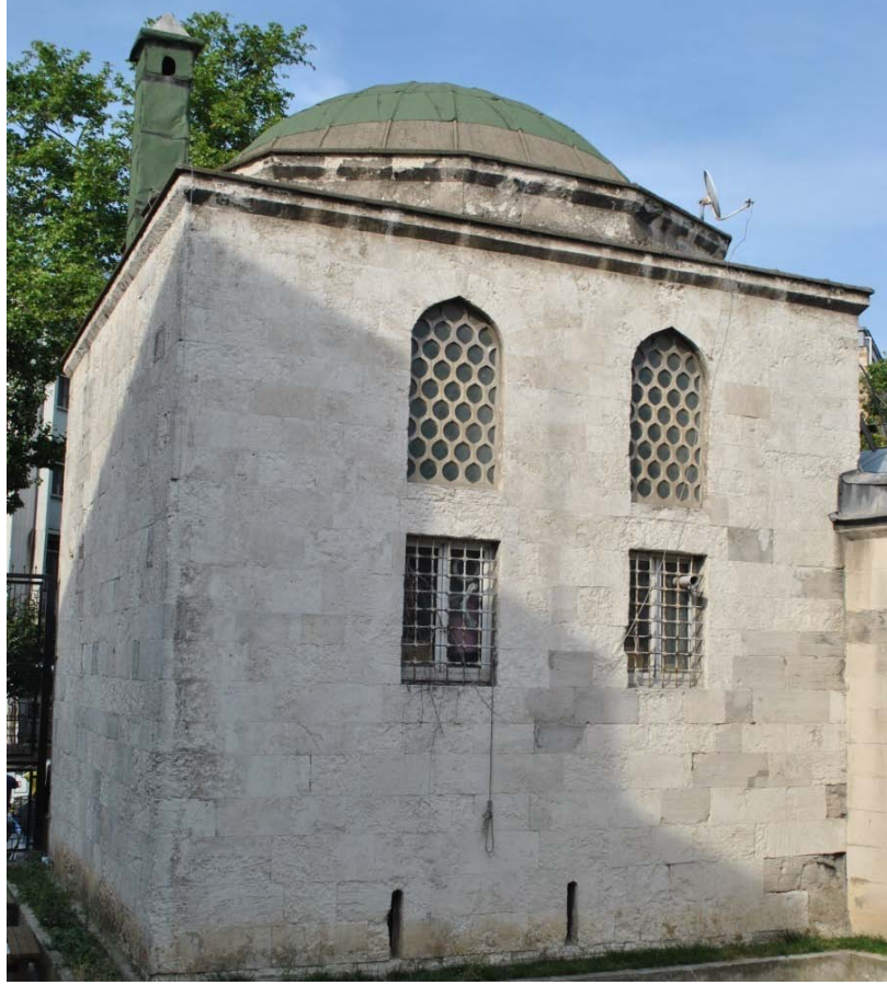
Fotoğraf 101: Murad Paşa Sıbyan Mektebi Güneybatı Cephesi Pencereleeri.
