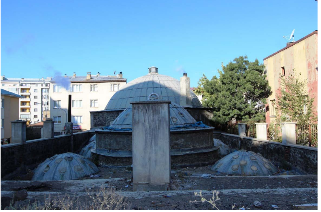
Fotoğraf 24: Murad Paşa Hamamı Kubbeleri Örtü Sistemi.
