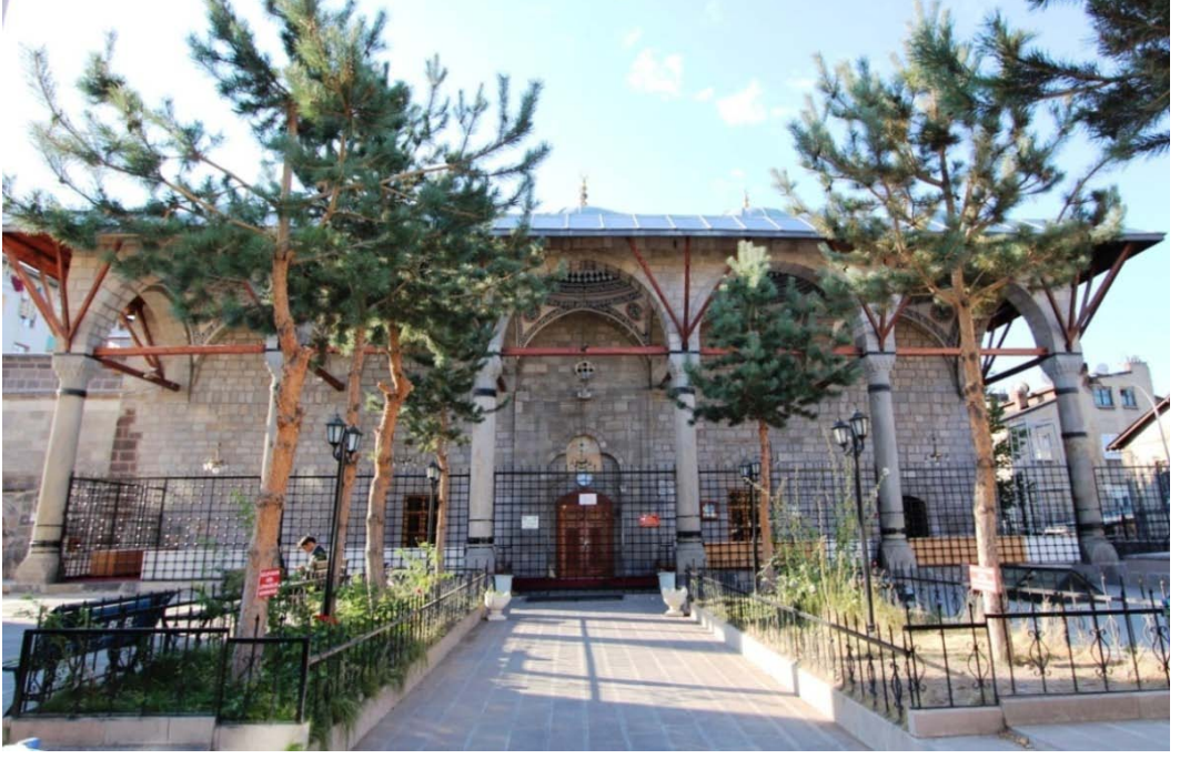
Fotoğraf 34: Murad Paşa Camii Kuzey Cephe.
