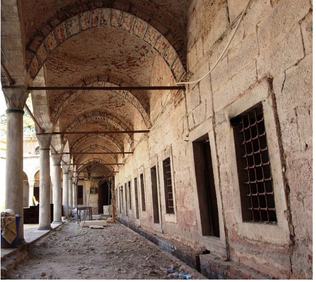
Fotoğraf 89: Murad Paşa Külliyesi Revaklar (2014-2015 Restorasyonu).
