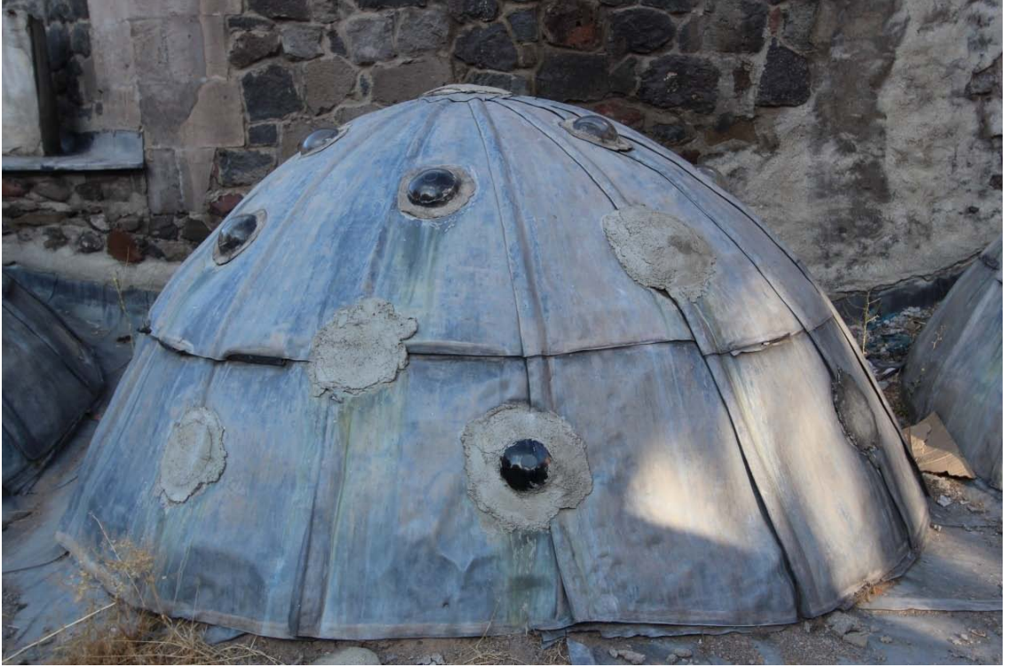
Fotoğraf 25: Murad Paşa Hamamı Ilıklık Kubbesi Aydınlatma Açıklıkları.
