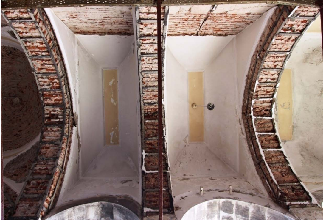
Fotoğraf 75: Dershane Önündeki Aynalı Tonzlar (2014-2015 Restorasyonu).
