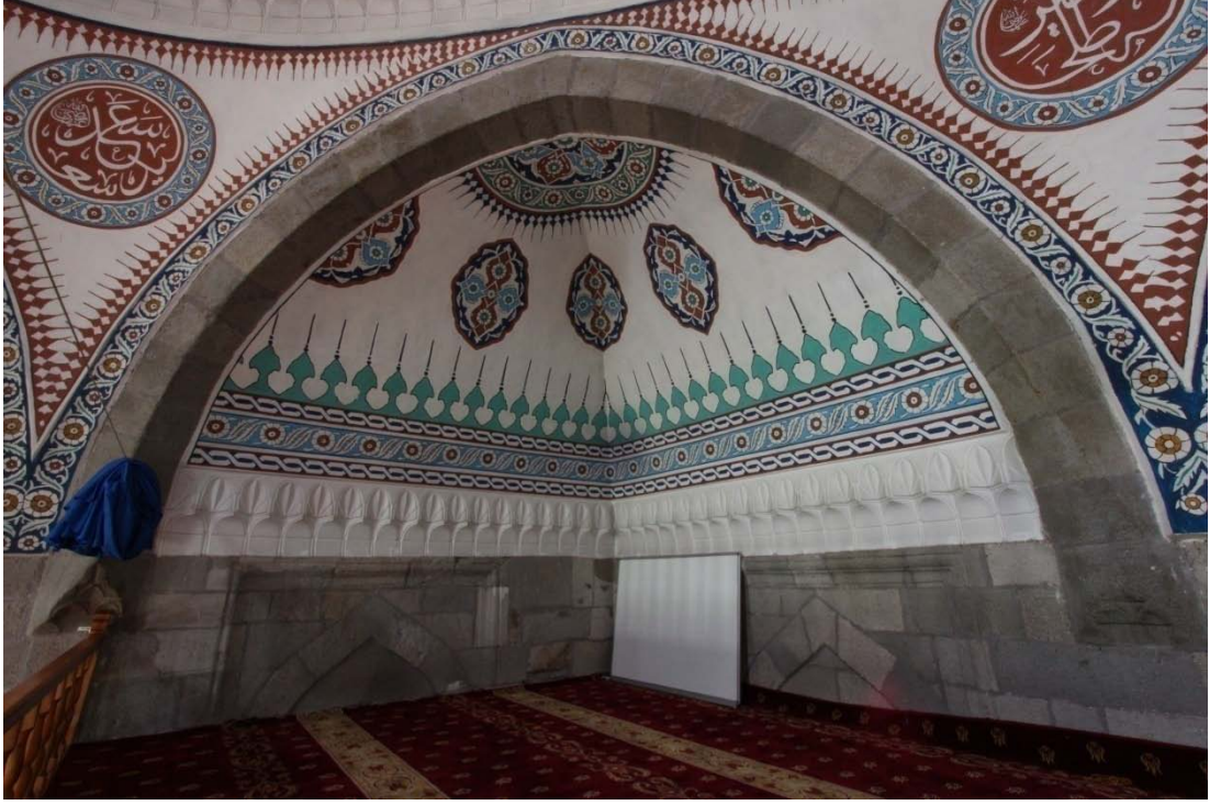
Fotoğraf 60: Murad Paşa Camii Kuzeybatı Köşesi Tromp.
