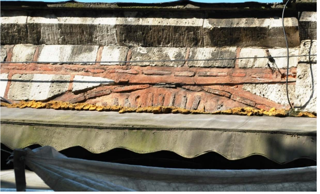
Fotoğraf 105: Murad Paşa Dükkânlar Kuzeydoğu Cephesi Almaşık Duvar.
