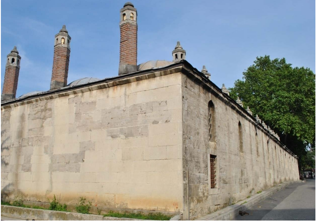
Fotoğraf 77: Murad Paşa Medresesi Kuzeybatı ve Güneybatı Cephesi.
