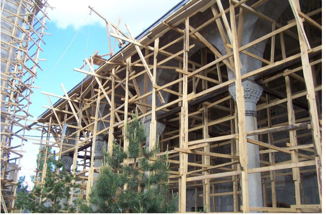
Fotoğraf 32: Murad Paşa Camii 2007 Restorasyonu (VGM).
