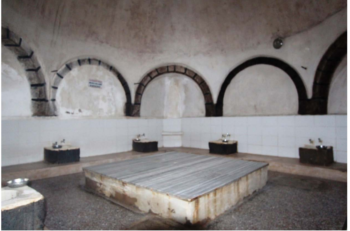
Fotoğraf 8: Küçük Hamam Sıcaklık Kısmı.
