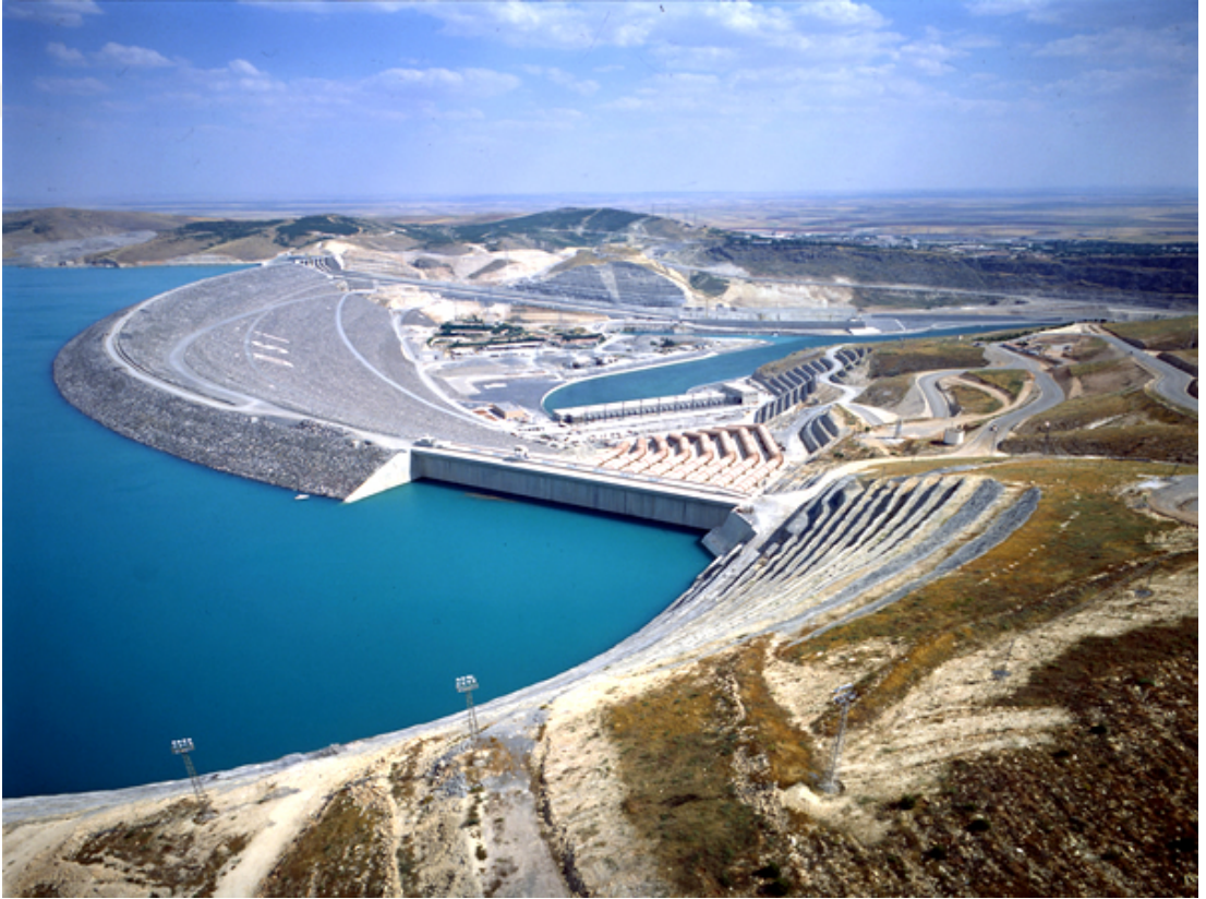
Şekil 1. Karakaya Barajı Günümüzdeki Görüntüsü
