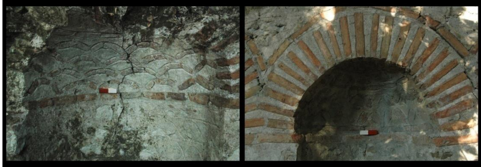
Şekil 27. Vaftizhane vestibulum batı cephesi detay (Öztaşkın. 2013: Şek. 78)
