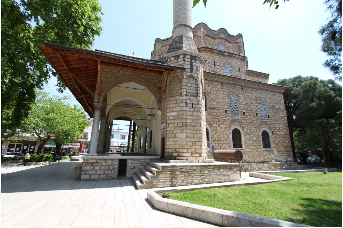
Fot. 7: Batı Cephe Görünümü.
