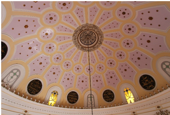
Fot. 167: Kubbe Yüzeyindeki Süslemeler.
