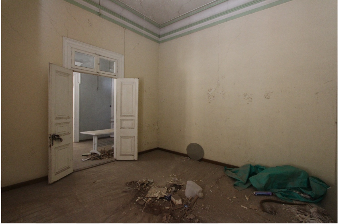
Fot. 239: İkinci Kat Güney Köşe Oda Görünümü.
