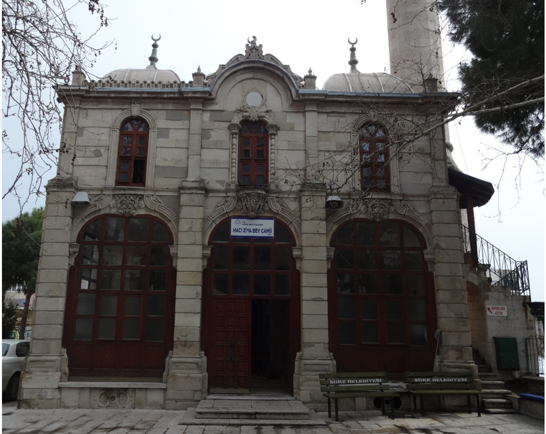
Fot. 92: Kuzey Cephe Görünümü.
