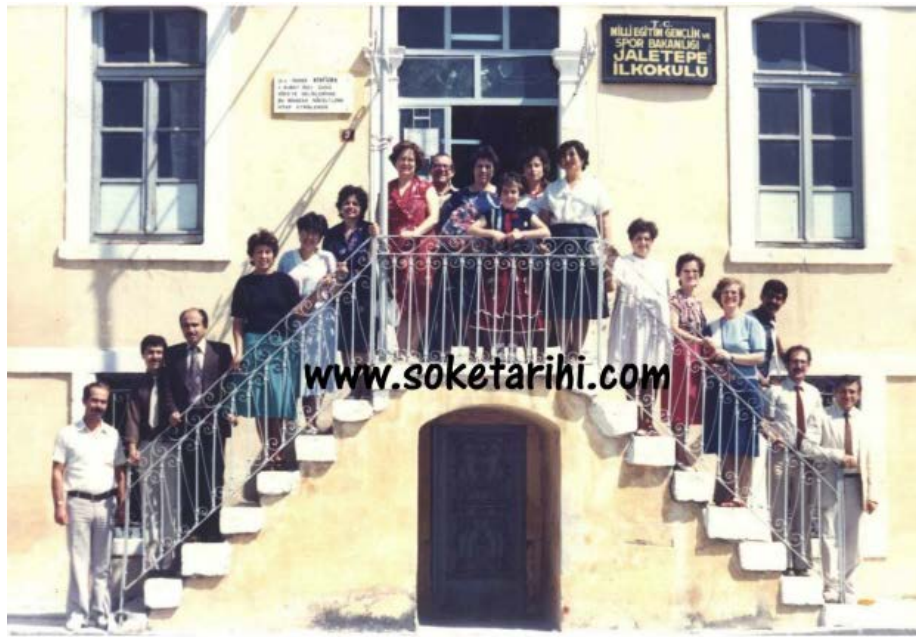
Fot. 271: Batı Cephe Bodrum Kat Kapısı (Belediye Arşivi).
