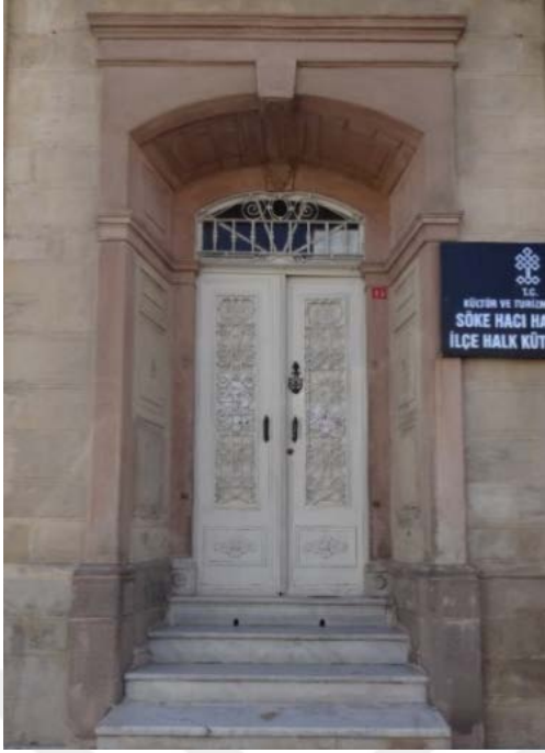
Fot 187: Kuzeydoğu Kapı Açıklığı.
