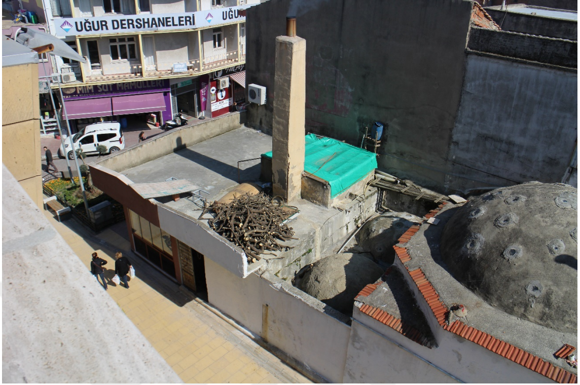
Fot. 265: Külhan Bölümünden Görünümü.
