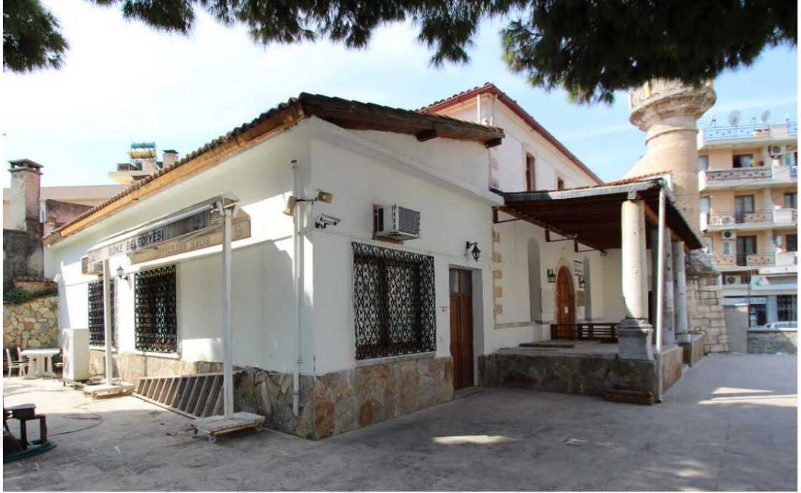
Fot. 47: Kuzeydoğu Cephe Görünümü.
