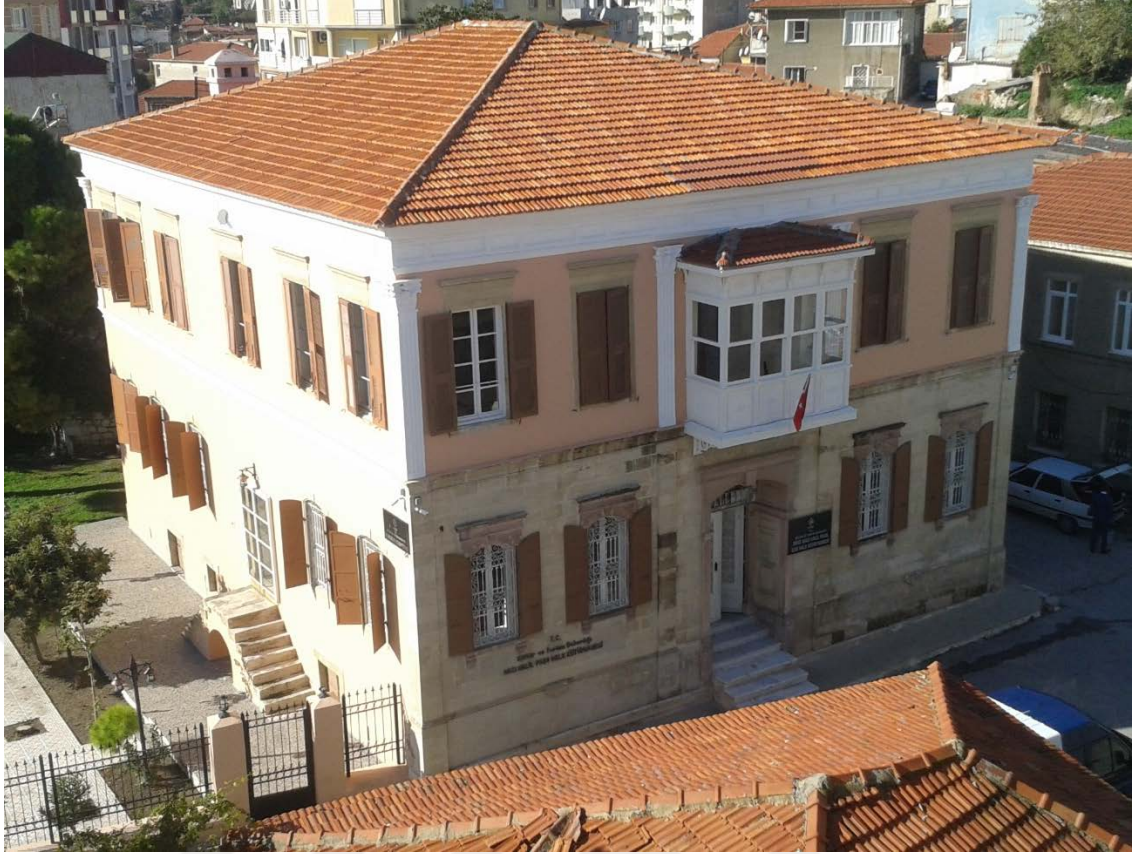
Fot. 186: Kuzeydoğu Cephe Görünümü.
