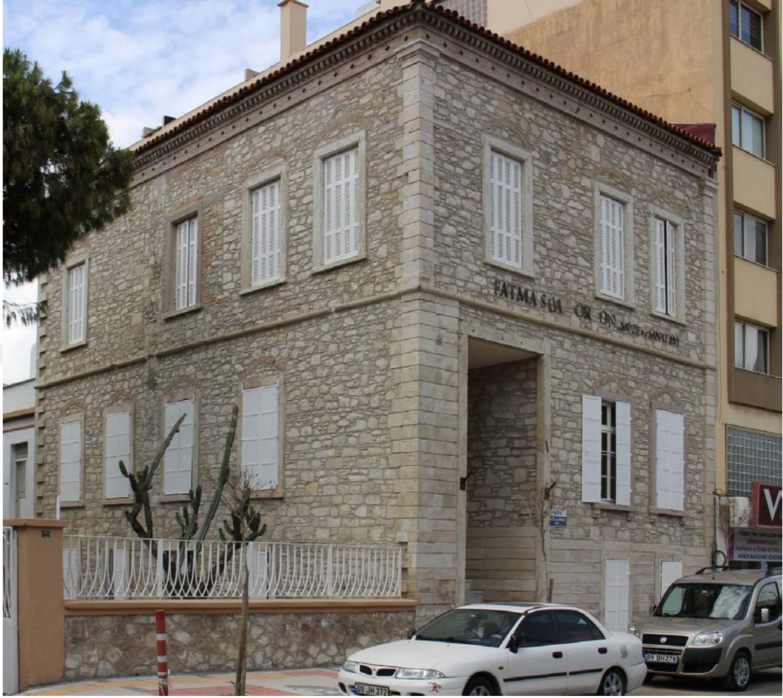
Fot. 253: Batı Cephe Görünümü.
