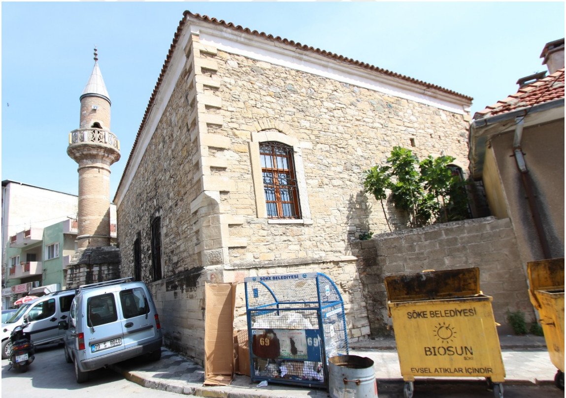
Fot. 48: Güneydoğu Cephe Görünümü.
