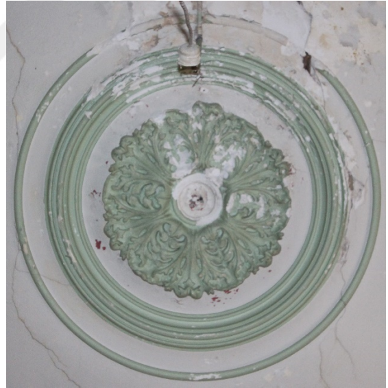
Fot. 241: İkinci Kat Güney Köşedeki Oda Tavan Göbeği Detay
