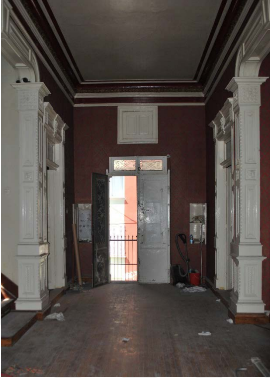
Fot. 224: Sofa Güneybatı Görünümü.
