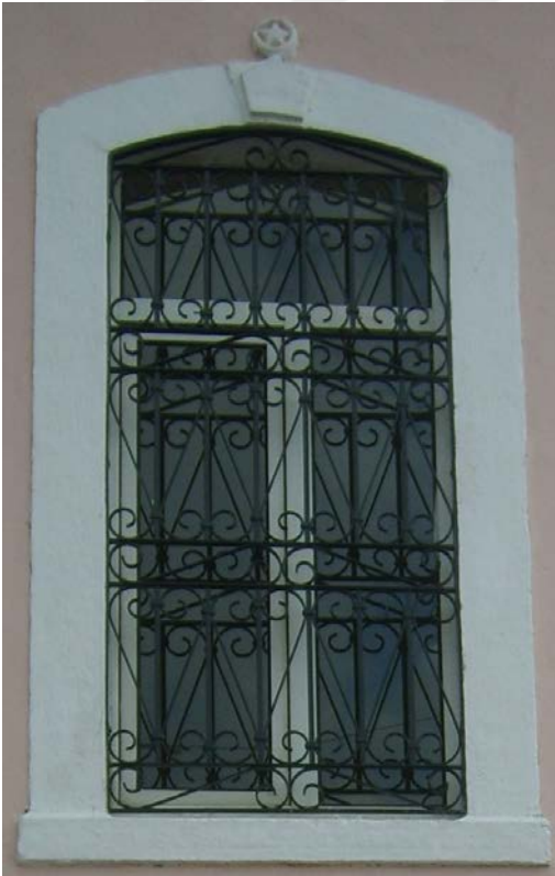
Fot. 267: Basık Kemerli Pencere.
