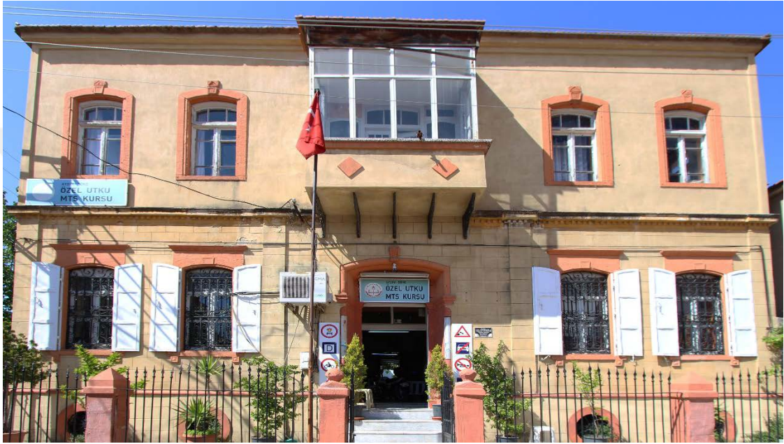
Fot. 205: Güney Cephe Görünümü.
