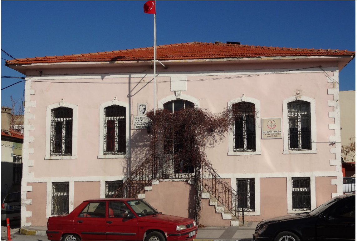
Fot. 272: Batı Cephe Görünümü.
