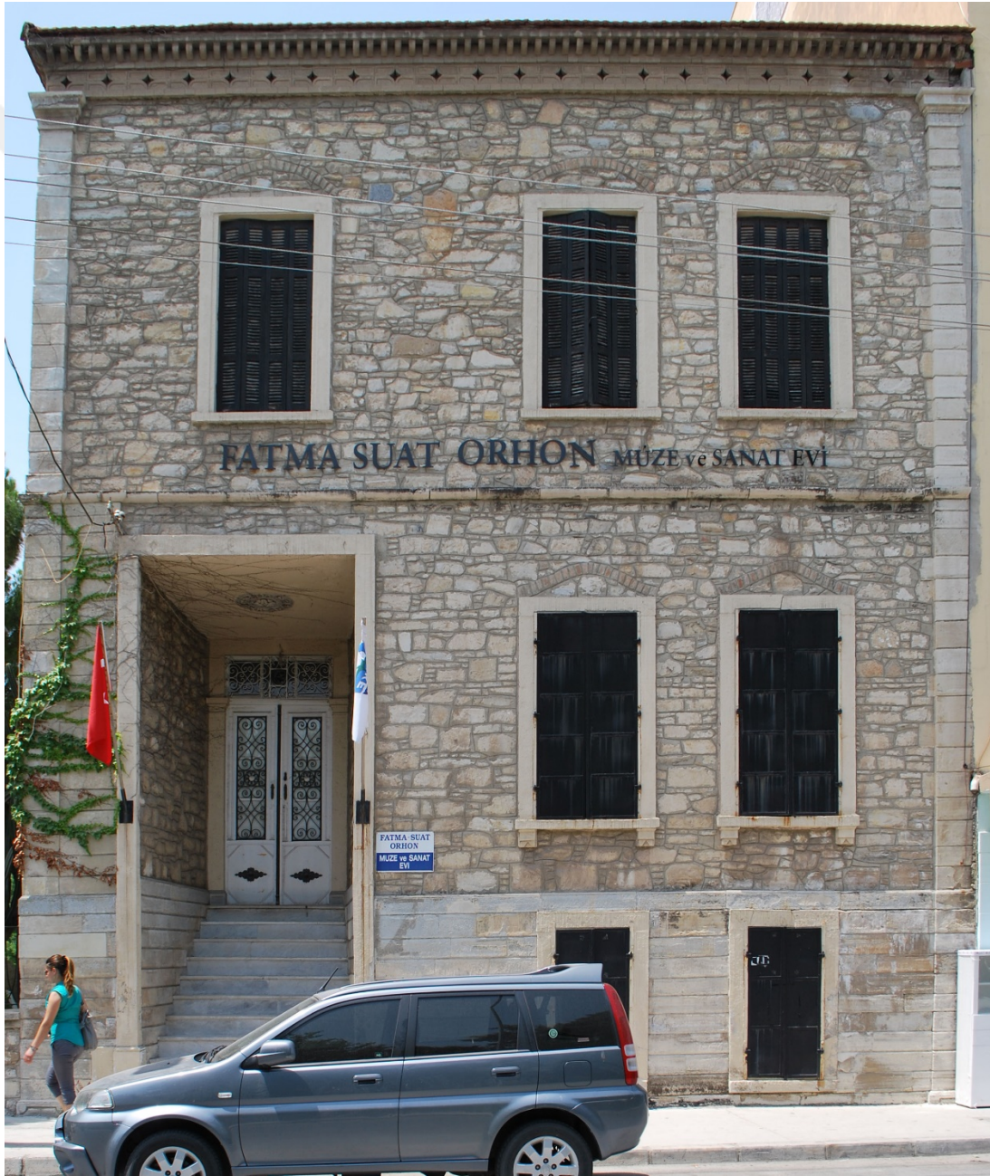
Fot. 250: Güney Cephe Görünümü.
