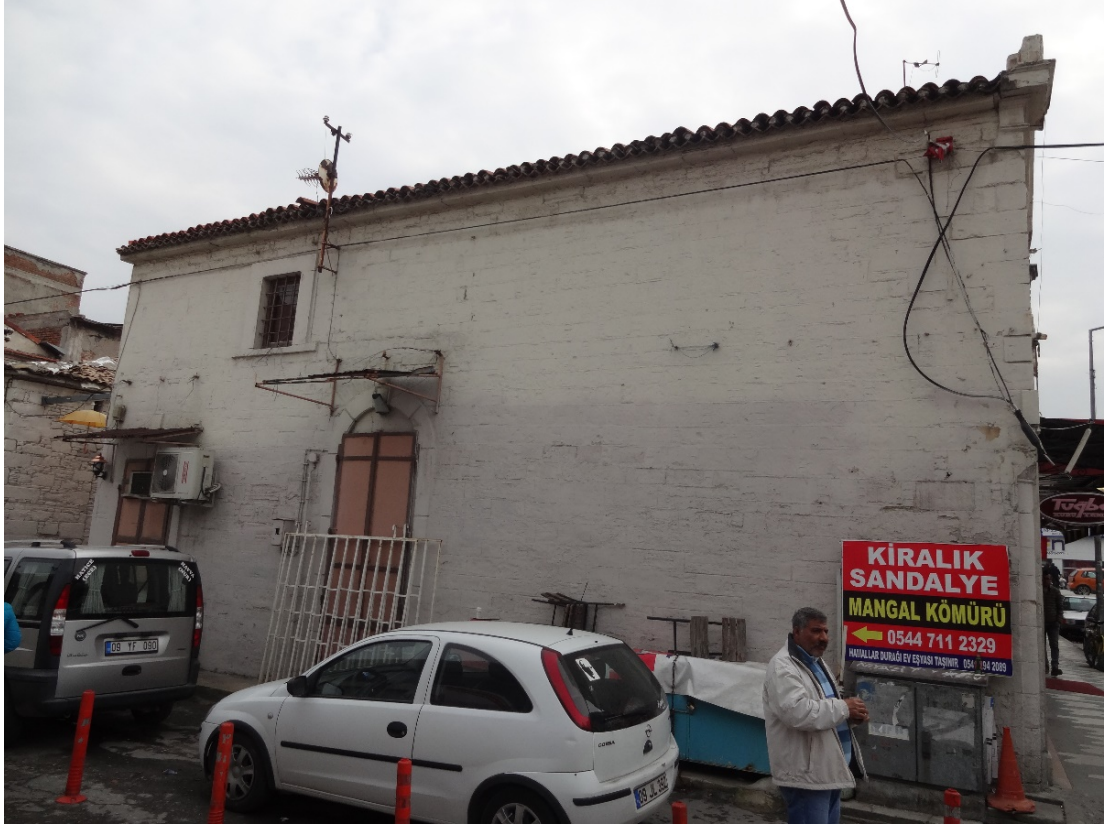
Fot. 288: Fuat Ersoy Kâgir Dükkân Doğu Cephe Görünümü.
