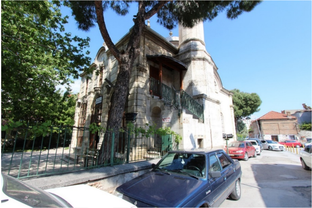
Fot. 91: Kuzeybatı Cephe Grnm.
