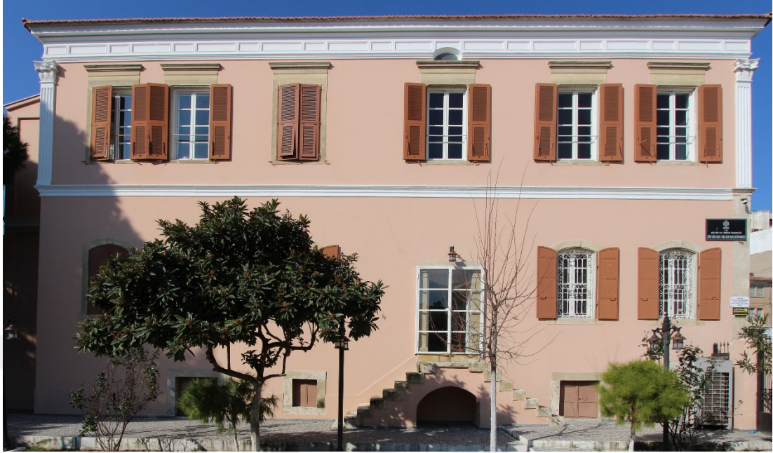
Fot. 180: Güneydoğu Cephe Görünümü.
