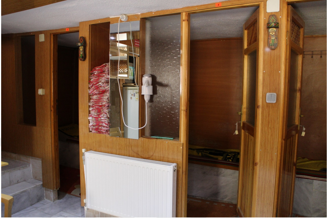
Fot. 261: Soğukluk (Soyunmalık) Bölümü Güney Cephe Görünümü.
