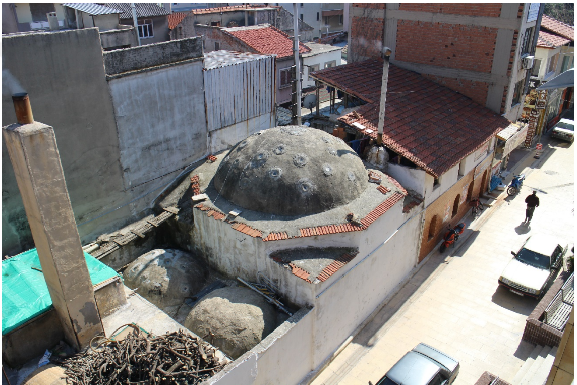
Fot. 260: Kuzeydoğu Cephe Örtü Sistemi Görünümü.
