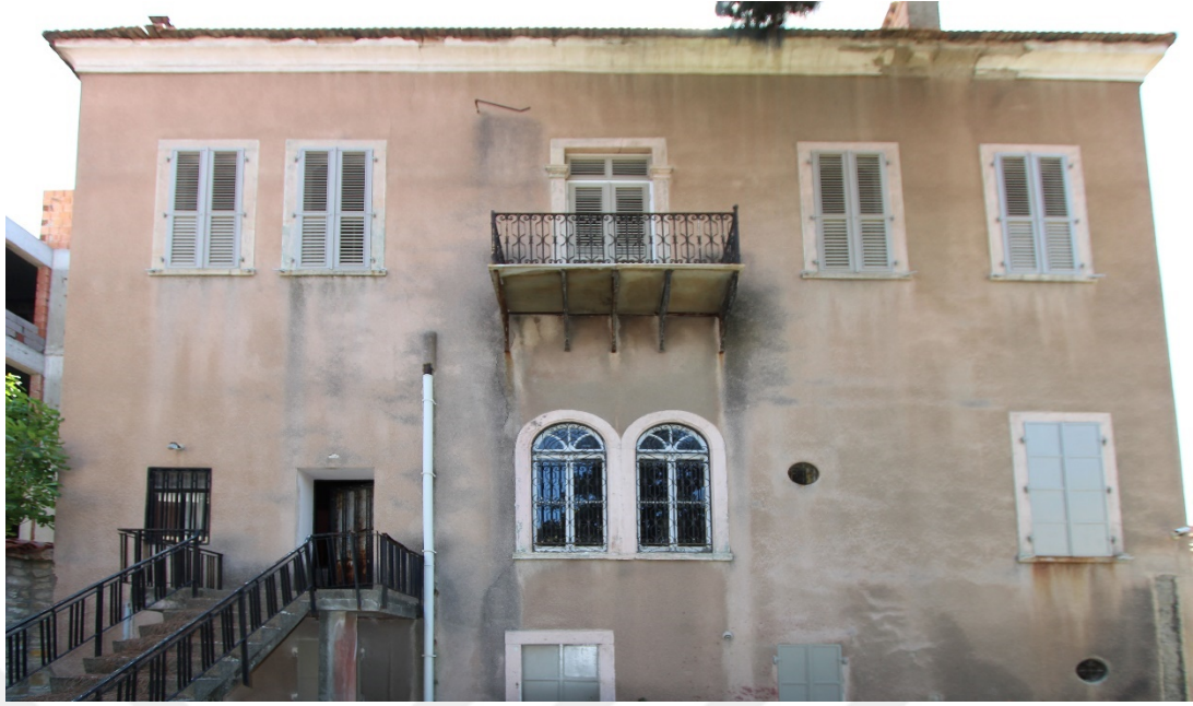
Fot. 221: Kuzeydoğu Cephe Görünümü.
