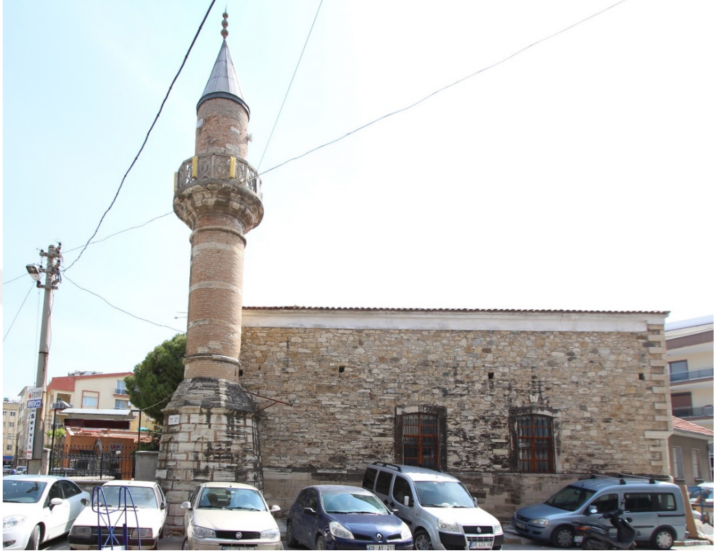
Fot. 49: Batı Cephe Görünümü.
