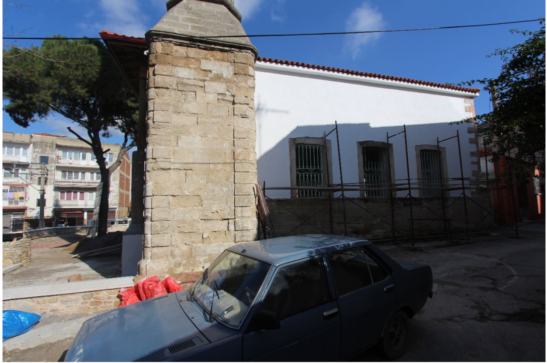
Fot. 67: Batı Cephe Görünüm Restorasyon Sonrası Görünümü.
