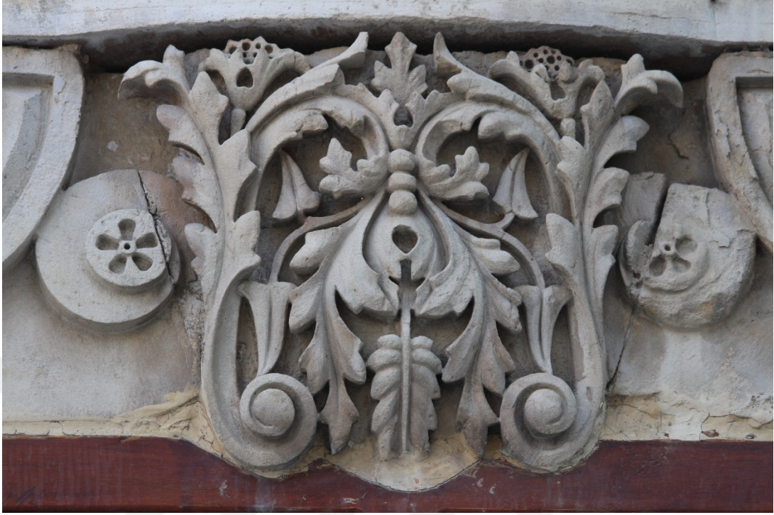
Fot. 93: Kemer Kilit Taşındaki Akantus Yapraklarından Görünüm.
