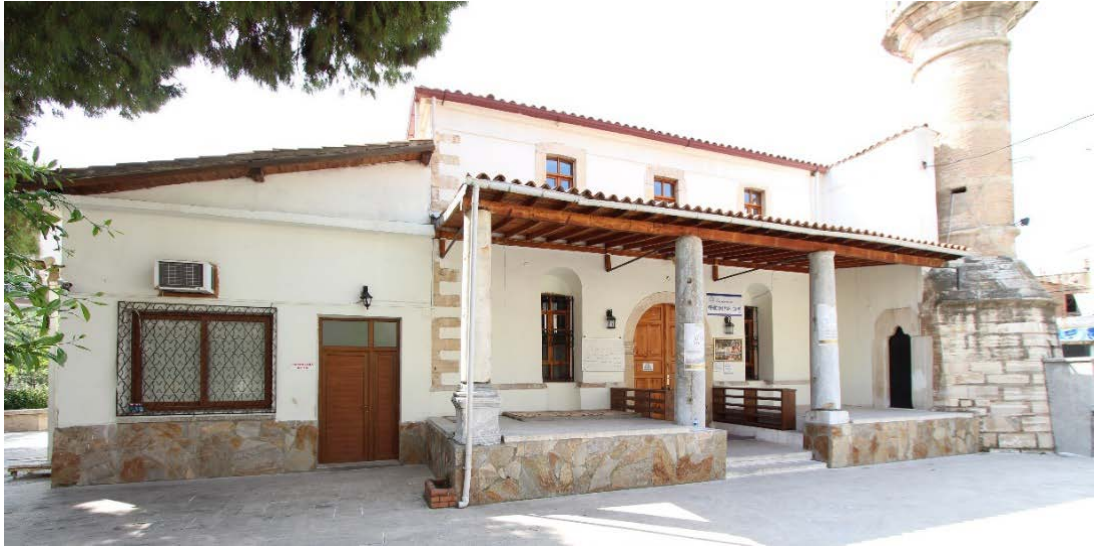
Fot. 51: Kuzey Cephe Görünümü.
