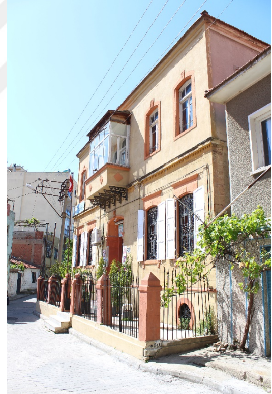
Fot. 203: Kocaöner Evi Güneydoğu Cephe.
