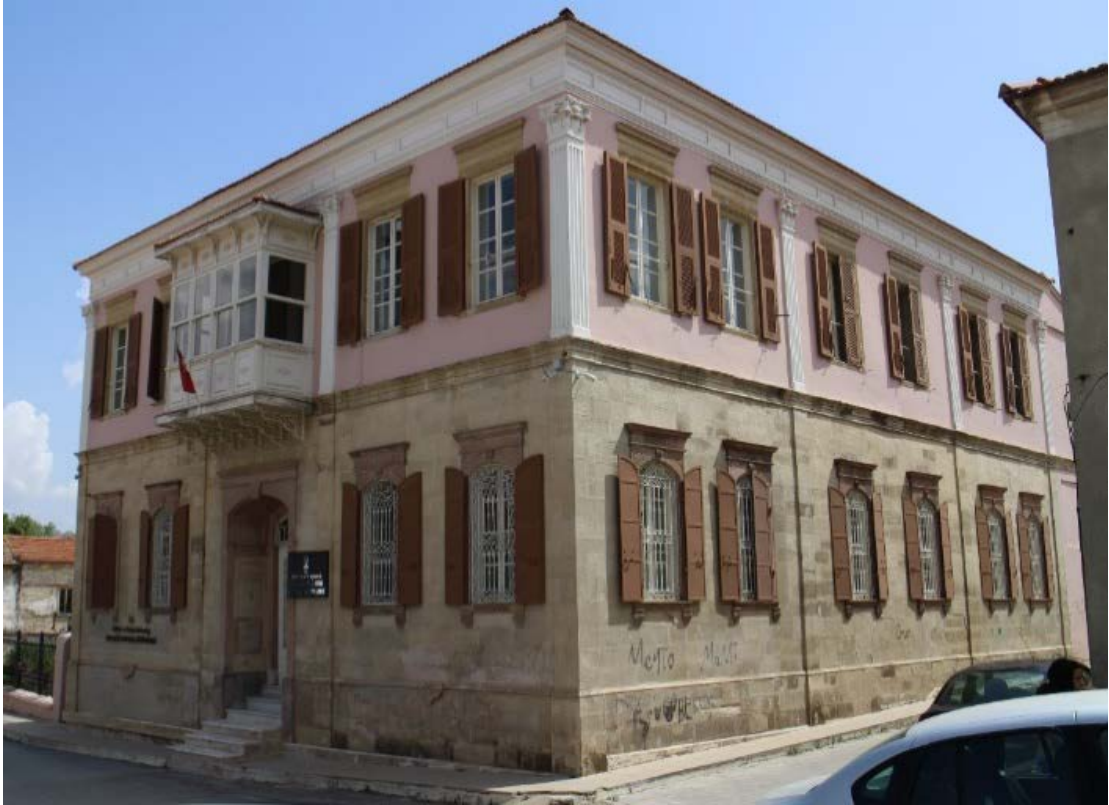
Fot. 182: Kuzey Cephe Görünümü.
