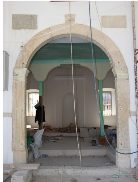
Fot. 61: Kapı Açıklığı Restorasyon Sonrası Görünümü.
