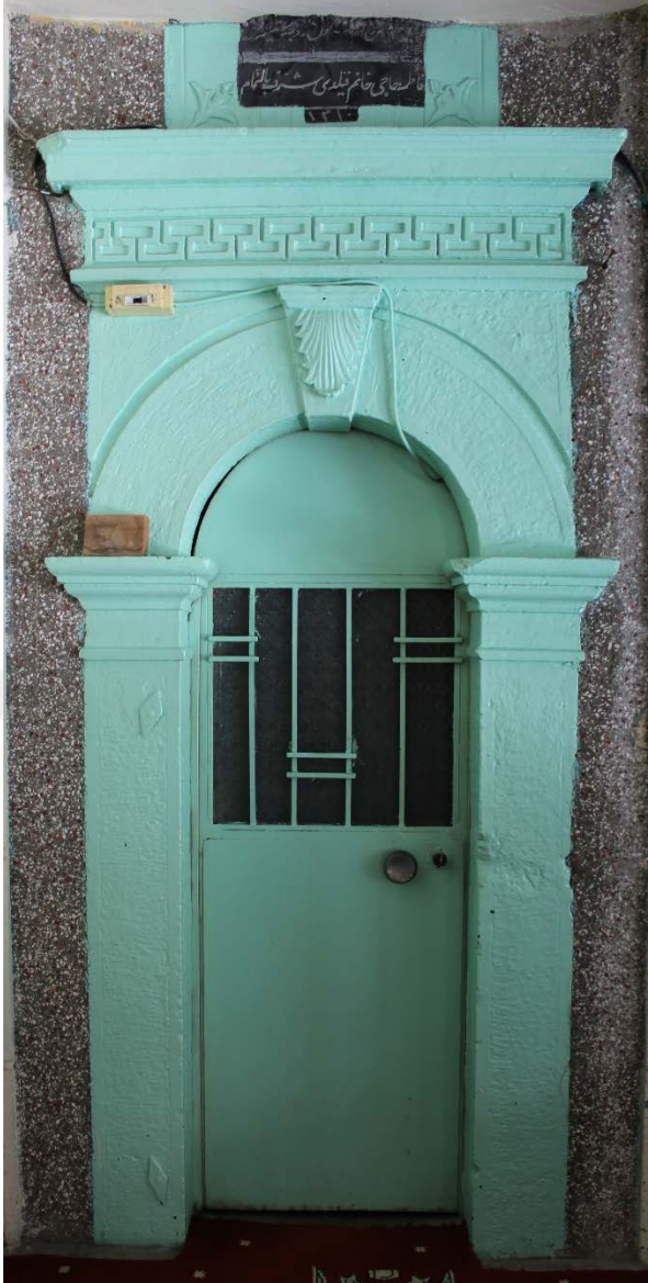
Fot. 71: Minare Kapı Açıklığı Görünümü.
