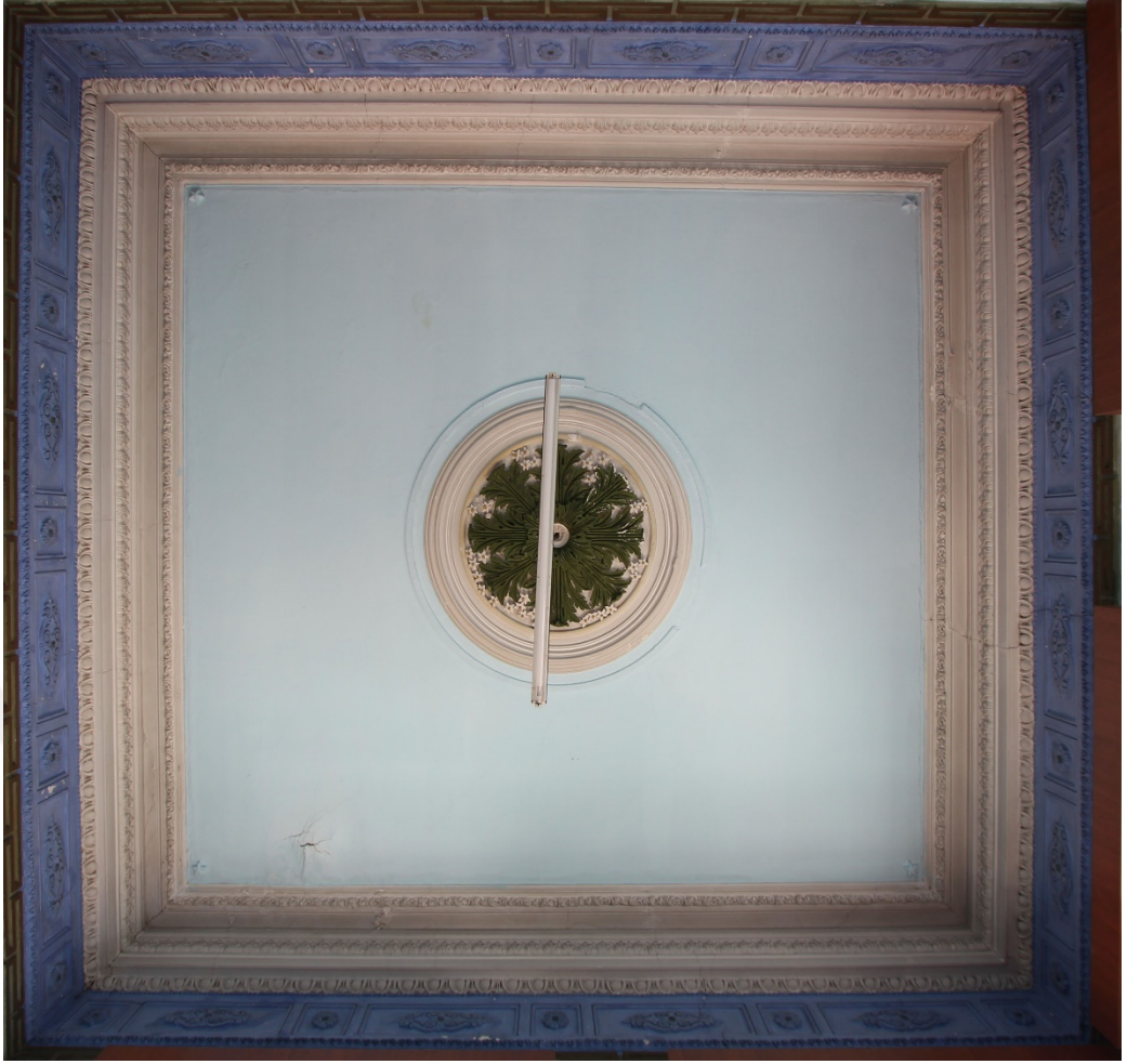
Fot. 214: İkinci Katta Güneybatı Köşedeki Başodanın Çökertme Tavanı Görünümü.
