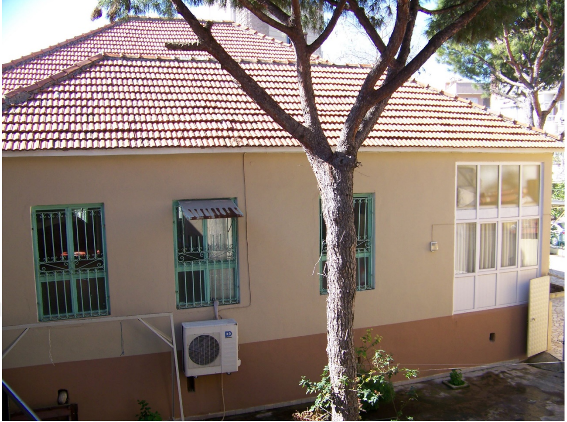
Fot. 65: Ek Mekânın Doğu Cephe Görünümü.
