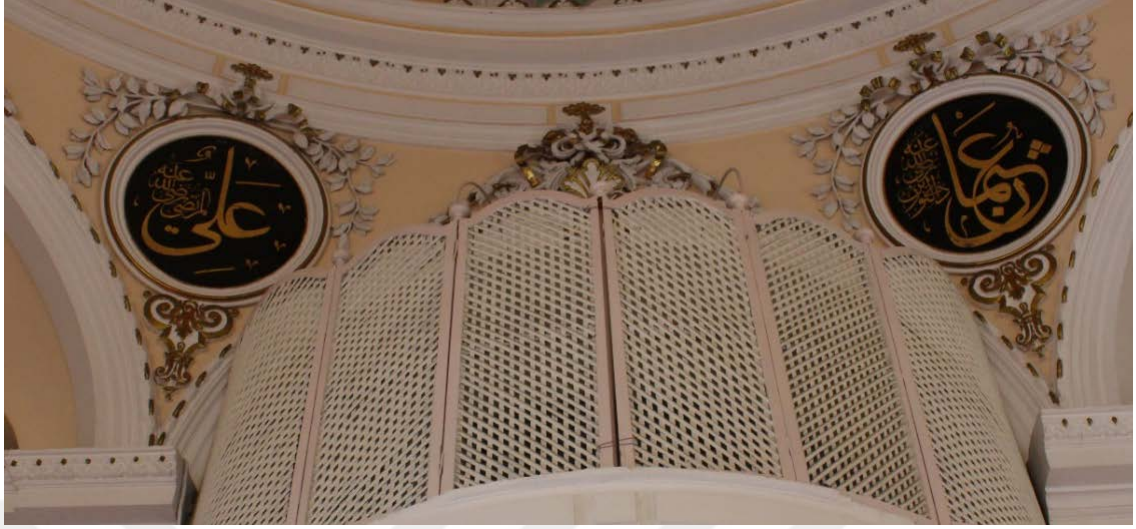
Fot. 160: Kuzey Cephe Kubbe Geçiş Ögelerinde Yer Alan Yazı Kartuşları.
