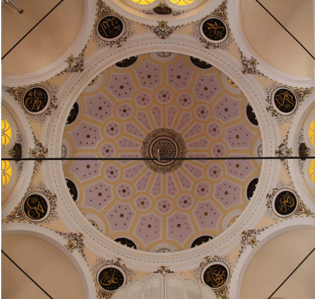
Fot. 151: Kubbe Geçiş Elemanları Görünümü.
