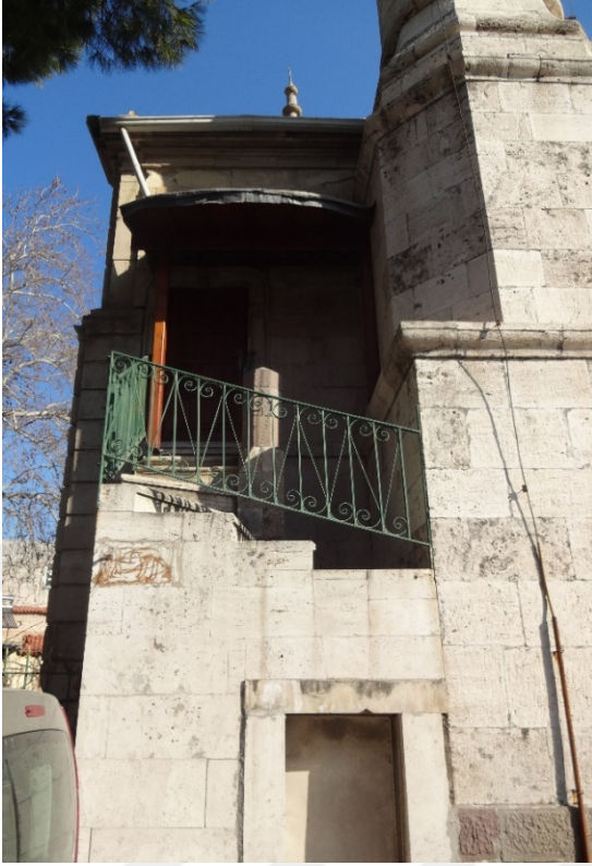
Fot. 145: Kadınlar Mahfili Kapı Açıklığı.
