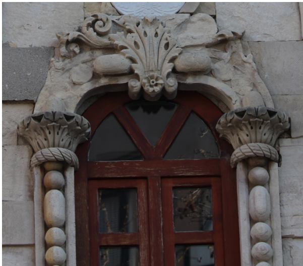
Fot. 97: Kuzey Cephe Aksındaki Düz Kemerli Pencere Detay Görünümü.
