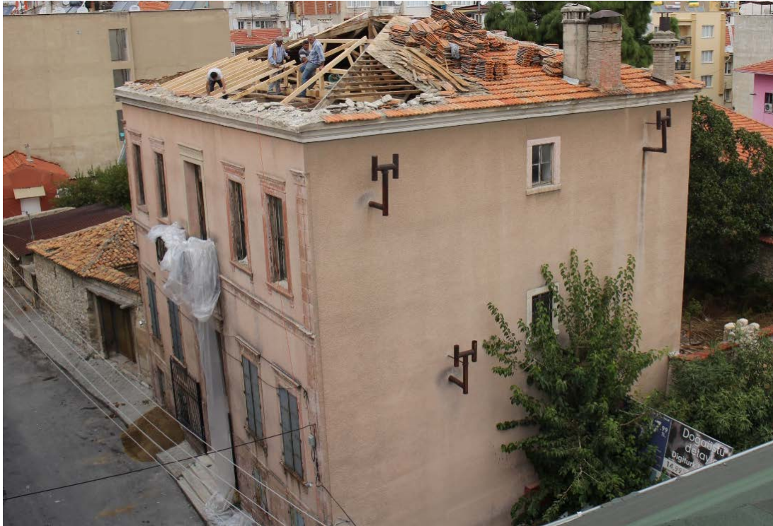
Fot. 222: Güneydoğu Cephe Restorasyon Öncesi Görünümü (Belediye Arşivi).
