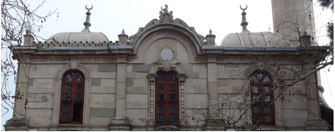
Fot. 96: Kuzey Cephe İkinci Kat Görünümü.
