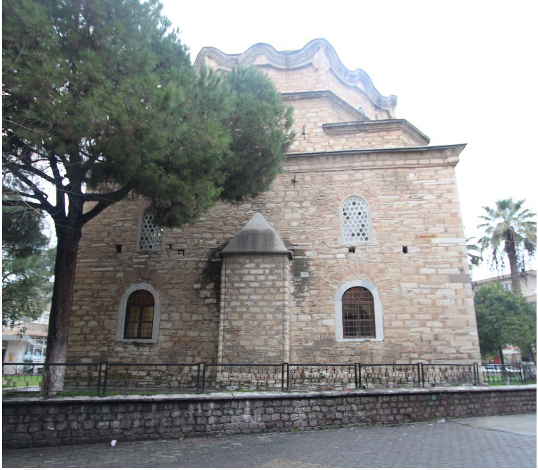
Fot. 6: Güney Cephe Görünümü.
