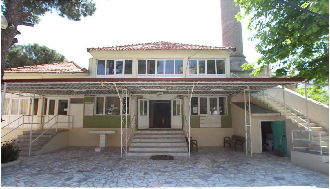
Fot. 69: Kuzey Cephe Görünüm Restorasyon Öncesi Görünümü.
