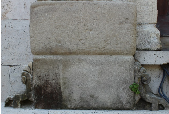
Fot. 86: Plaster Kaidesindeki "S" Kıvrımlı Süsleme Detayları.
