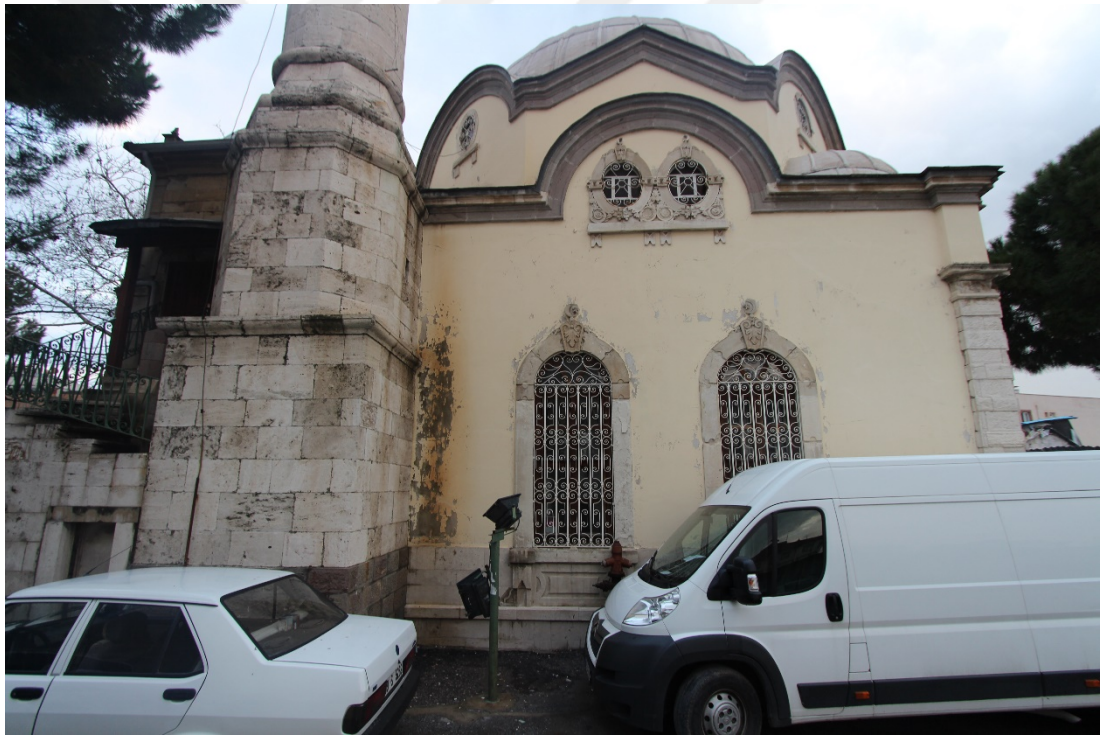
Fot. 90: Batı Cephe Görünümü.
