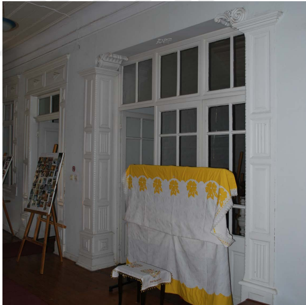
Fot. 258: Birinci Kat Düz Kemerli Açıklık.
