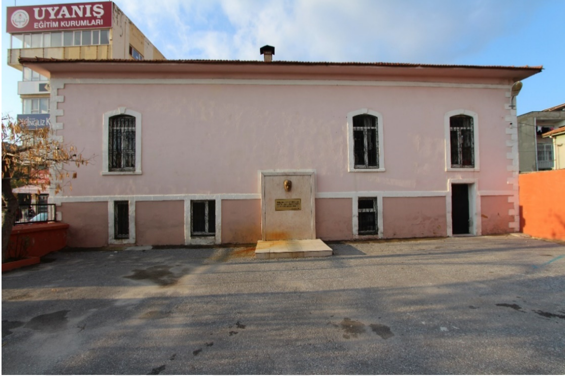
Fot. 270: Güney Cephe Görünümü.
