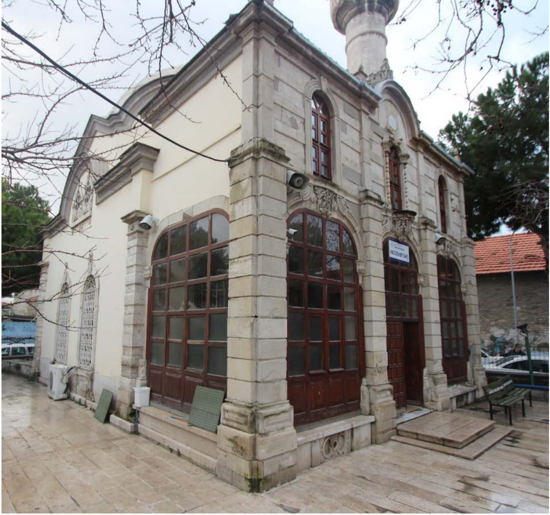
Fot. 81: Kuzeydoğu Cephe Görünümü.
