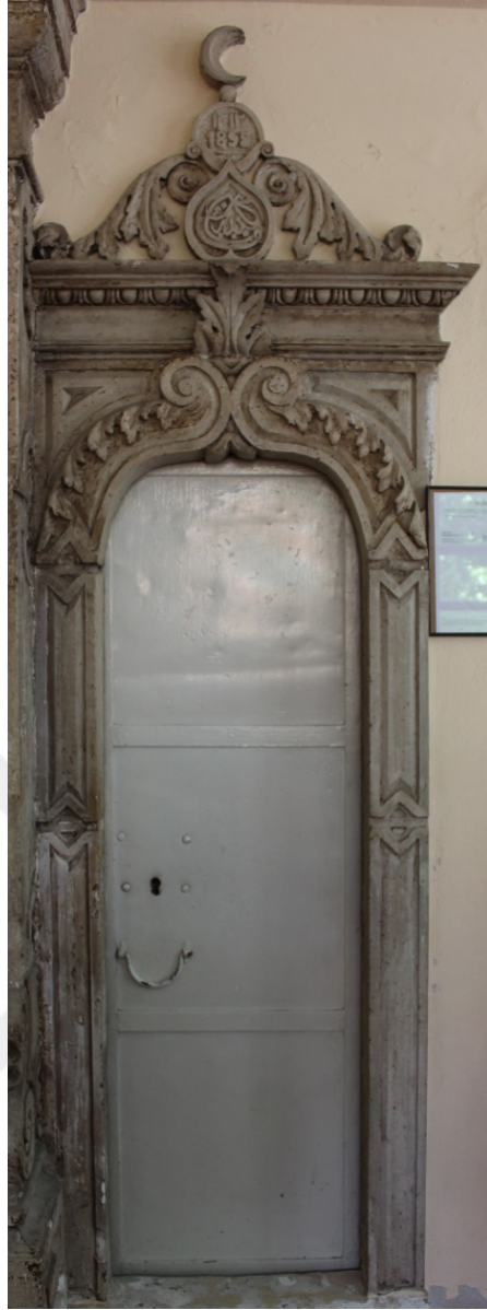
Fot. 103: Minare Kapı Açıklığı Görünümü.
