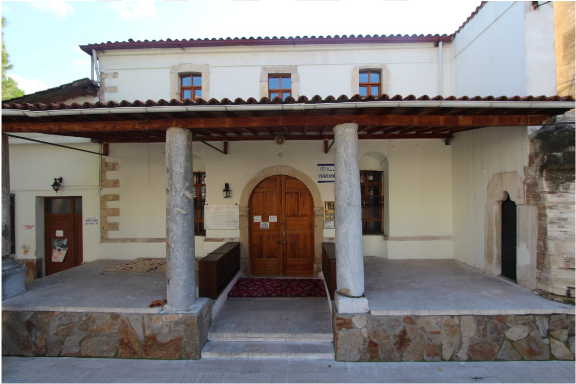
Fot. 46: Kuzey Cephe Onarım Sonrası Görünümü.
