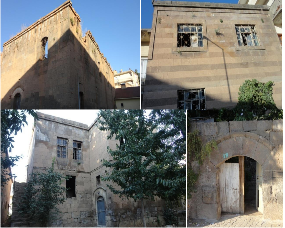
Ek 32- Herson Mahallesiinde 1885 tarihinde yapılmış kilise, okul ve yanında papaz evi.
