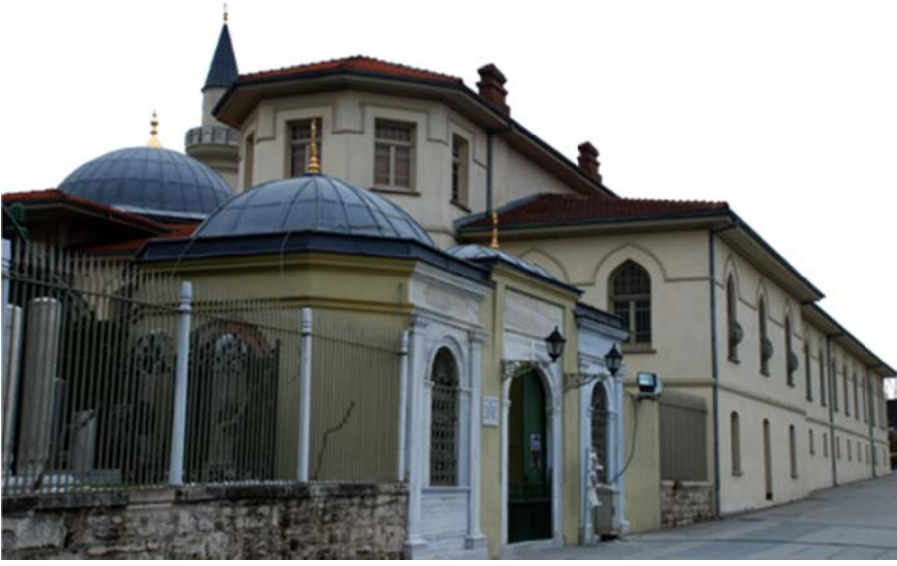
Resim 4. Yenikapı Mevlevihanesi yeni hali (Dışardan görünümü)
