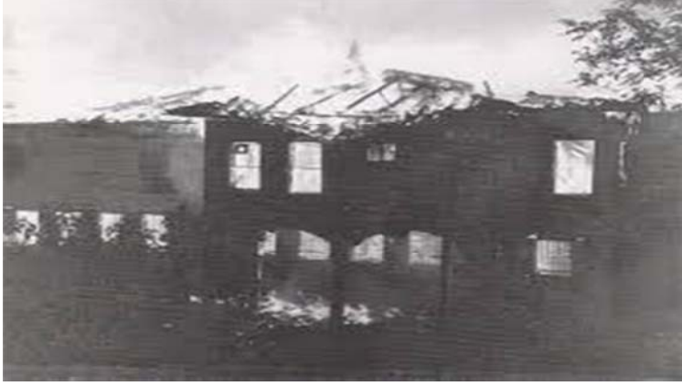
Resim 1. Yenikapı Mevlevîhânesi Yangını
