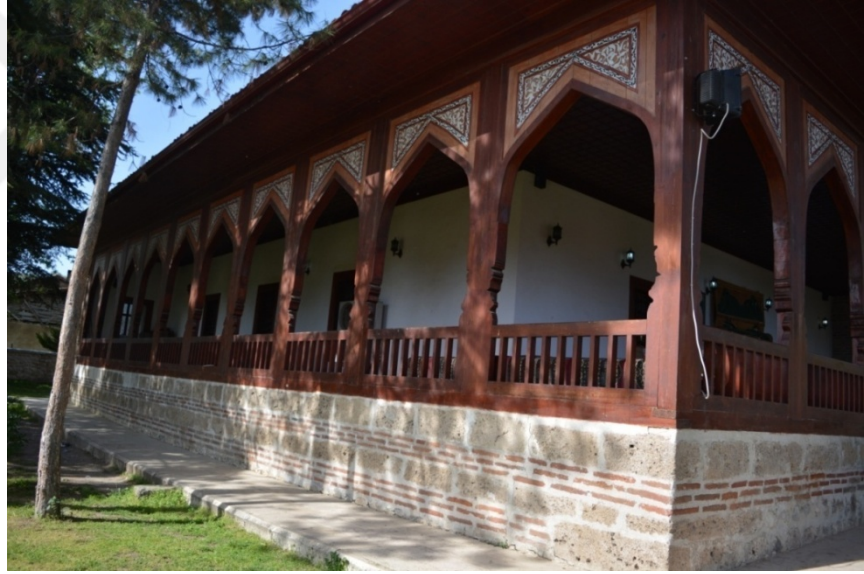
Fotoğraf 25. Doğu Cephesi Platformu
