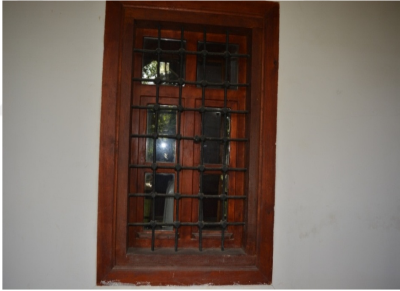
Fotoğraf 27. Doğu Cephesi Penceresi
