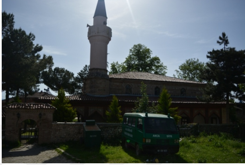
Fotoğraf 31. Batı Cephesi Uzaktan Görünüm
