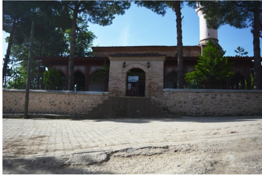
Fotoğraf 19. Kuzey Cephe Genel Görünüm
