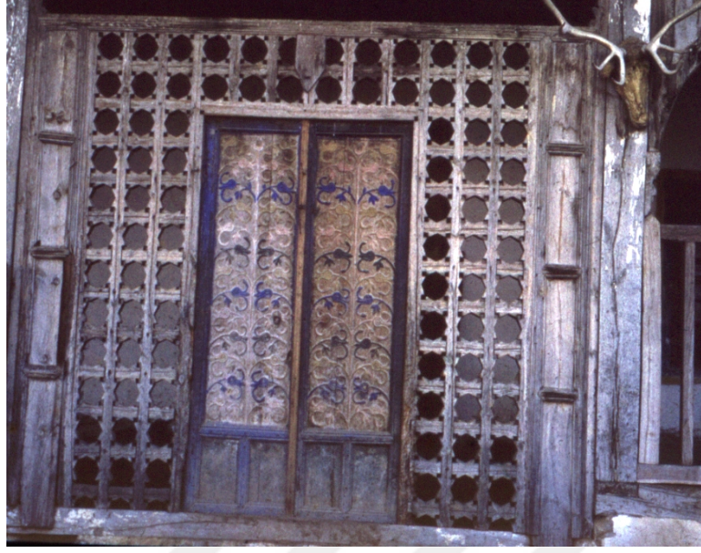
Fotoğraf 12. Giriş Mekanı Kapısı Eski Hali (Vakıflar Genel Müdürlüğü Arşivi)
