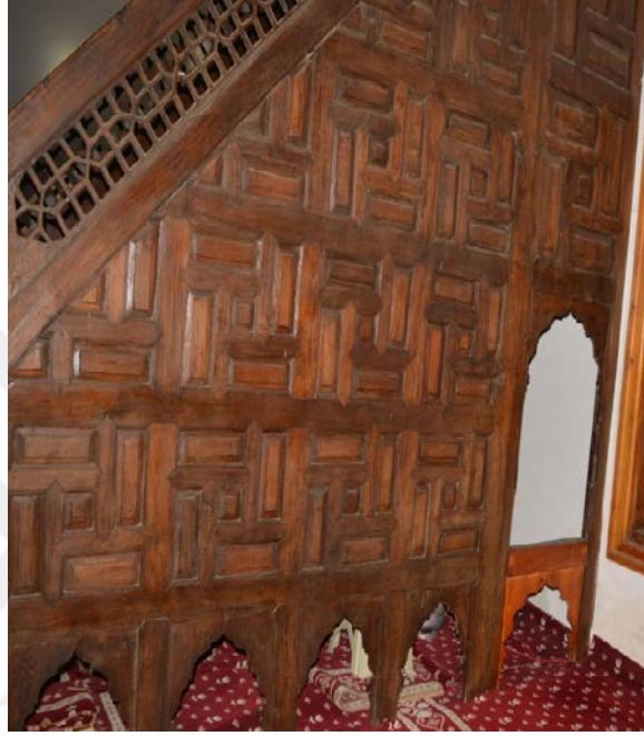
Fotoğraf 138. Silahtar Ömer Paşa Camisi Kündekari Tekniğinde Yapılmış Minber
