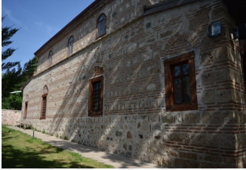
Fotoğraf 54. Güney Cephe Pencereleeri
