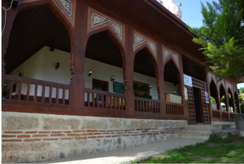
Fotoğraf 21. Kuzey Cephe
