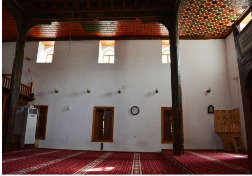
Fotoğraf 43. Doğu Cephe Pencereleeri
