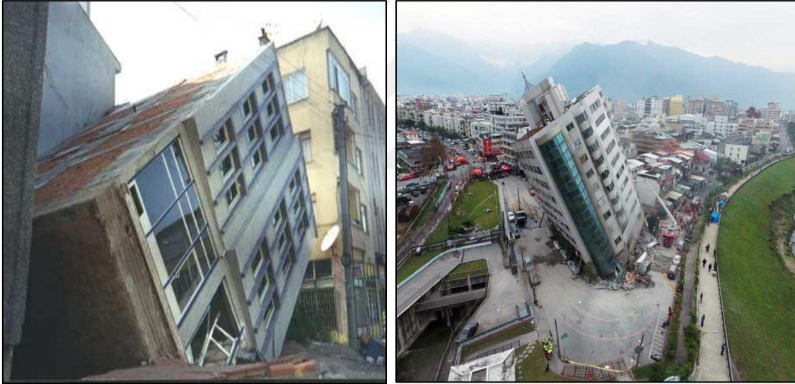
Resim 2.3 1999 Kocaeli (İzmit) depremi sırasında Adapazarında sıvılaşma etkisi ile hasar görmüş yapılar (Manav vd. 2019).
