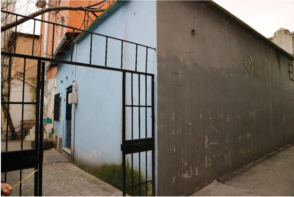
Fotoğraf 5: Fesahat Usta Çeşmesi Kuzeybatı Cephesi
