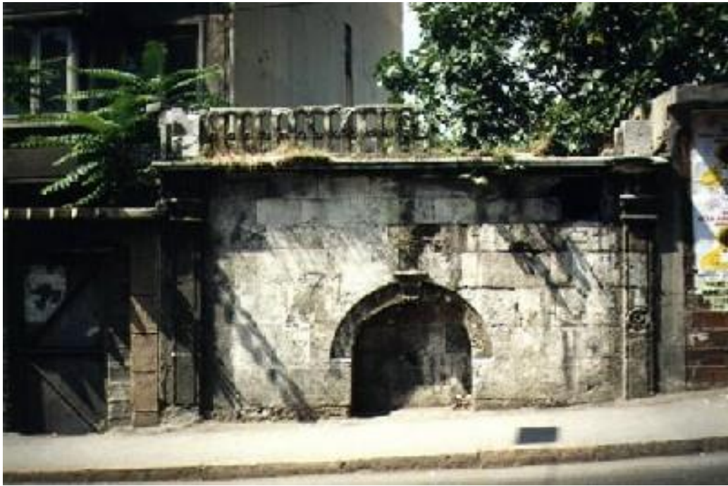
Fotoğraf 9: Paşa Baba Çeşmesi Restorasyon Öncesinden Görüntü (Su Vakfı'ndan)
