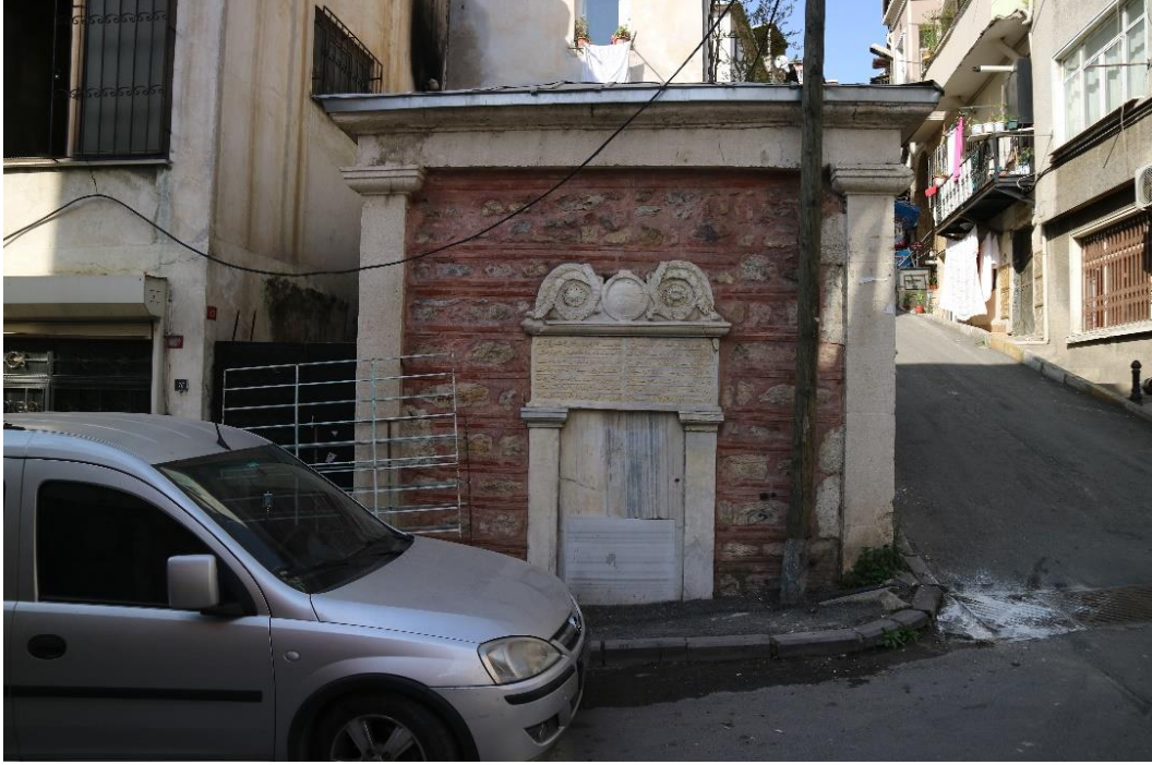
Fotoğraf 67: Abdülmecid Han Çeşmesi (Taksim Çeşmesi) Güneybatı Cephesi
