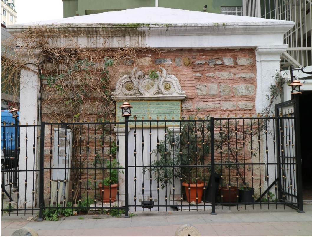
Fotoğraf 61: Abdülmecid Çeşmesi (Valide Çeşmesi) Kuzeybatı Cephesi
