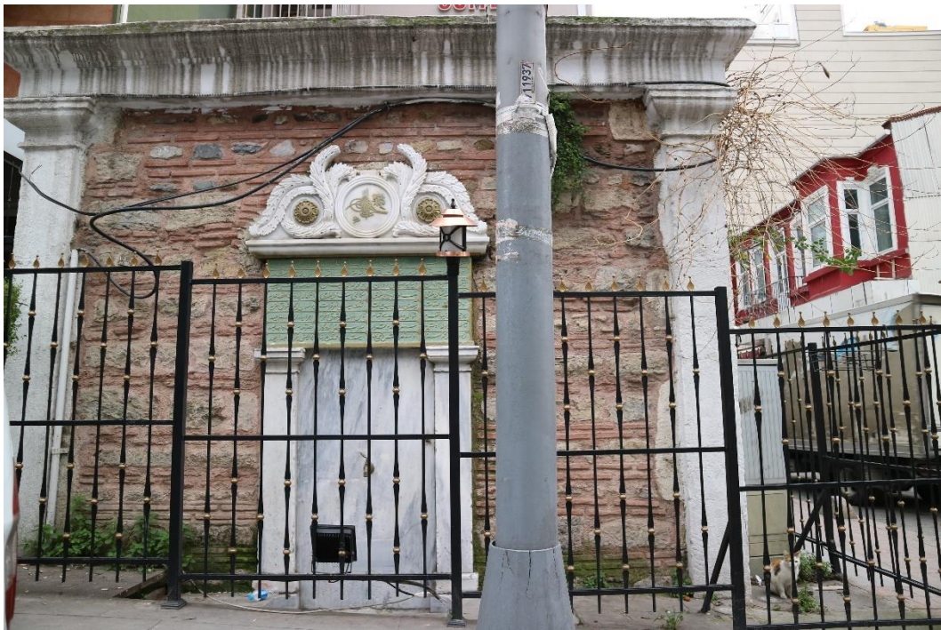
Fotoğraf 62: Abdülmecid Çeşmesi (Valide Çeşmesi) Kuzeydoğu Cephesi
