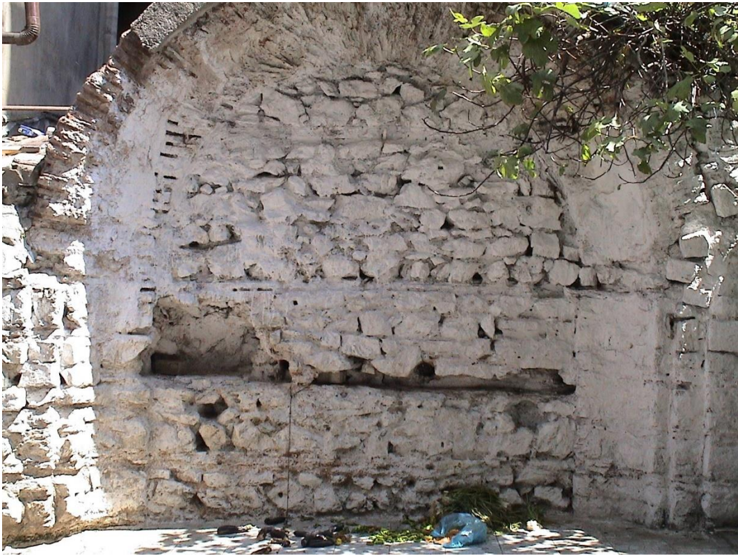
Fotoğraf 30: II. Mahmut Çeşmesi Restorasyon Öncesi Görünüşü (Beyoğlu Belediyesi'nden)
