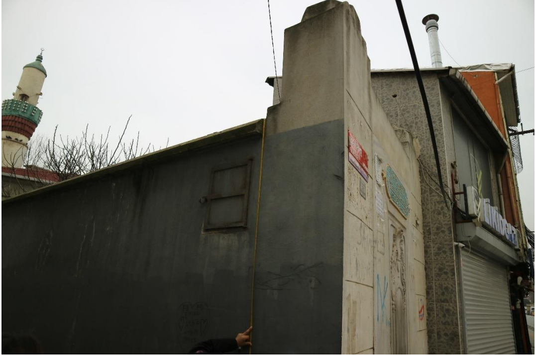
Fotoğraf 4: Fesahat Usta Çeşmesi Güneybatı Cephesi
