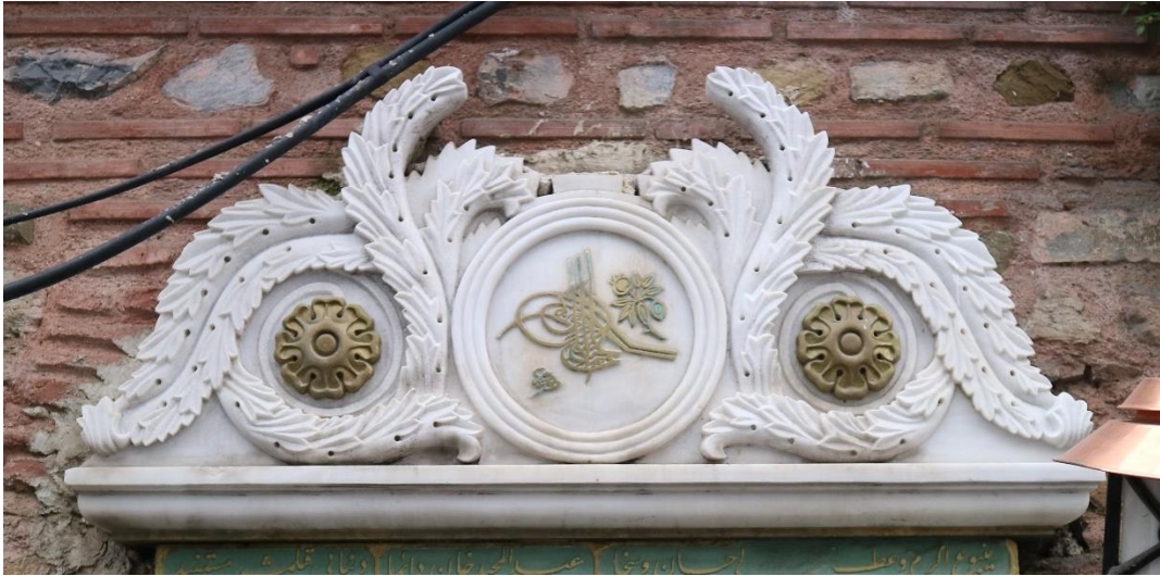
Fotoğraf 64: Abdülmecid Çeşmesi (Valide Çeşmesi) Kuzeydoğu Cephesi Madalyon ve Süsleme Ayrıntısı
