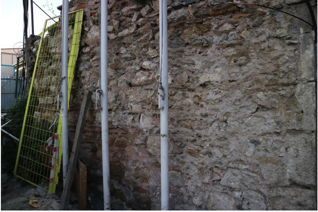
Fotoğraf 12: Paşa Baba Çeşmesi Güneybatı Cehesi
