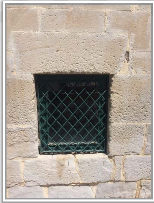
Fotoğraf 21: Güney Cephesindeki Dikdörtgen Pencere
