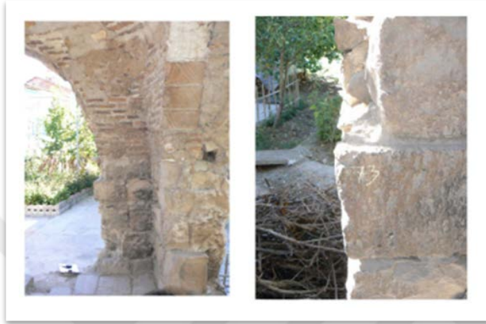
Fotoğraf 45: Kemer Düzeyine Kadar Kesme Taş ve Kemer Devamında Tuğla (MVBM 2006)
