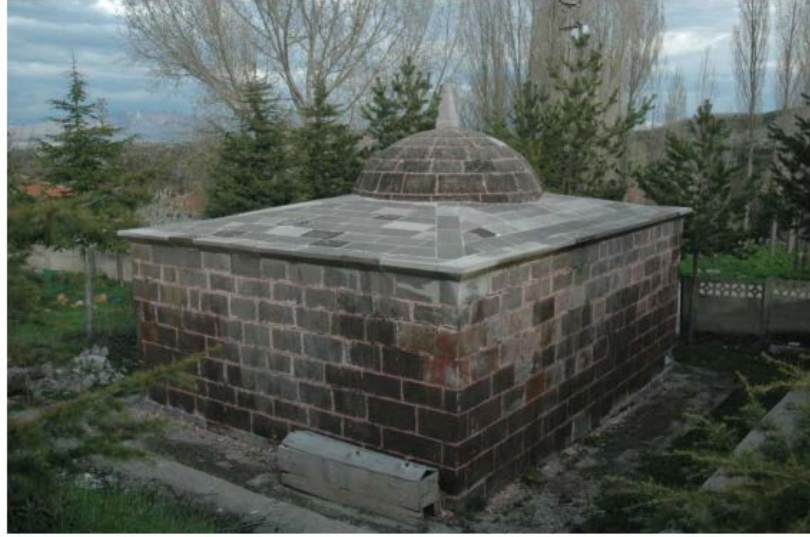
Fotoğraf 98: Kayseri Sancaktar Türbesi Kubbenin Dıştan Görünümü (Gündoğan 2015)
