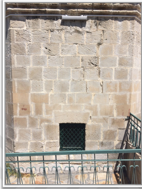
Fotoğraf 14: Restorasyon Sonrası Pencere ve Zemin
