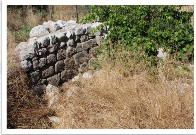
Fotoğraf 26: Üç Kardeşler Türbesi Güneybatı Duvarı
