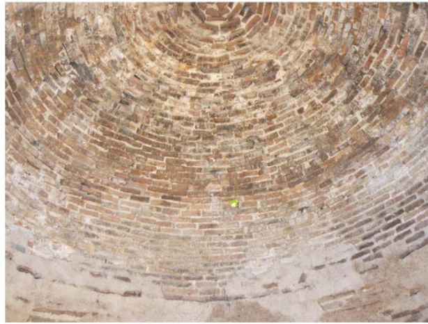
Fotoğraf 45: Kemer Düzeyine Kadar Kesme Taş ve Kemer Devamında Tuğla (MVBM 2006)
