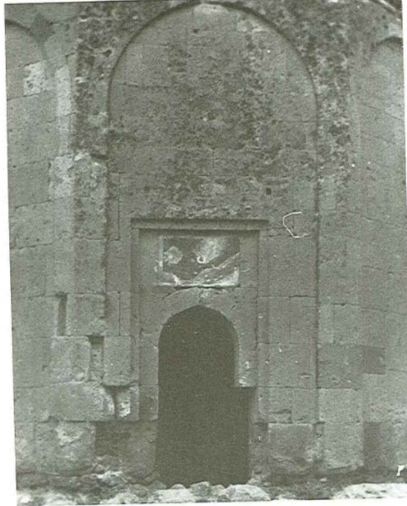
Fotoğraf 59: Aksaray Bekar Sultan Türbesi Batı Cephesindeki Giriş Kapısı (Önkal 1996)
