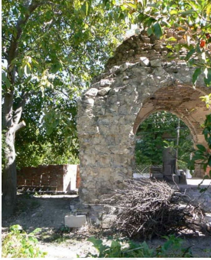
Fotoğraf 40 : Restorasyon Öncesi Güneydoğu Köşesi (MVBM 2006)
