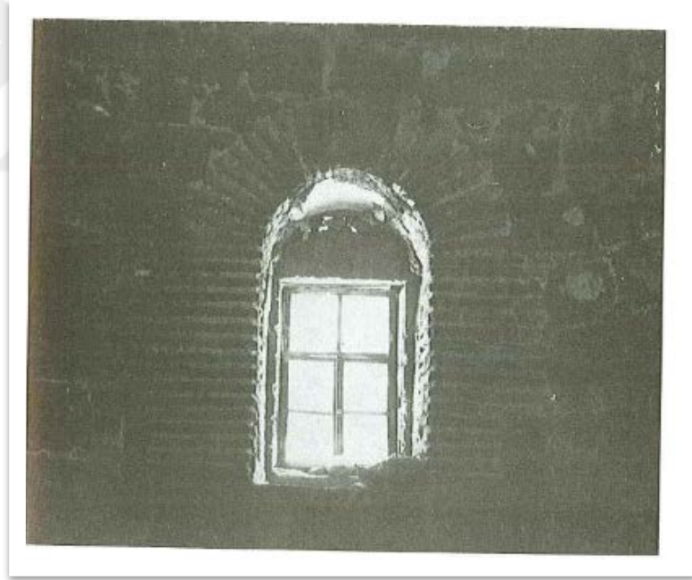
Fotoğraf 74: Tunceli Elti Hatun Türbesi'nin İçten Sivri Kemerli Penceresi (Önkal 1996)
