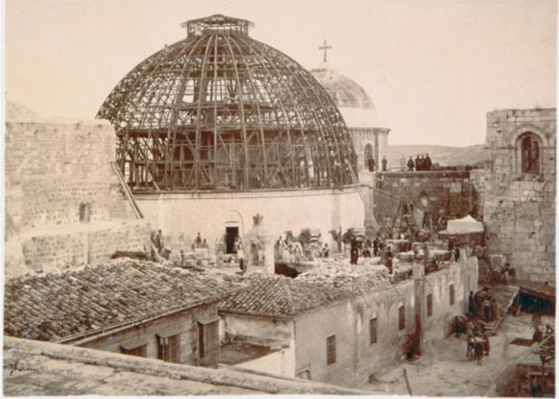
Resim V: Peter Bergheim (1813-95)'ın Kamame Kilisesi'nin Kubbesinin Yeniden İnşası Sırasında Çektiği Fotoğraf 257 .
