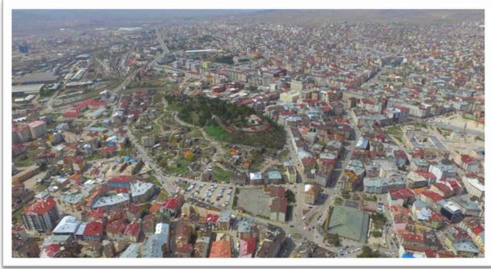
Fotoğraf 23. Sivas Kalesi projesi yıkımlar yapılmadan önceki hali
