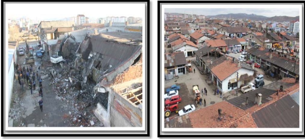
Fotoğraf 27. Eski Sanayi yıkım çalışmaları (Sivas Belediyesi)
