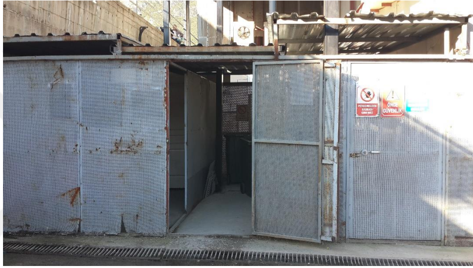
Resim 3.19: ABC Hastanesi Atık Toplama Ekipman Deposu
