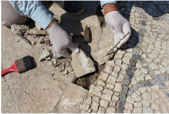
Figür 57: Hasarlı Olan Eski Onarım Harçlarının Temizlenmesi
