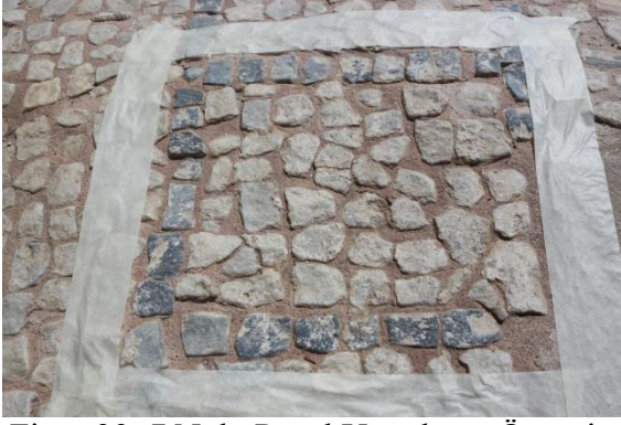
Figür 39: 7 Nolu Panel Uygulama Öncesi Genel Görünüm
