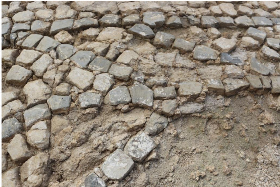
Figür 63: Uygulama Öncesi Genel Görünüm
