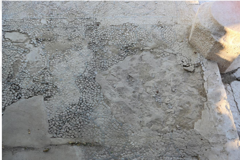
Figür 95: 3 Nolu Panel Uygulama Öncesi Genel Görünüm
