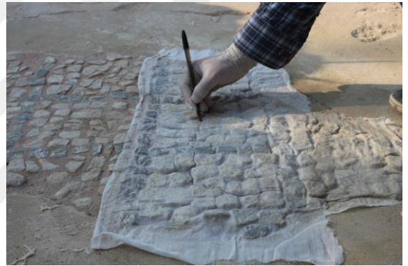
Figür 70: Kaldırılacak Alanın İşaretlenmesi
