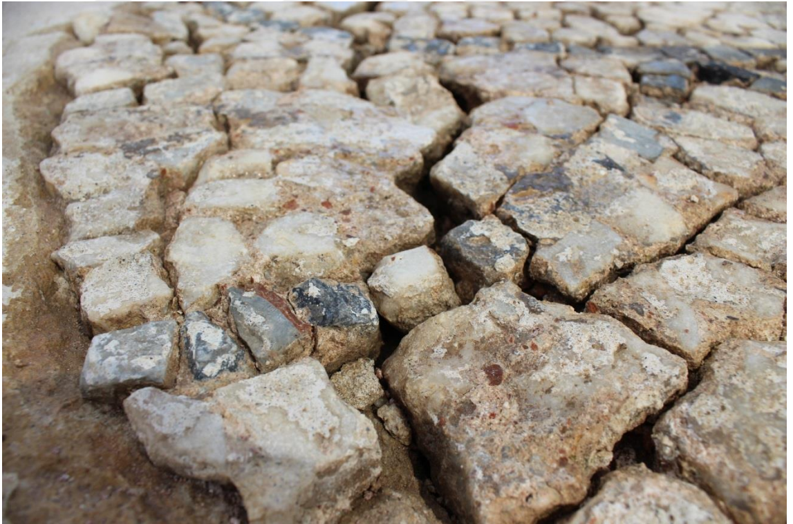
Figür 21: 6 Nolu Panel Çatlama Örneği
