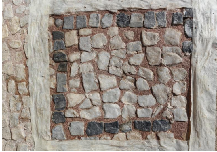
Figür 43: Uygulama Sonrası Genel Görünüm
