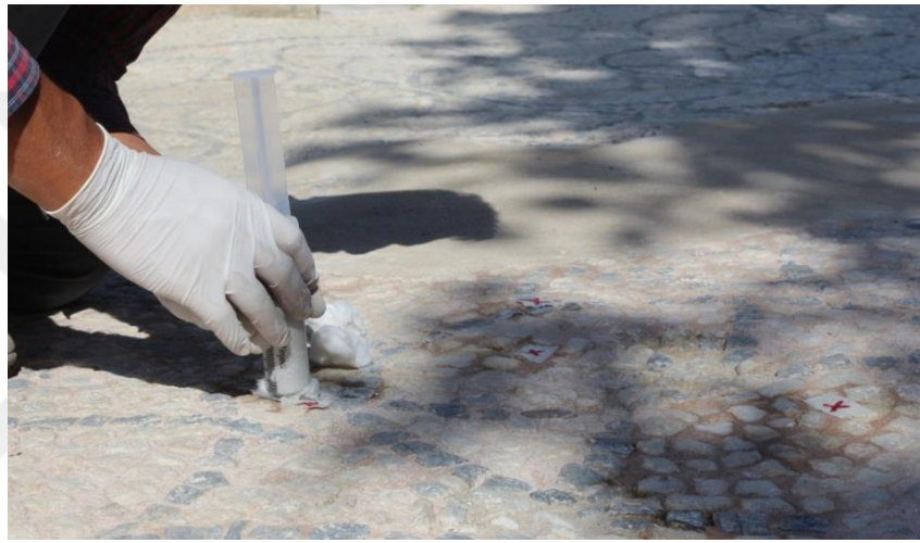
Figür 62: Enjeksiyon Yöntemi ile Mozaik Sağlama Çalışması.
