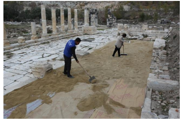
Figür 112: İnce Dere Kumunun Örtü Üzerine Serilmesi
