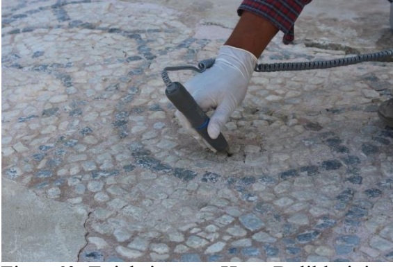
Figür 60: Enjeksiyon ve Hava Deliklerinin Açılması
