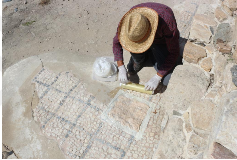
Figür 41: Uygulama Üzerinin Streç film ile Kapatılması
