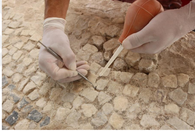
Figür 44. Harç Kalıntılarının Mekanik Temizlik Uygulaması
