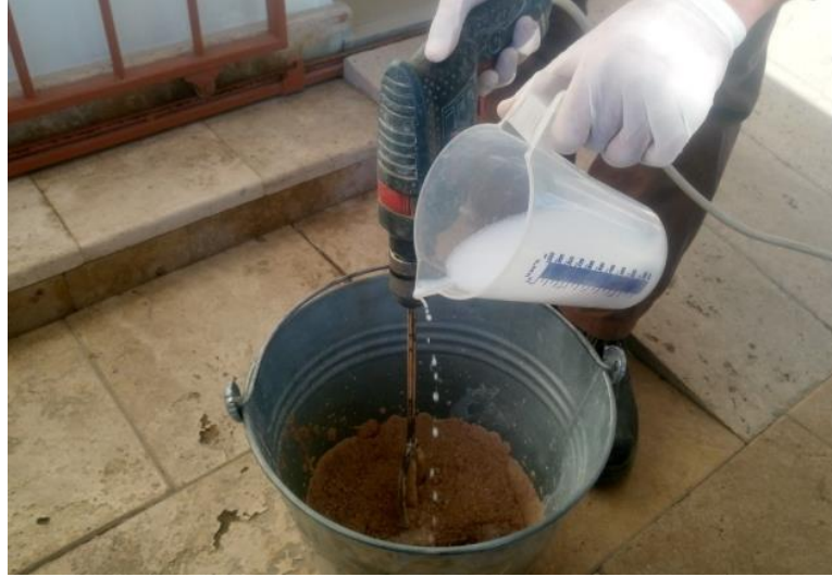
Figür 34: Onarım Harcının Hazırlanması
