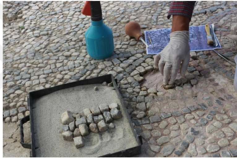
Figür 78: Yatak Harcı Yenilenen Tesseraların Yerlerine Sabitlenmesi
