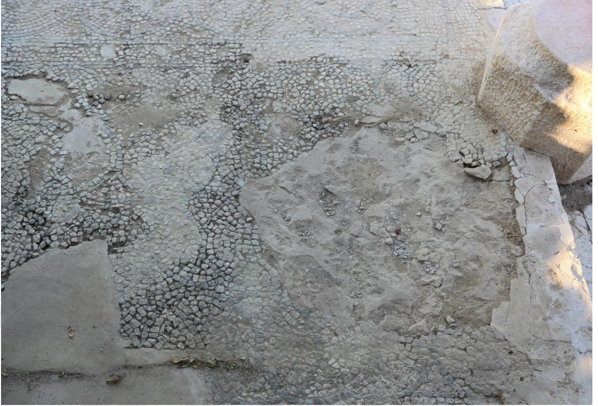
Figür 18: 3 Nolu Panel Harç Yatağından Ayrılmış Tesseralar
