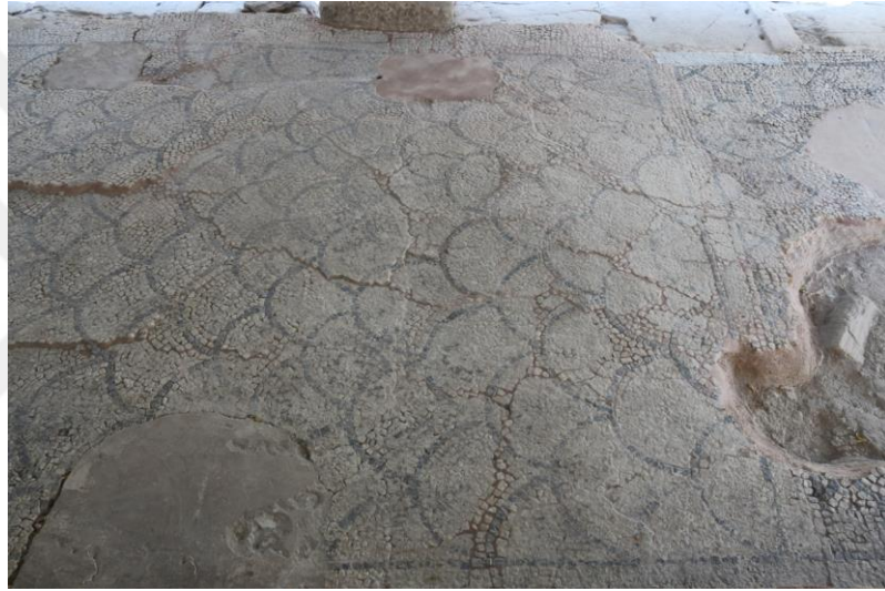
Figür 82: Uygulama Sonrası Genel Görünüm
