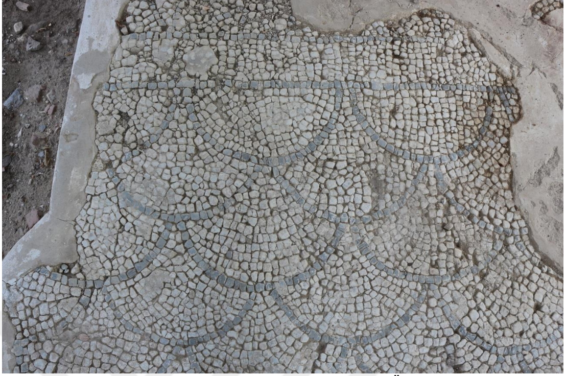
Figür 24: 6 Nolu Panel Derz Bozulması Örneği
