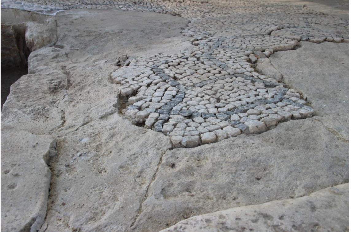
Figür 23: 1 Nolu Panel Çökme ve Yükselme Örneği
