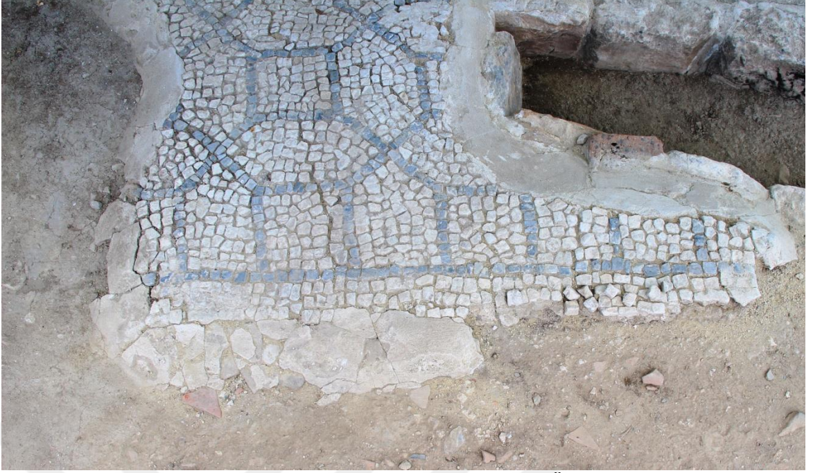
Figür 30: 1 Nolu Panel Bordür Bozulması Örneği
