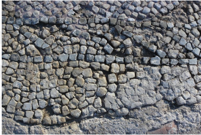
Figür 66: Uygulama Sonrası Genel Görünüm
