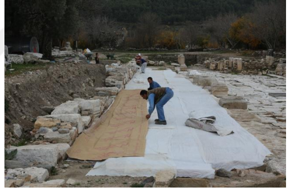
Figür 110: Jeotekstil ve Jeotermal Örtünün Mozaik Yüzeyine Serilmesi
