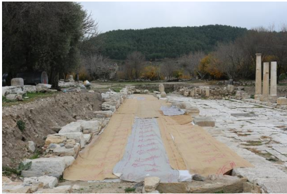
Figür 111: Jeotekstil ve Jeotermal Sonrası Genel Görünüm
