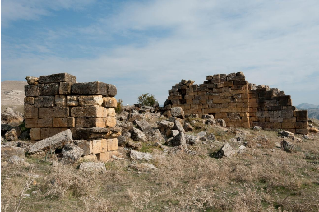
Figür 21. Büyük Hamam Yapısı güneybatıdan görünüm.
