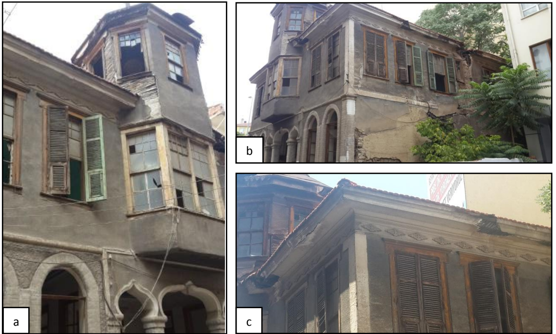
Şekil 3.4a, b, c 218 ada 167 parseldeki yapının fotoğrafları (Kişisel Arşiv, 2016).
