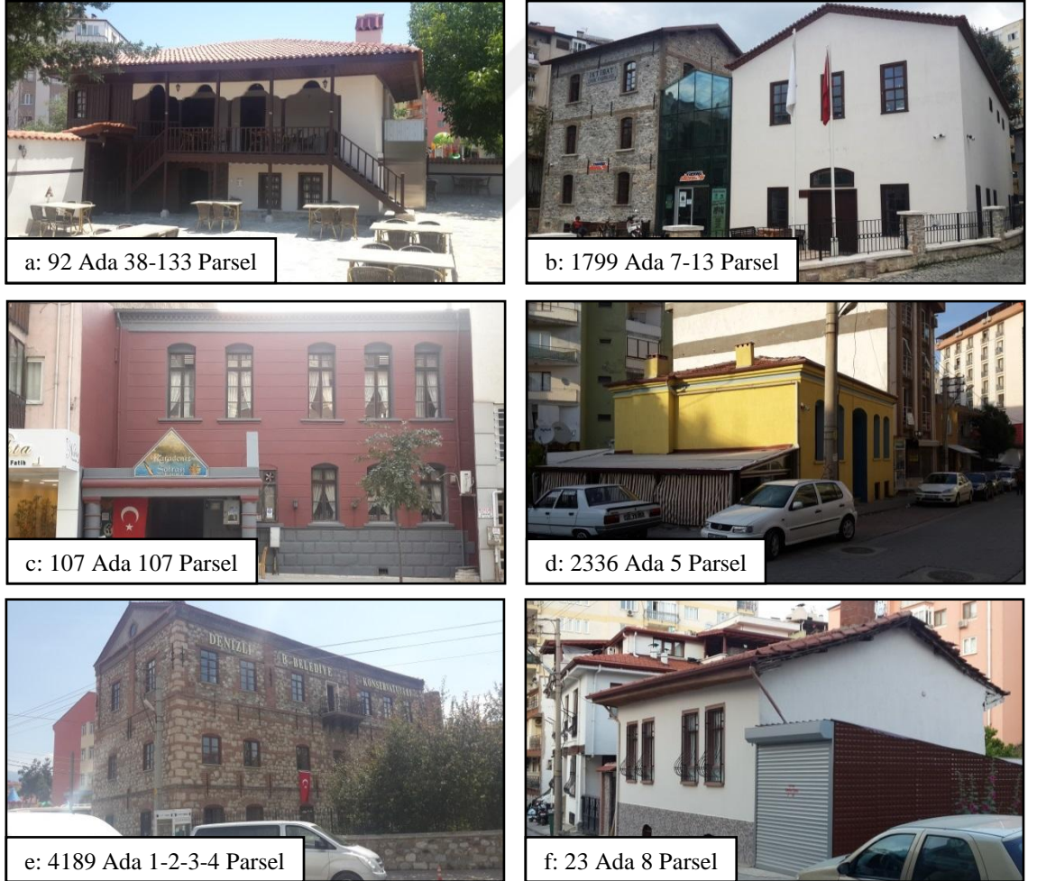
Şekil 3.19 a, b, c, d, e, f Düşük risk altındaki yapılara örnekler (Kişisel arşivden, 2015).
