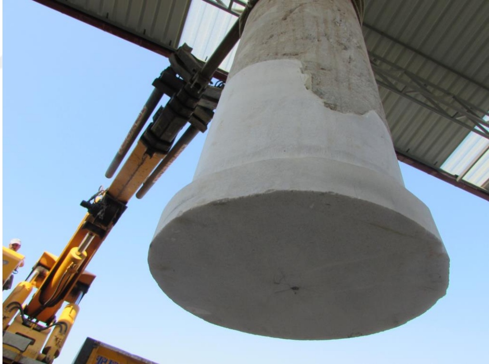
Fig. 72: Pantografi Yapılan Sütunun Vinç Yardımıyla Yerleştirilmesi
