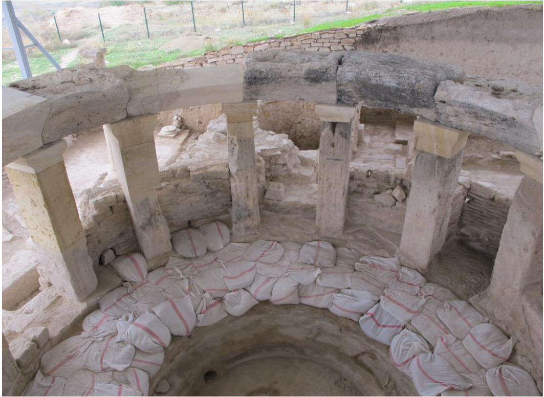
Fig. 64: Yerde Döküm Tekniği İle Tümeleme Çalışması Yapılan Arşitrav
