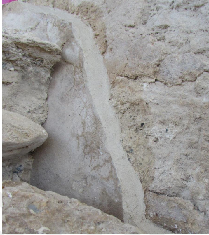
Fig. 89: Sıvaların Konservasyonu Tamamlanmış Hali
