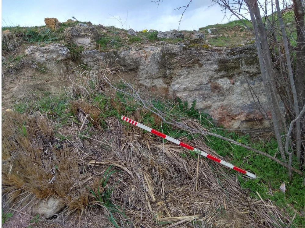
Fig. 100: Hamamın(?) Kuzeyinde Tespit Edilen Duvar
