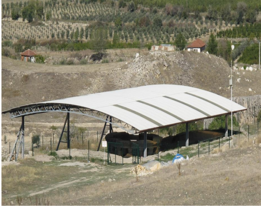
Fig. 94: Yapının Koruma Çatısıyla Üstünün Kapatılmış Hali
