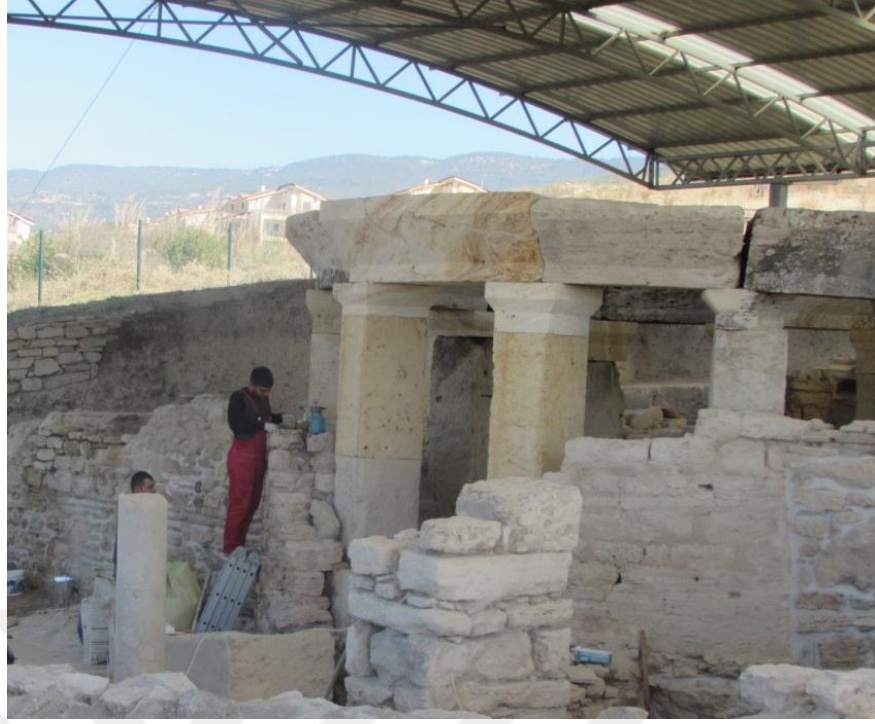
Fig. 85: Payeler Arasında Yer Alan Duvar ve Sivalar
