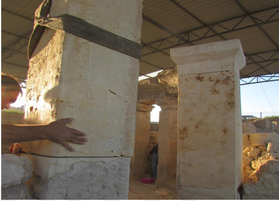
Fig. 61: Yeni Traverten Blokların Yerleştirilmesi
