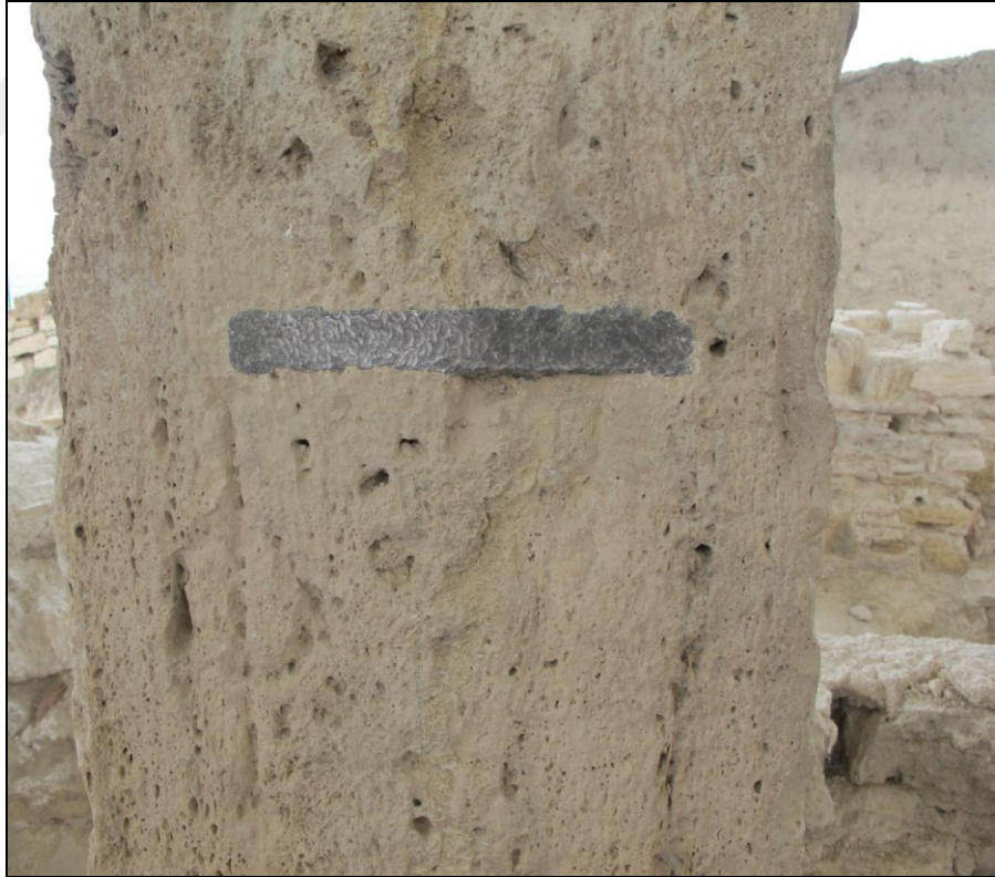
Fig. 62: Payeye Ters U Formlu Krom Çelik Yerleştirilmiş Hali
