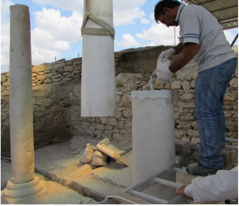
Fig. 73: Pantografi Yapılan Sütunun Yerine Montaj Aşaması
