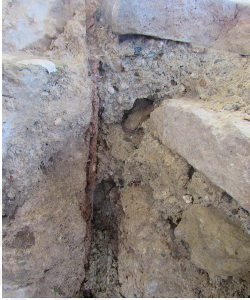
Fig. 11: Portiğın Doğusundaki Duvarda Gözlenen Sıva İzi Detay
