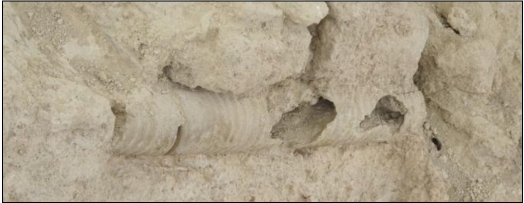
Fig. 127: Dikdörtgen Planlı Mermer Kaplama Havuzdaki Duvardan Isıtma Sistemi
