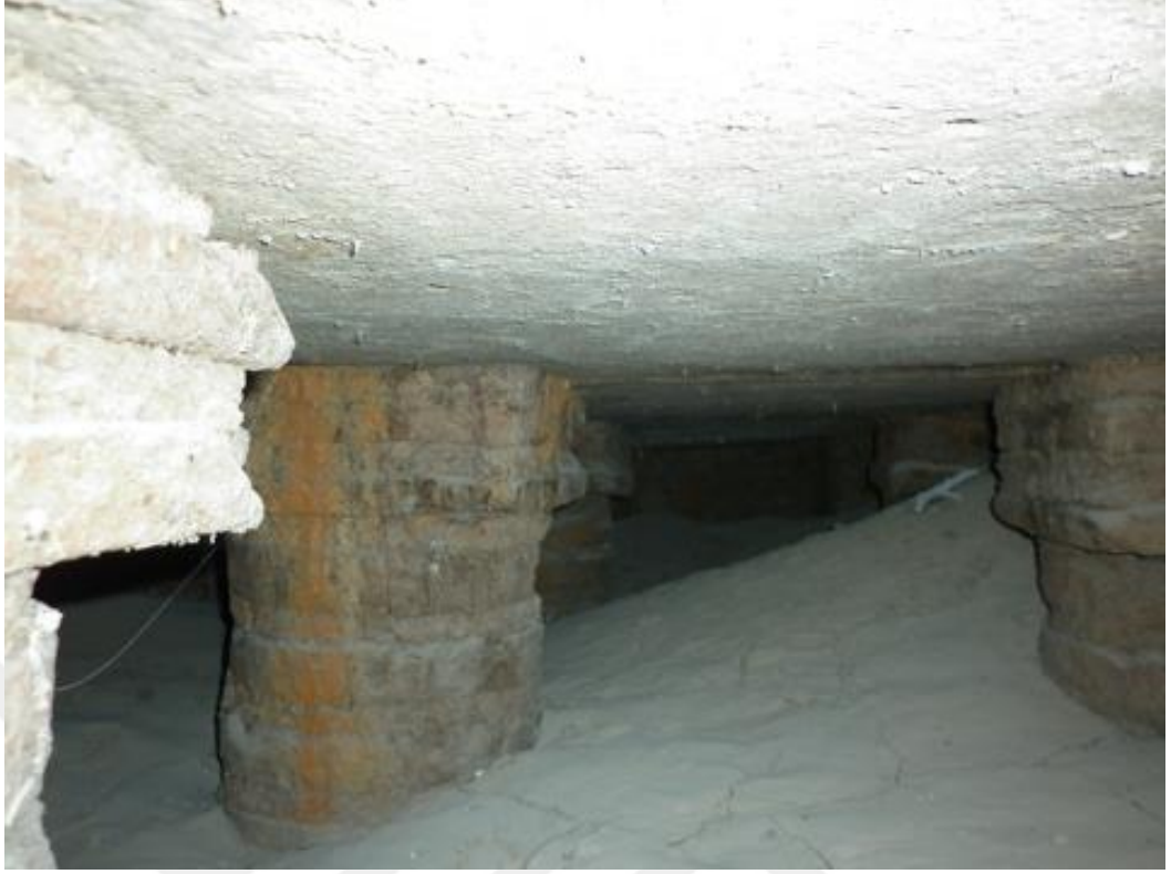
Fig. 13: Hypocaust Sistemi Temizlik Öncesi
