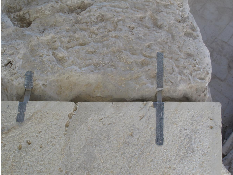
Fig. 70: U formlu Krom Çelik Çubuklar ve Kurşun Dökülmüş Hali
