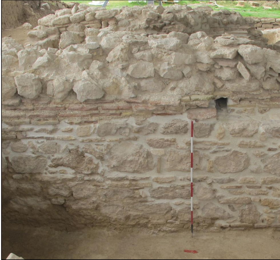
Fig. 135: Calidariumun Doğu Duvarı
