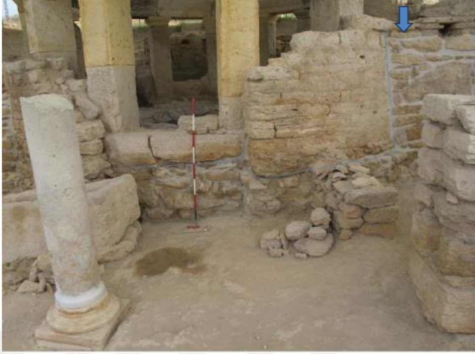
Fig. 130: Yapının Farklı Dönemlerde Restore Edildiğini Gösteren Duvarlar
