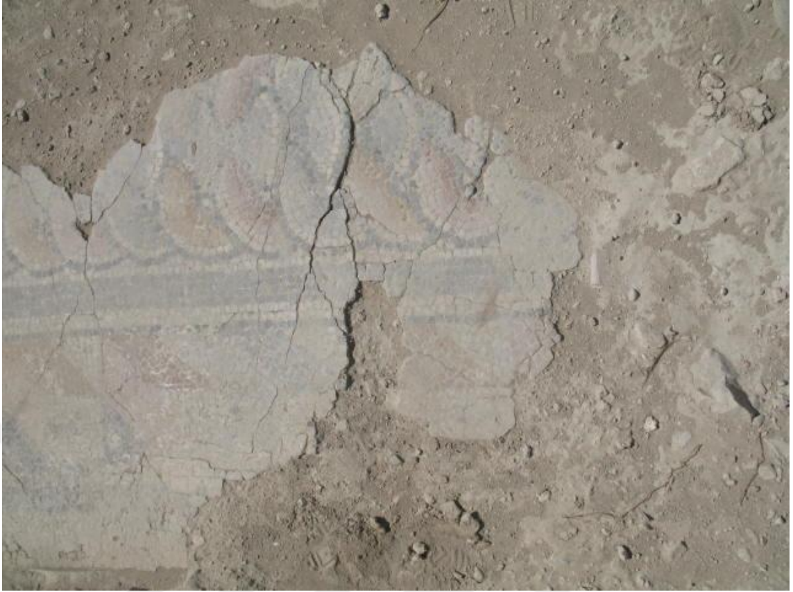
Resim 11: Çatlak Bozulma Örneği
