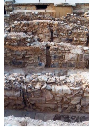
Figür 53 a-b: Knossos Sarayı kesme taş ve moloz taş duvar.
