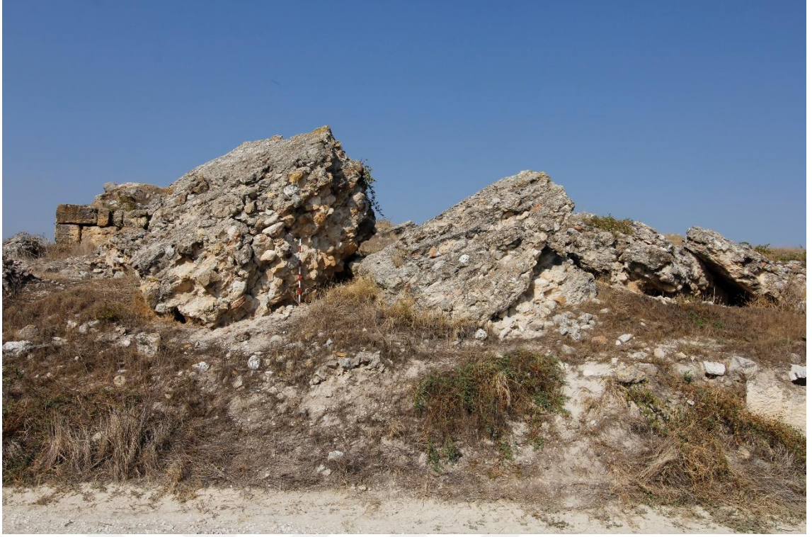
Fig.25: Bouleuterion Güneyindeki Yıkıntı.
