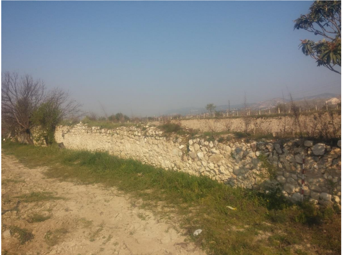
Fig.68b: Azmakkaşı Mevki Çevre Surunun Güney Cephesi.
