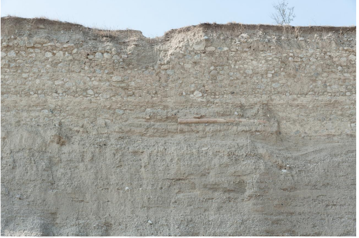
Fig.77c: Çayınkaşı Mevkisi Çevre Surunun Doğu Cephesinde Yer Alan Künk Sistemi.
