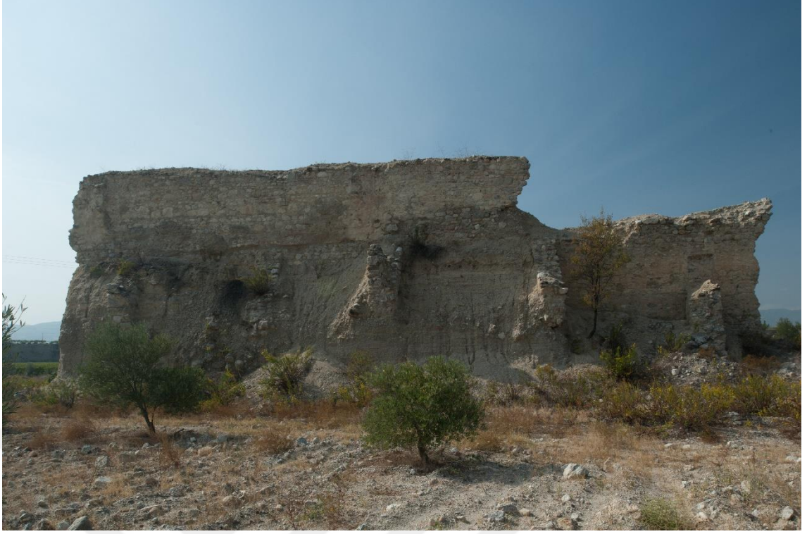
Fig.78b: Çayınkaşı Mevkisi Çevre Surunun Payandalı Doğu Cephesi.
