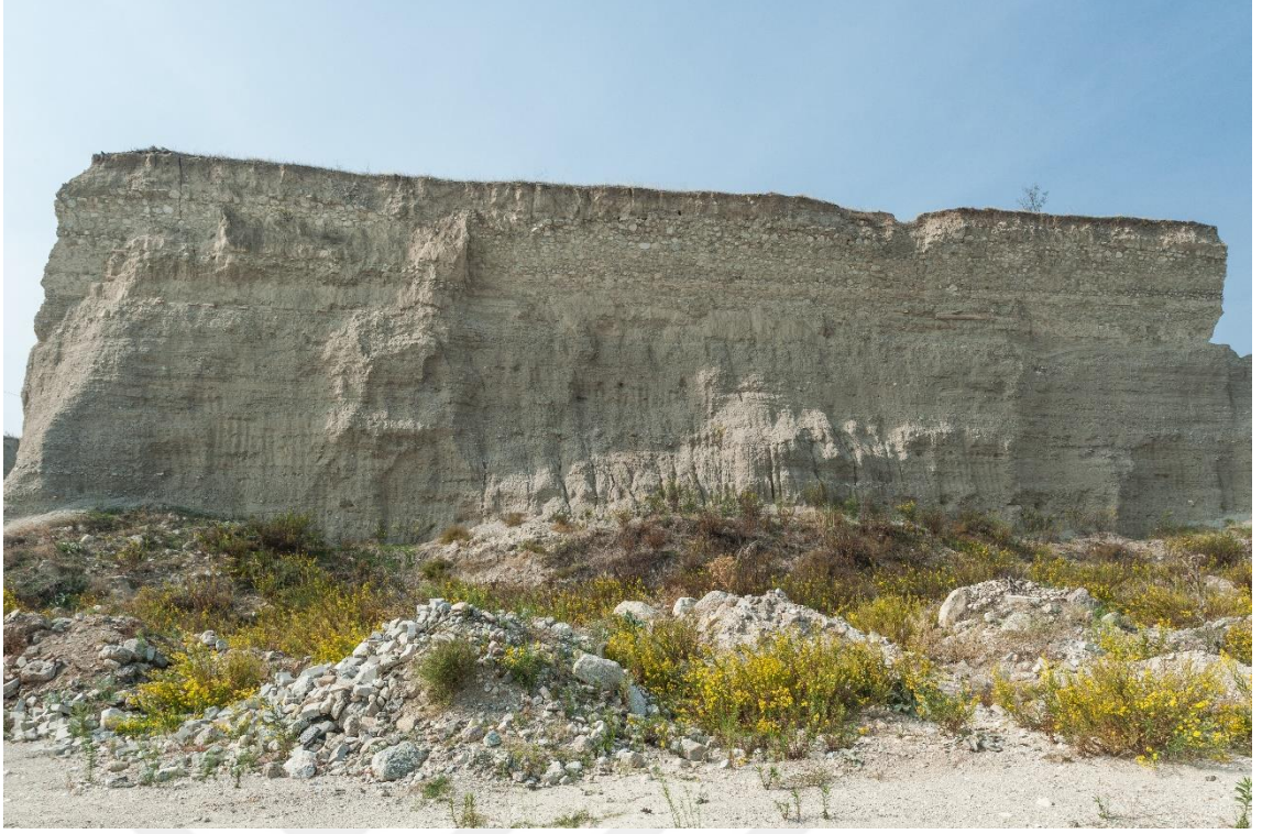
Fig.77a: Çayınkaşı Mevkisi Çevre Surun Doğu Cephesi.
