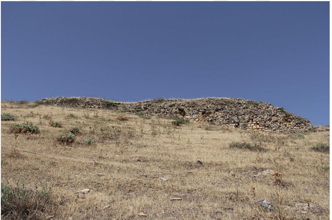
Fig.12: Erken Bizans Doğu Surları, Doğu Cephe.
