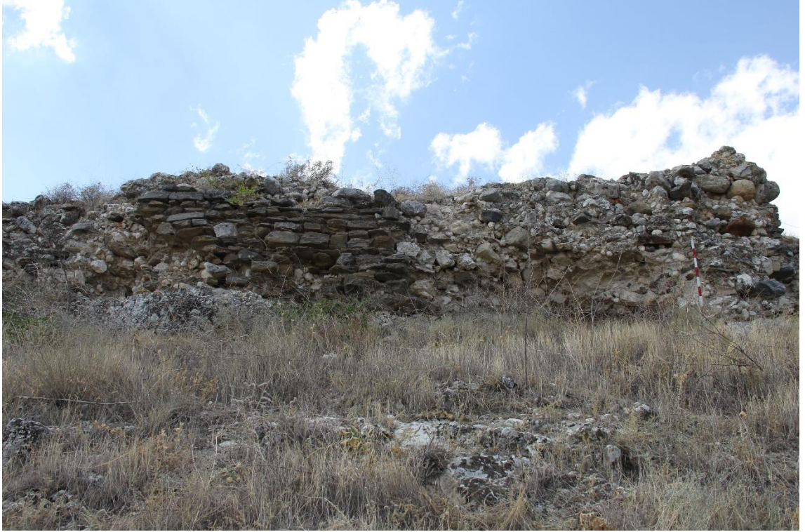
Fig.50b: Dış Yüzünün Kayrak (Şist) Taşlarla Örüldüğü Kuzeydoğu Savunma Duvarı ve İskele Delikleri.
