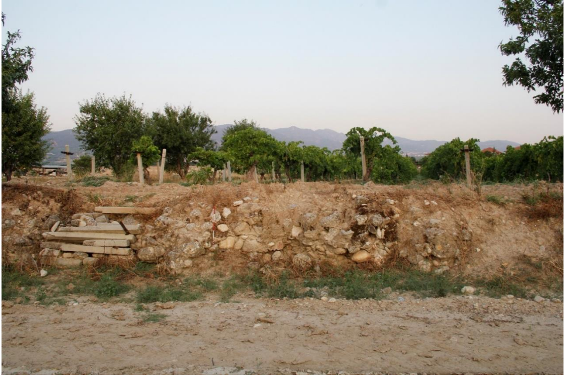
Fig.43: Tarlalar Arasında Sınır Olarak Kullanılan Güneybatı Köşedeki Geç Bizans Surun Doğu Cephesi.
