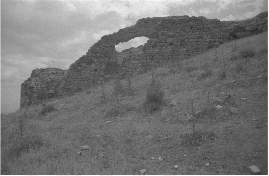
Fig.9b: Erken Bizans Doęu Surlarının Bir Kısımının Yıkılmadan Önceki Görünüşü (DAI, 1988).
