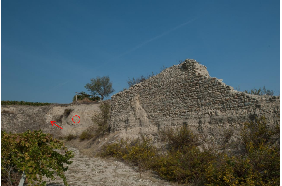
Fig.79a: Çayınkaşı Mevkisi Kuzeydeki Surun Batı Cephesi, Kuzeye Doğru Devamında Duvarın Doğusunda Künk Sistemi.
