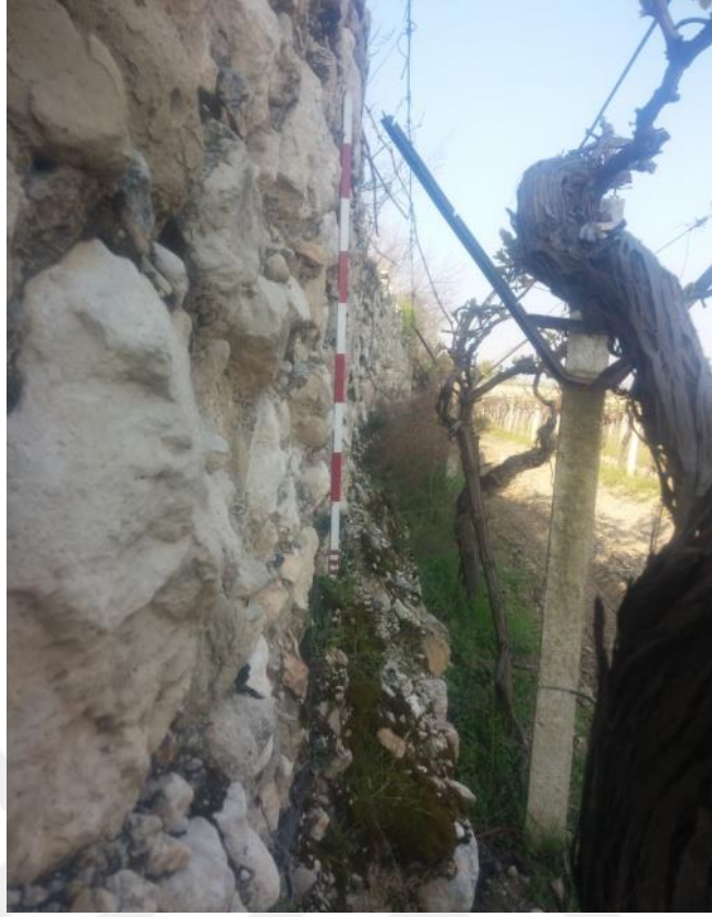
Fig.68e: Azmakkaşı Mevki Surunun Kuzey Cephesindeki Çıkıntı.
