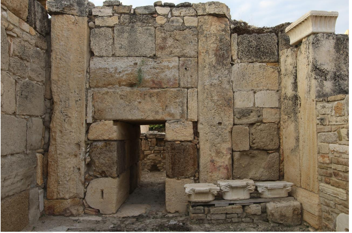
Fig.21a: Erken Bizans Kilisesi 4 Narteks Güney Duvarı ve EKL8'e Giriş.
