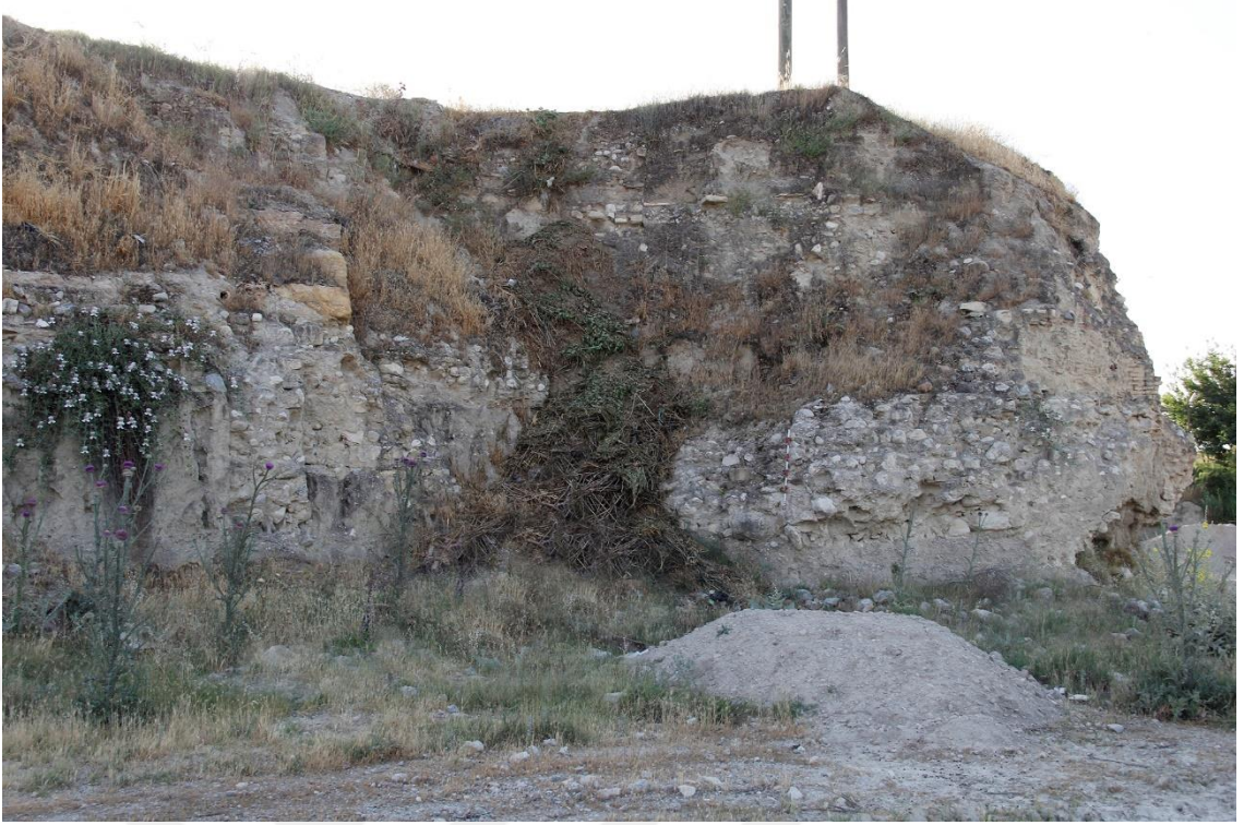
Fig.86a: I. Derece Sit Alanı Dışında Yenicekent Mahallesi Sınırları İçindeki Su Yapısı.
