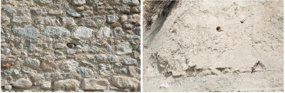
Fig.79c-d: ayınkaşı Mevkisi Surunda İskele Deliđi ve Künk Sistemine Ait Bir Künk.
