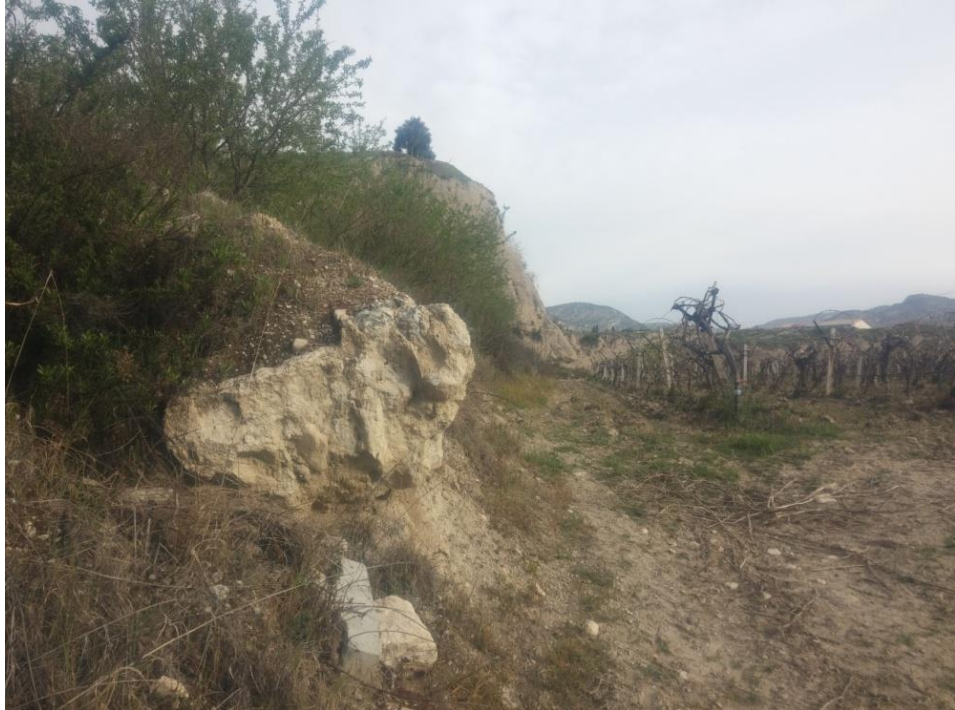
Fig.74: Sođuk Hava Deposu Dođusunda Bulunan Çevre Sur Parçası.
