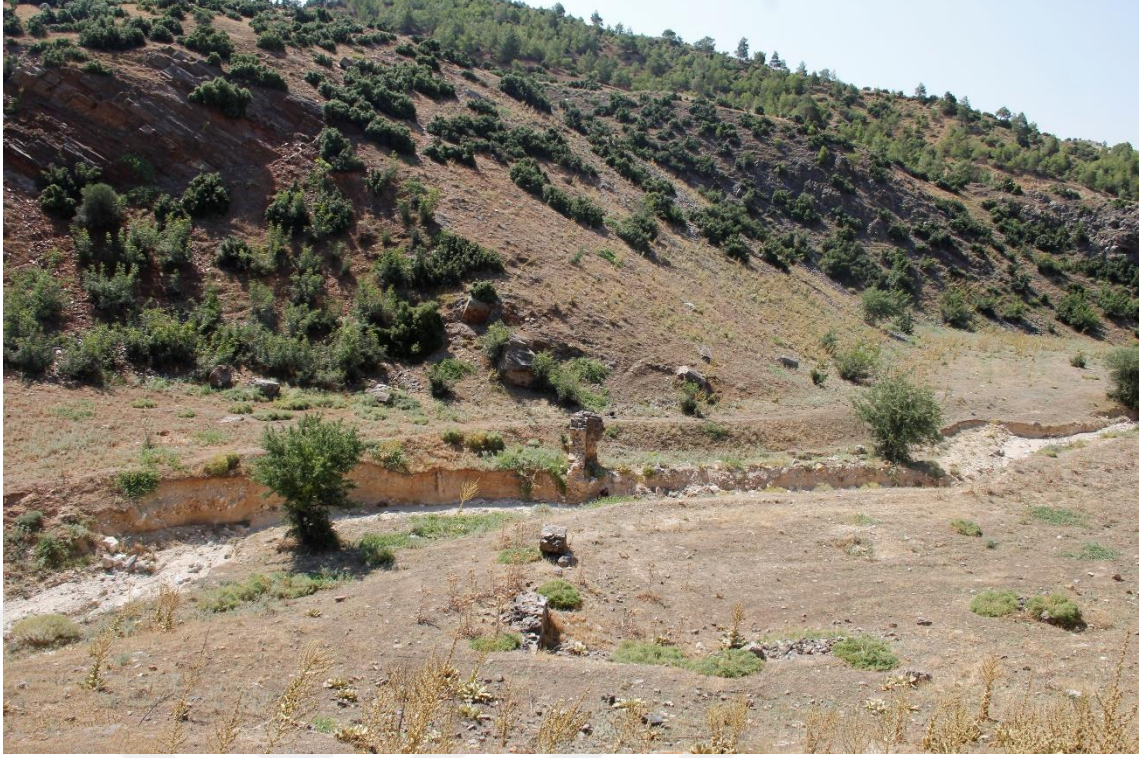
Fig.85a: Tripolis'in Kuzeybatısında Yer Alan Su Kemer Kalıntısı.
