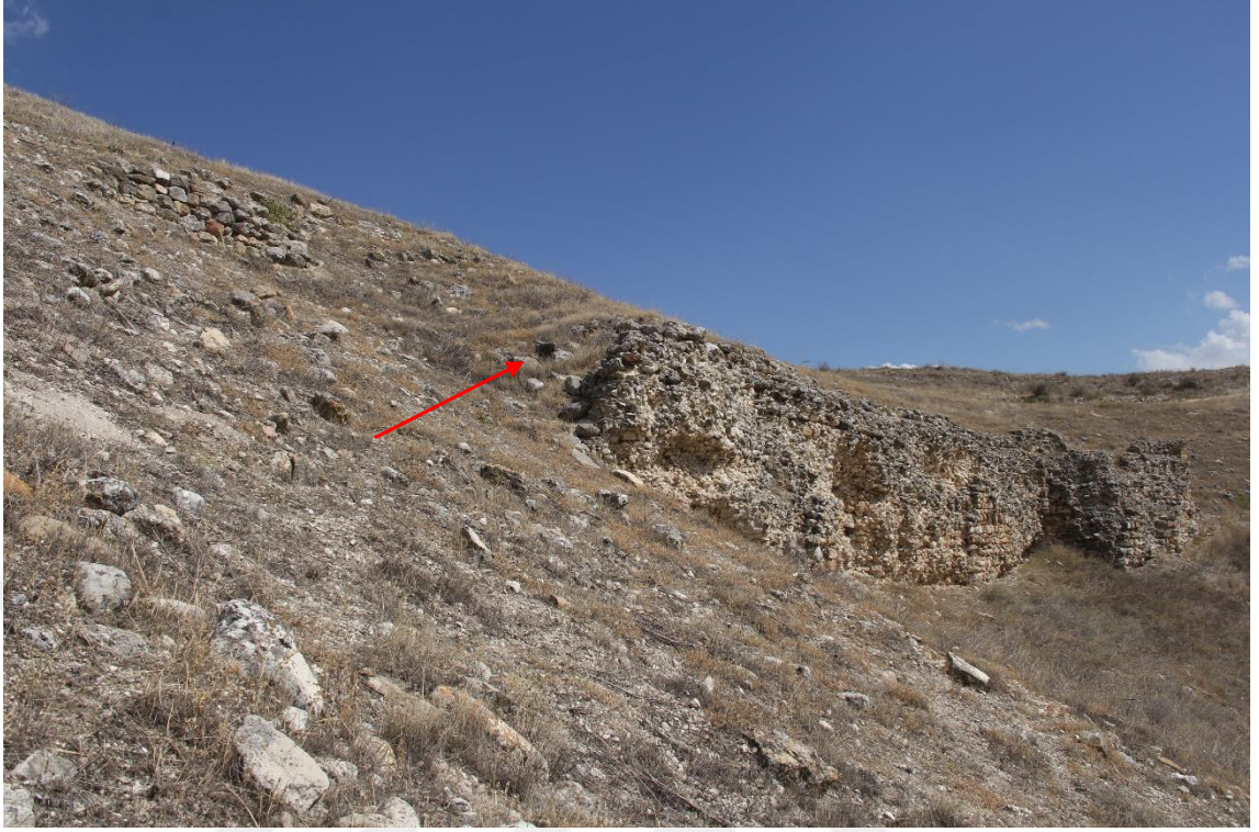
Fig.60a: GK6'nın Güneyden Görünüşü.
