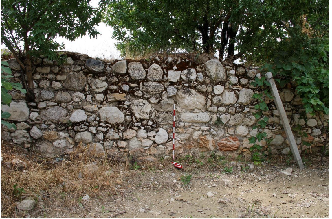
Fig.68c: Azmakkaşı Mevki Çevre Surunun Kuzey Cephesi.
