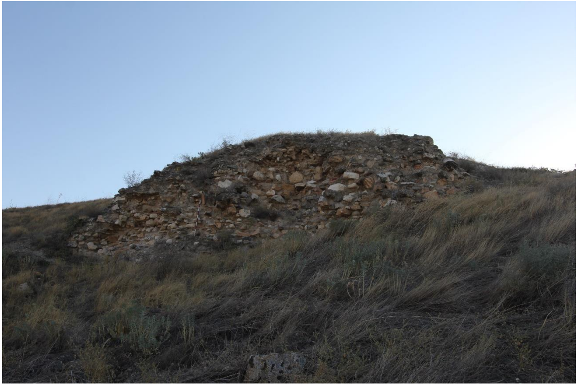
Fig.29: Erken Bizans Batı Surlarının Batı Cephesinin Bir Kısmı.
