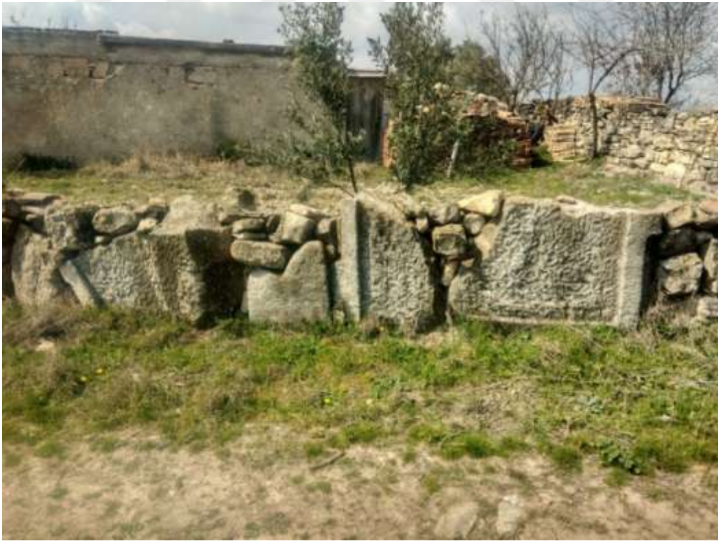
Fig. 34: Kırbıyık, Köy Evinin Çevirme Duvarında Kullanılan Çerçeveli Mimari Bloklar.
