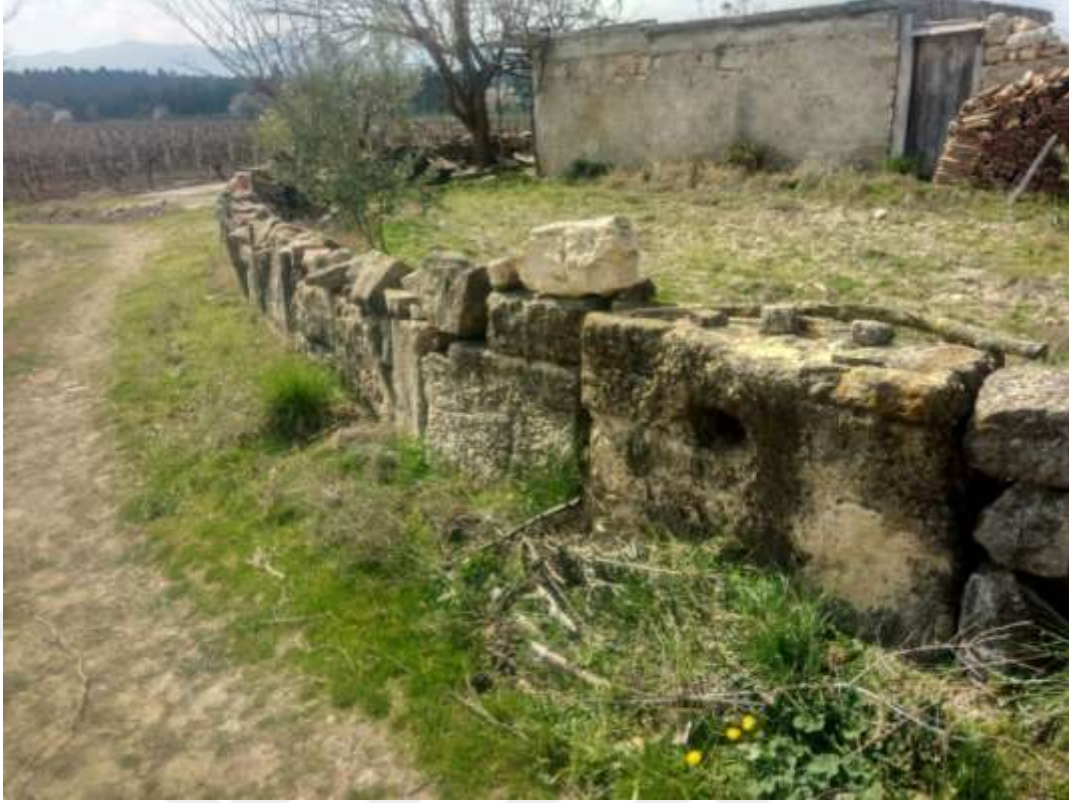
Fig. 33: Kırbıyık, Köy Evinin Çevirme Duvarında Kullanılan Mimari Bloklar.
