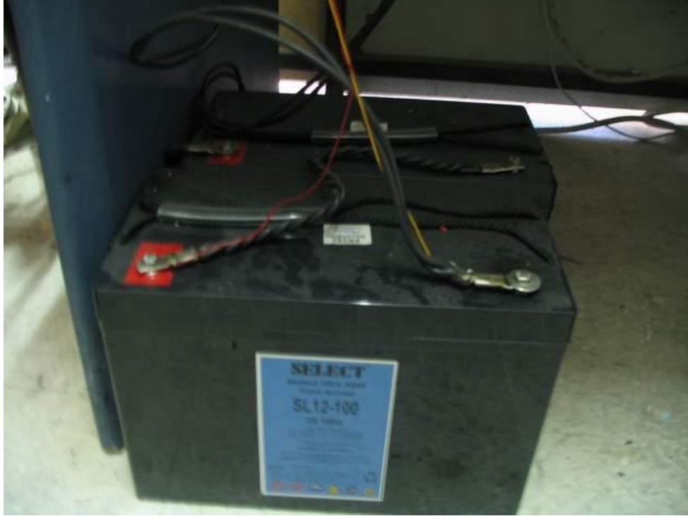
Şekil V-4 Akü Grubunun Görünüşü.
