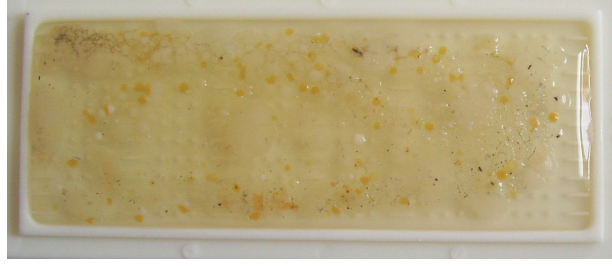
Şekil IV.1.1. Mühendislik Fakültesi Kızlar Tuvaleti Kabin İçi Zemin
