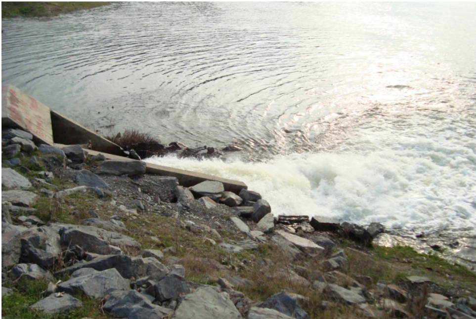
Şekil III.10 Terkos Su Aktarım Kanalı
