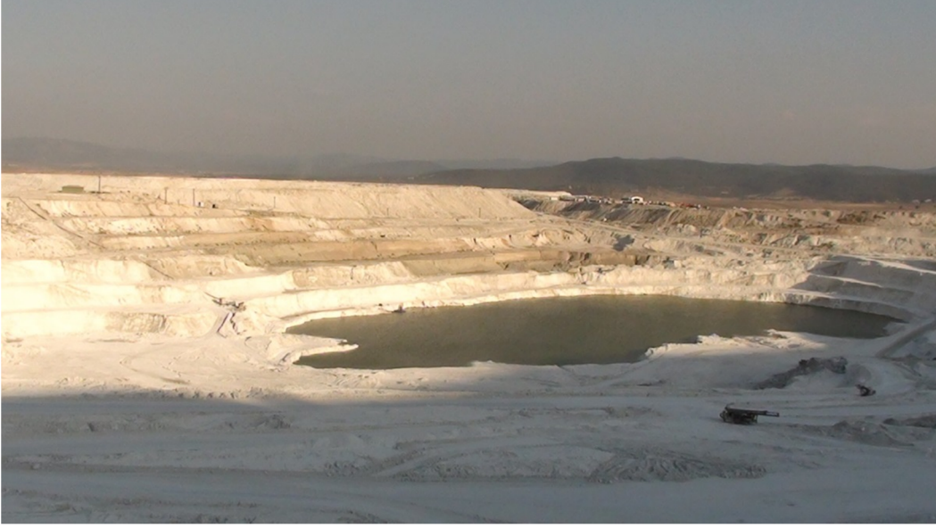
Şekil 4.40 Kırka Bor Açık İşletmesi'nin genel görünümü.
