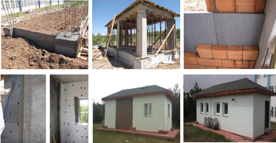
Şekil 4.1.1-(a.b.c.d.e.f) Isı Evi İnşa Aşamaları [42] [67]
