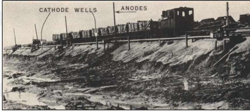
Şekil 2.24 Almanya demiryollarında susuzlaştırma amaçlı Elektro-osmoz arazi uygulaması (Kravath, 1954).
