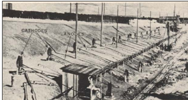
Şekil 2.25 Norveçte bir inşaatta (U-boat) siltli kil zeminde Elektro-osmoz arazi uygulaması (Kravath, 1954).
