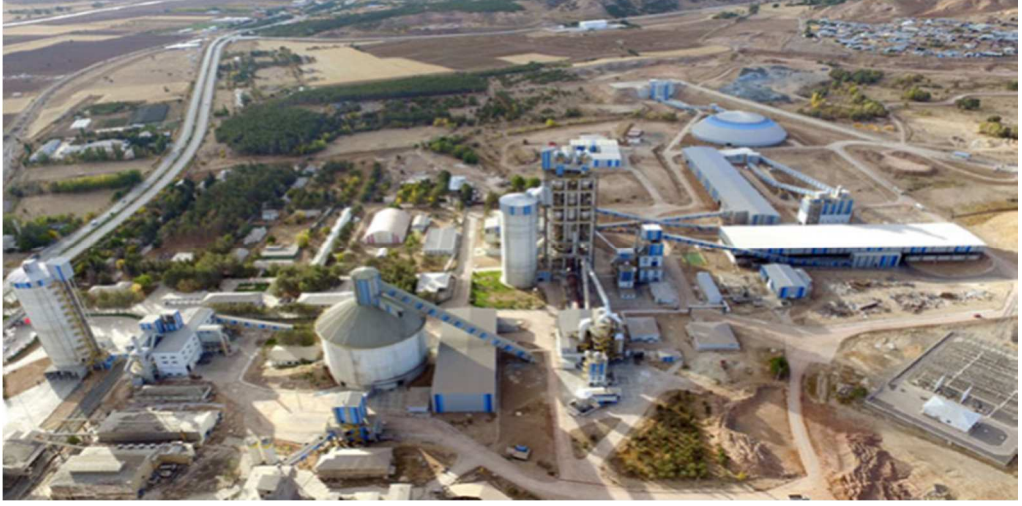
Şekil 1.1. Sivas çimento fabrikası.
