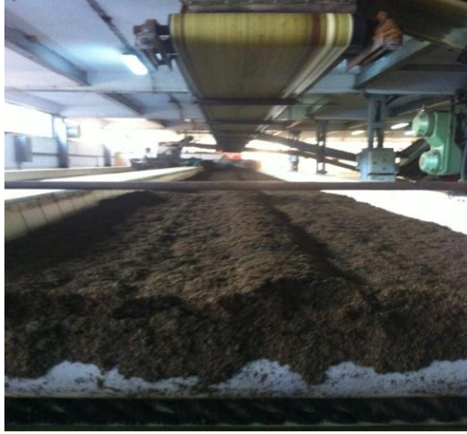
Şekil 2.2.3 Çay Fabrikası Oksidasyon Ünitesi
