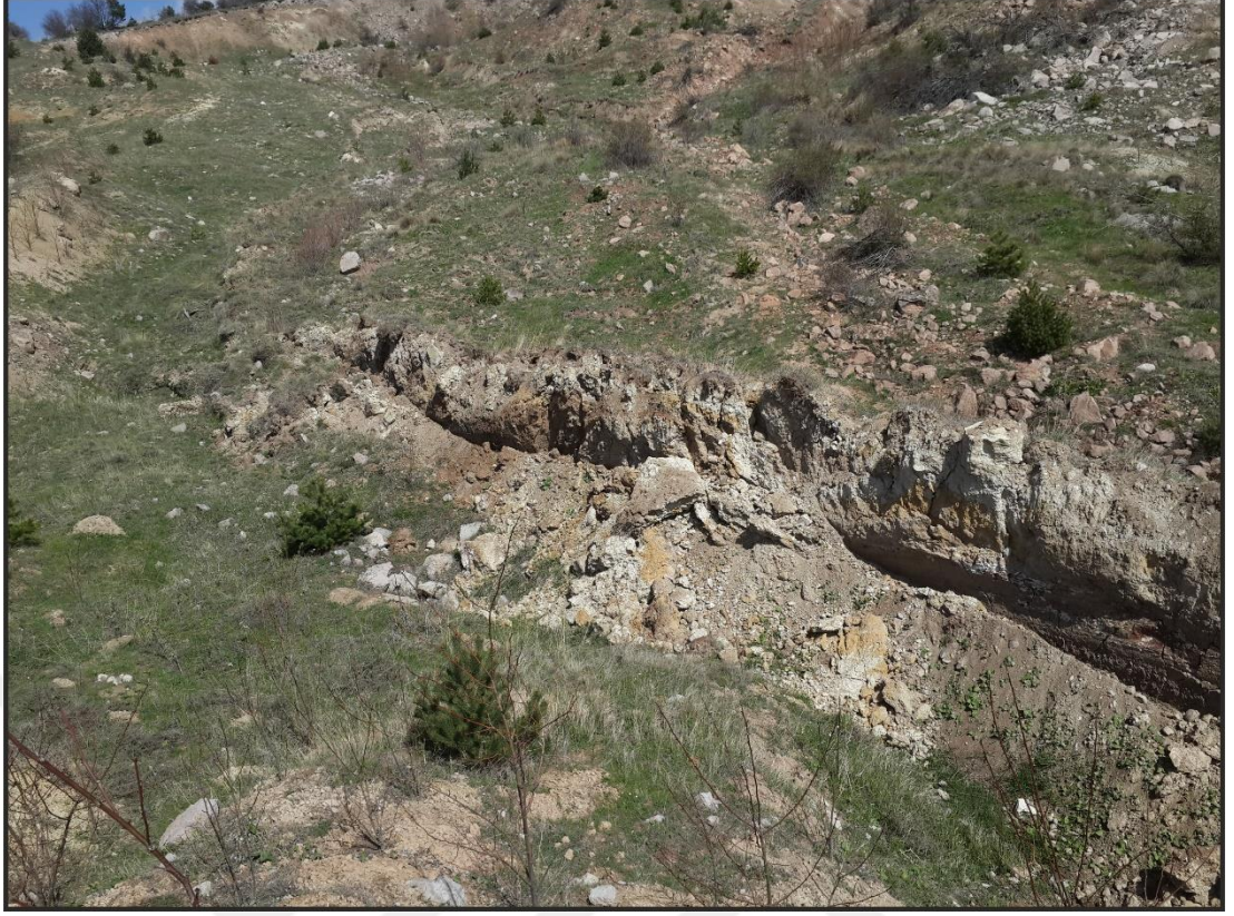
Şekil 1.9 Heyelan içerisinde meydana gelen gerilme çatlakları (Hastaoglu vd., 2015).
