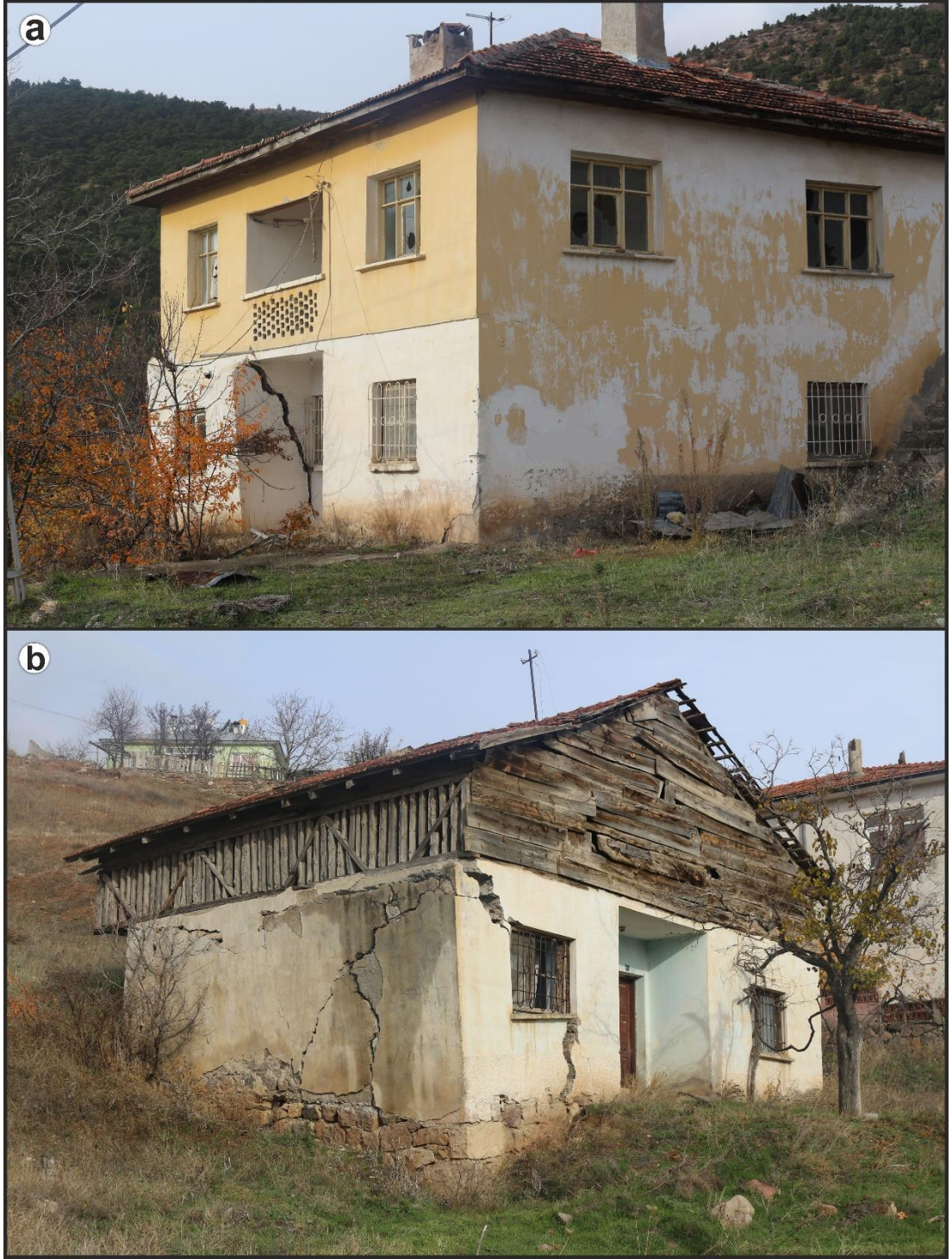
Şekil 3.27 Binalarda meydana gelen deformasyonlar.
