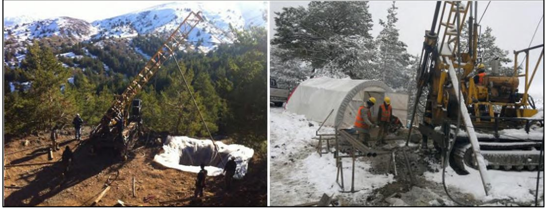
Şekil 3.5 Pasinex tarafından Gölcük’de yapılan sondaj çalışmalarından görünüm.
