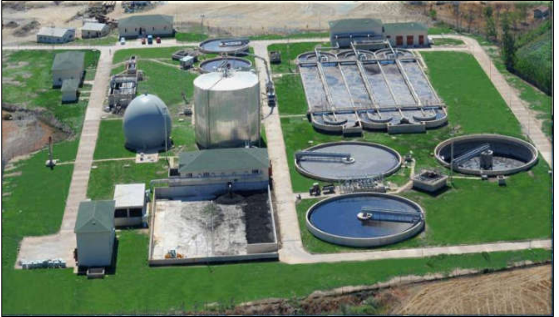
Şekil 3.1 Tokat Belediyesi Atıksu Arıtma Tesisi
