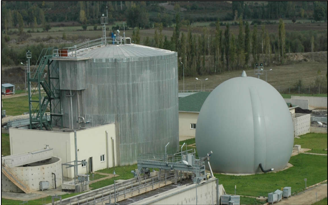
Şekil 3.3 Çürütücü Binası ve Biyogaz Deposu
