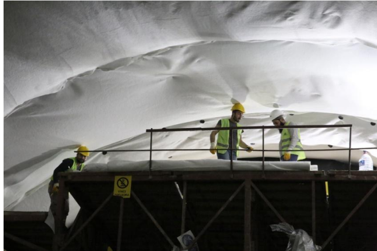
Şekil 3.4 Tünel İnşaatı Yalıtım Çalışmaları
