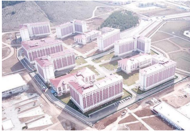
Şekil 3.15 10 Bin kişilik Yurt İnşaatı Drone Fotoğrafi
