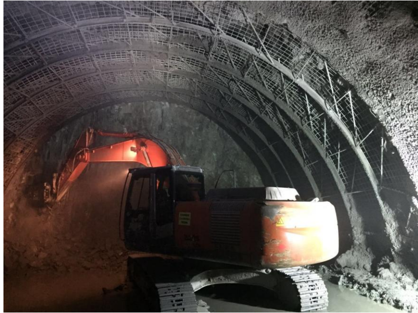
Şekil 3.11 Geminbeli Tüneli Tüp İçi Çalışmalar
