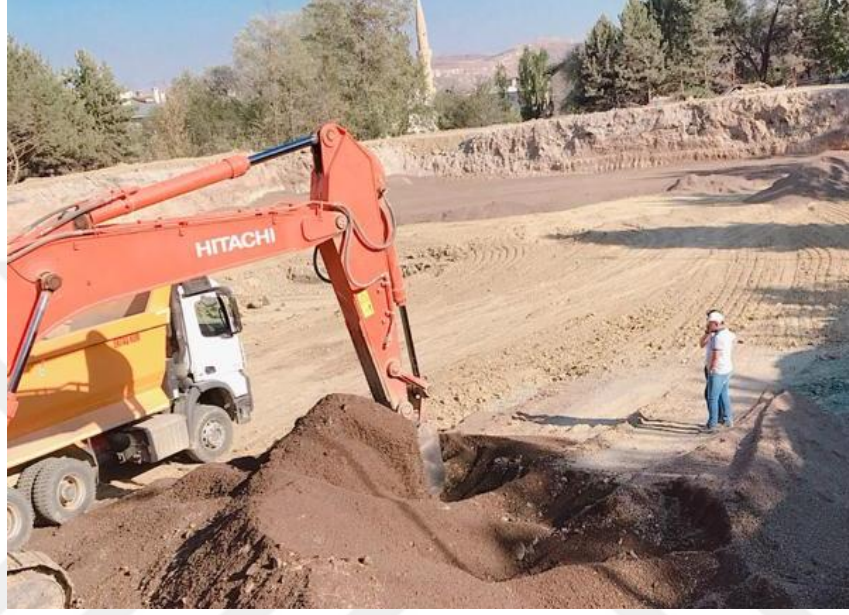
Şekil 3.23 Yapı Makinaları ile Çalışma II
