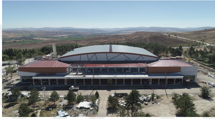
Şekil 3.1 Aqua Park İnşaatı Görünüş
