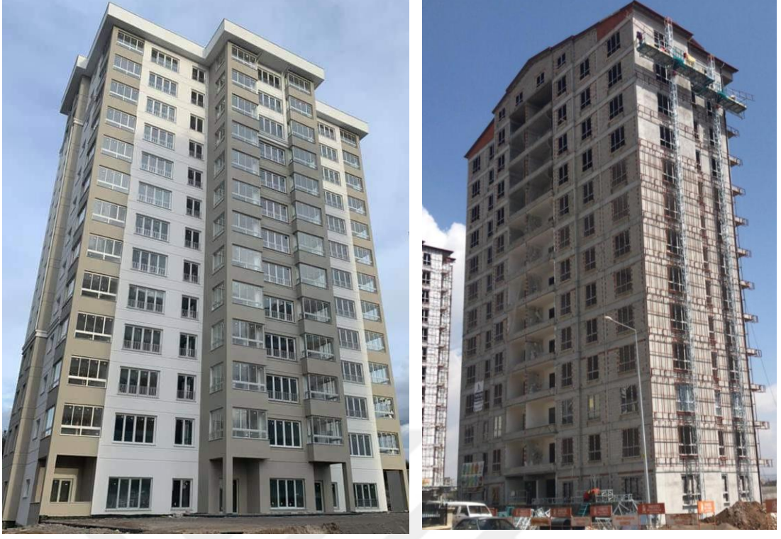
Şekil 3.17 Eğriköprü Mahallesiinde Yapılan İnşaatlara Örnek Fotoğraflar
