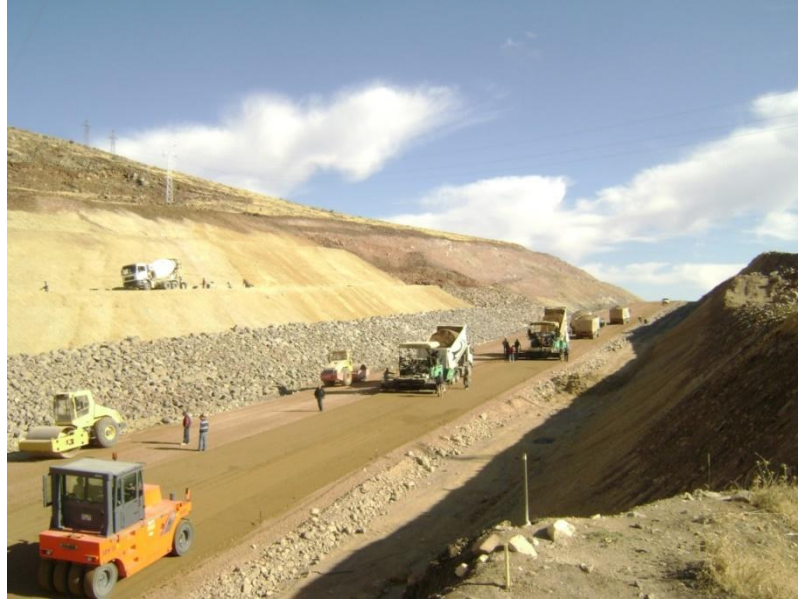
Şekil 3.6 Duple Yol Yapımı
