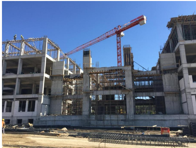
Şekil 3.13 Valilik Ek Bina İnşaat Aşaması
