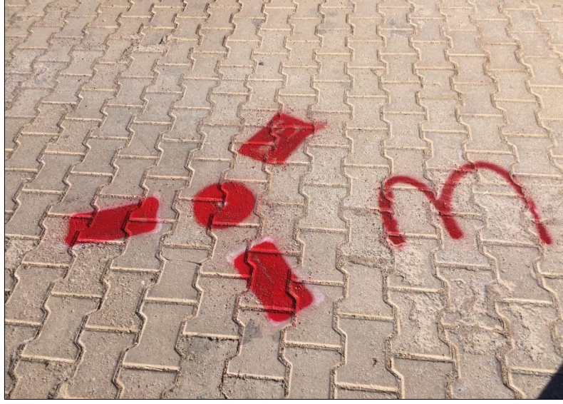
Şekil 4.3 İşaretlenen YKN görünümü
