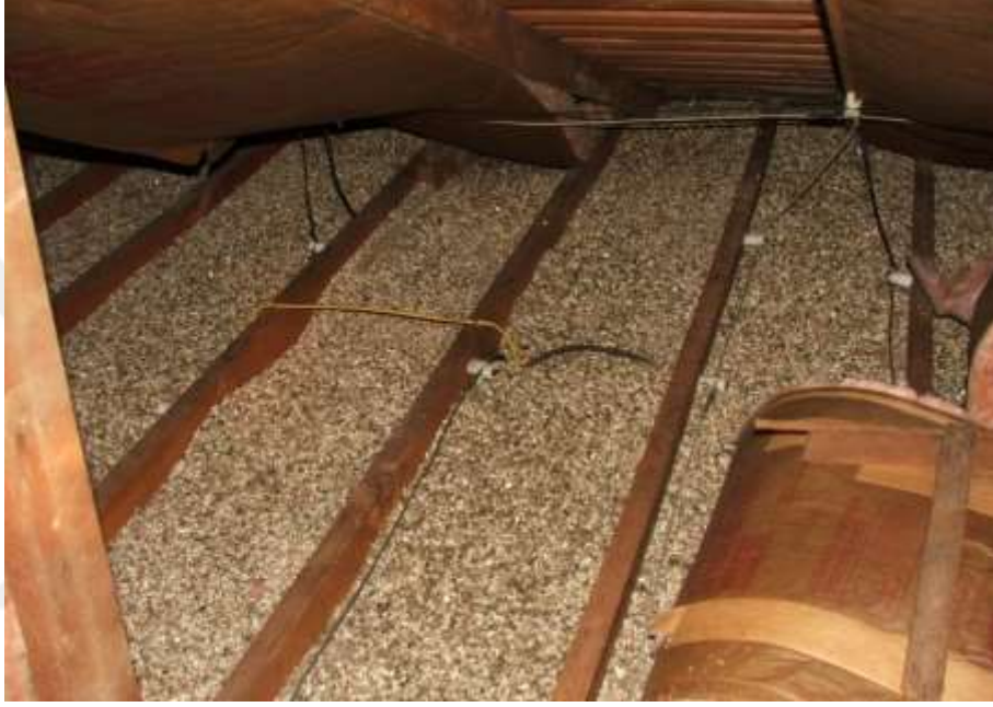
Şekil 2.12 Genleştirilmiş vermikülit'in ısı yalıtımı için tavan arasına serilmesi.
