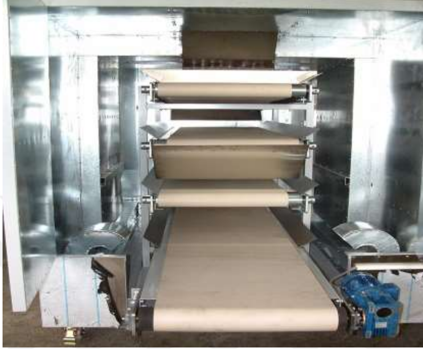
Şekil 3.9 Tünel kurutmaların iç kısımlarına ait görünüm.
