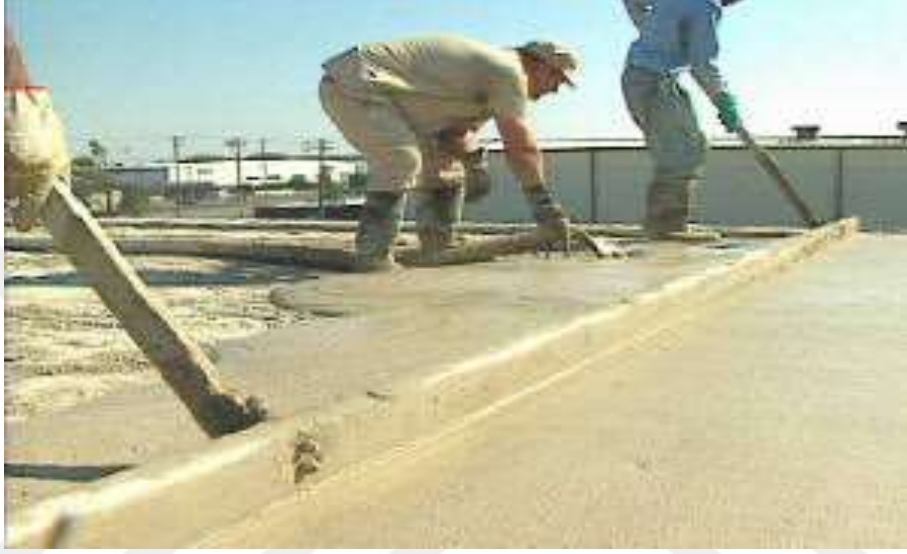
řekil 2.10 Vermikülitin çatı izolasyonunda kullanımı.
