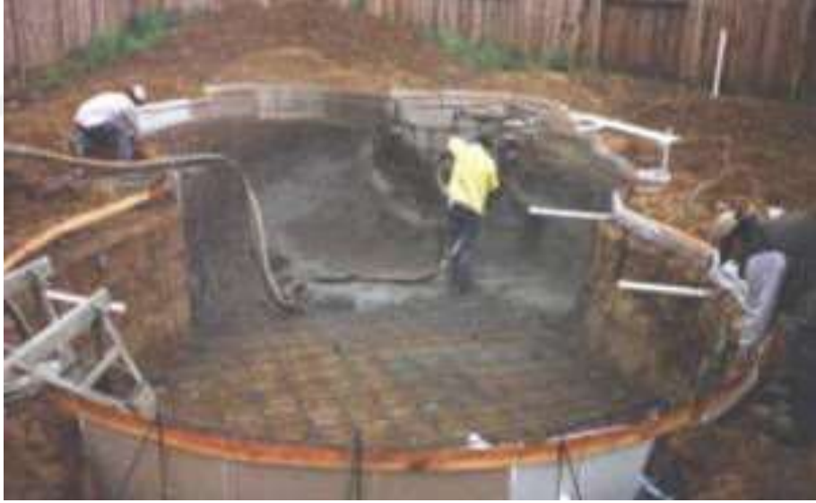
Şekil 2.14 Havuz tabanında püskürtme genleştirilmiş vermikülit uygulaması.
