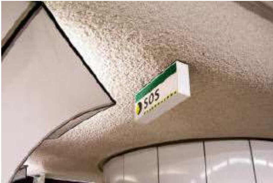
řekil 2.11 Vermikülit iđerikli tavan sıvası uygulaması.
