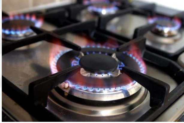
Şekil 2.21 Doğal Gaz Kullanılan Mutfak Ocağı
