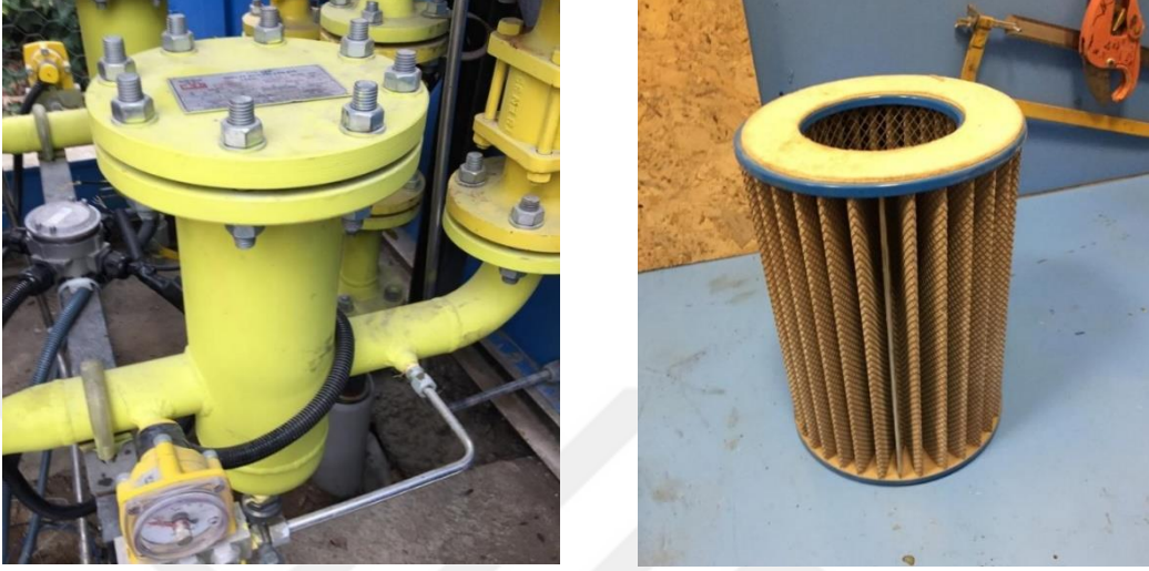
Şekil 2.15 İstasyonlarda Kullanılan Filtre ve Filtre Kartuşu
