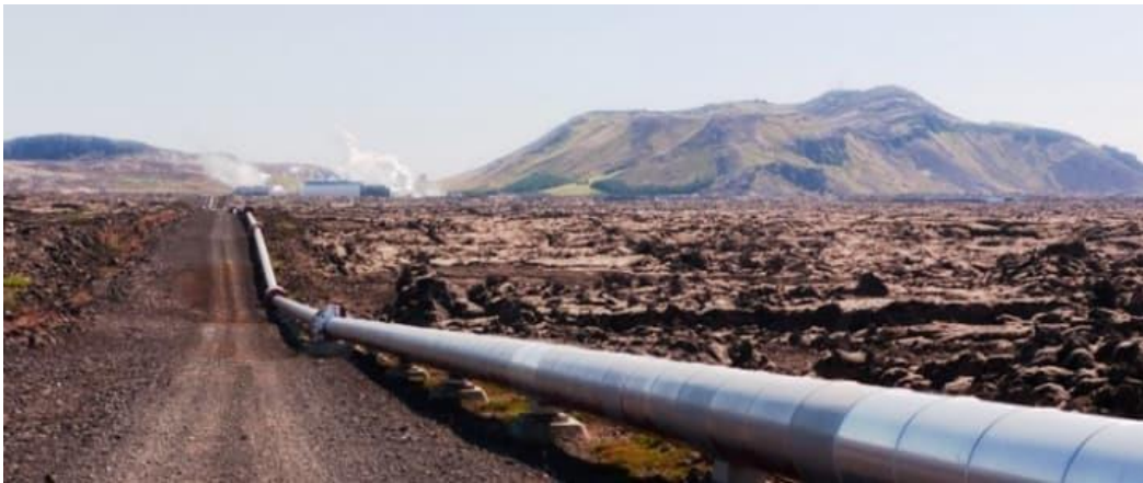
Şekil 2.12 Doğal Gaz Yüksek Taşıma Kapasiteli Yer Üstü Çelik Boru
