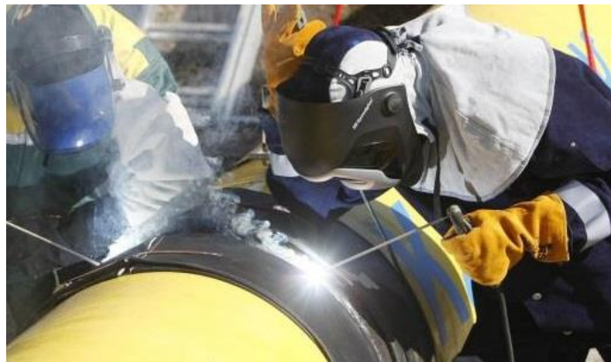
Şekil 2.36 Boru Birleşiminde Kaynak Uygulaması
