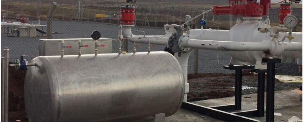
Şekil 2.2 Doğal Gaz Kokulandırma İstasyonu
