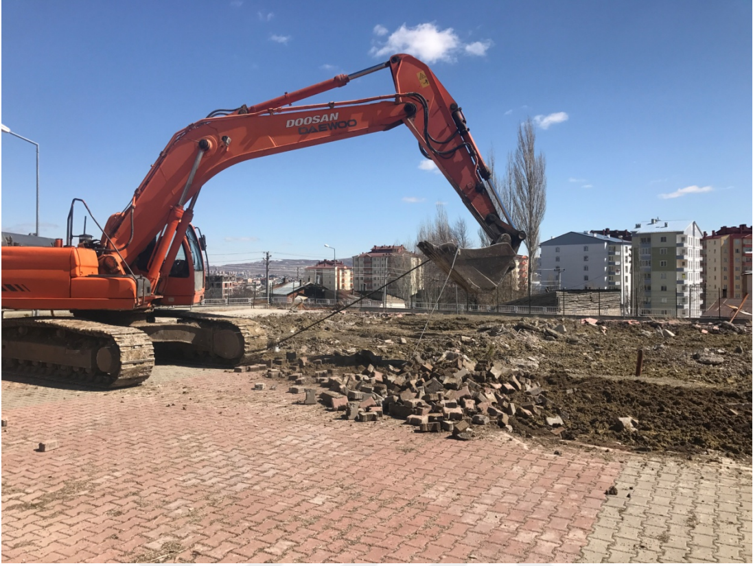
Şekil 1. İş makinası ile kazı çalışması
