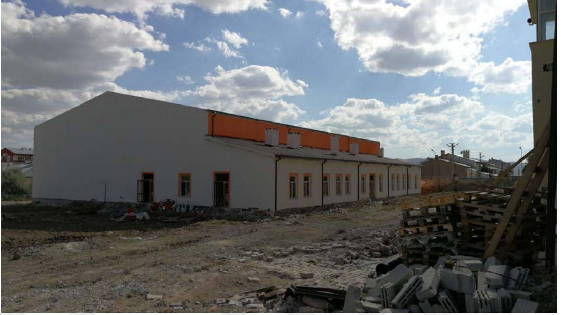
Şekil 11. İnşaat alanının temizliği ve malzeme istiflenmesi
