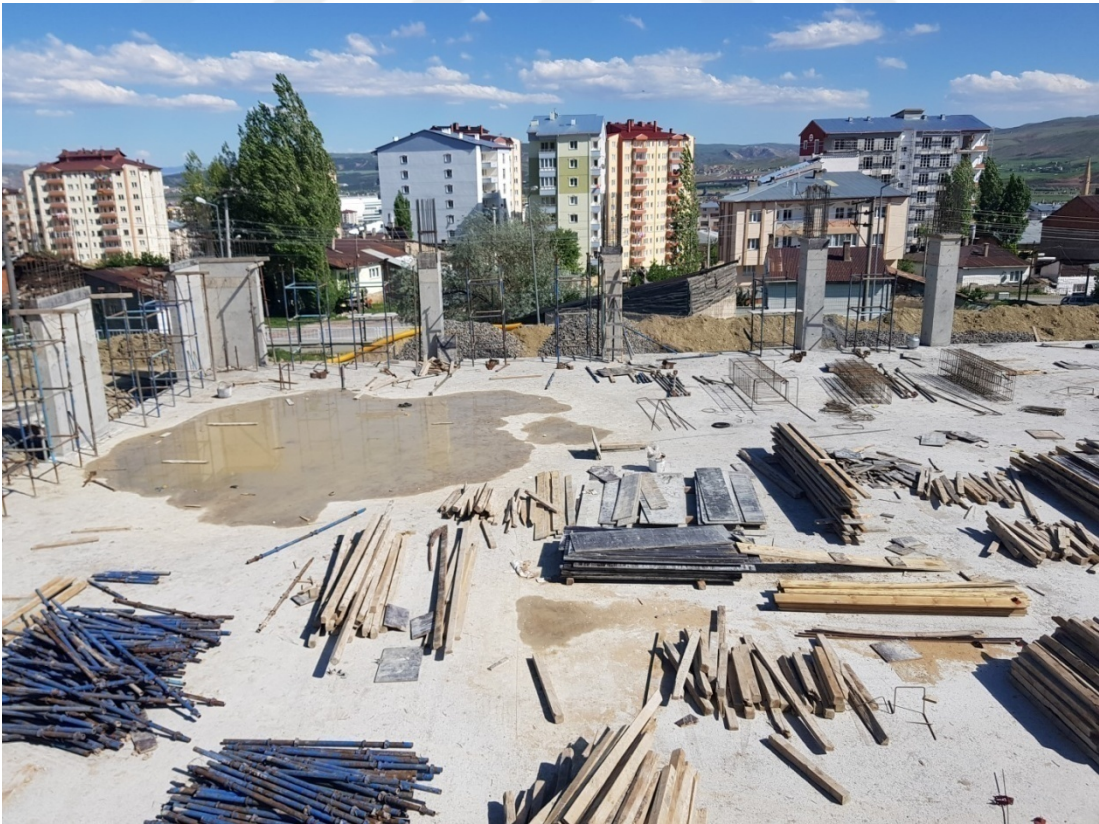
Şekil 3. Betonarme kalıp montajı ve sökümü
