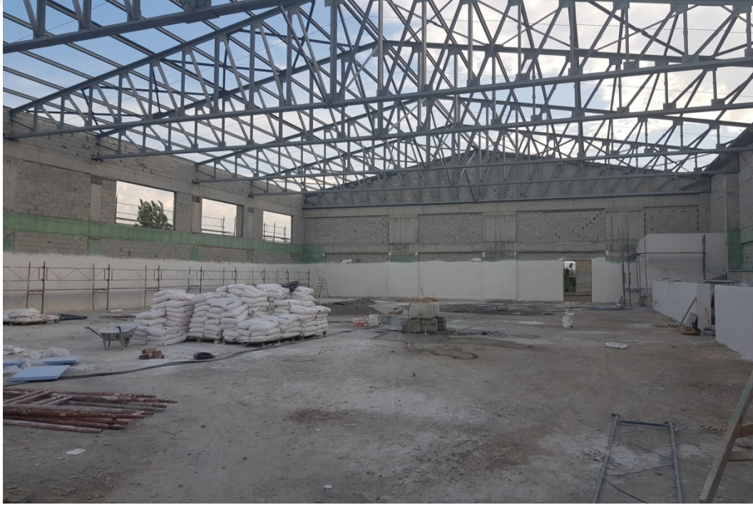
Şekil 10. Sıva, boya, badana ve kaplama işleri
