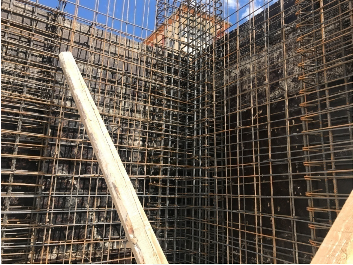
Şekil 6. Perde demirlerinin montajı
