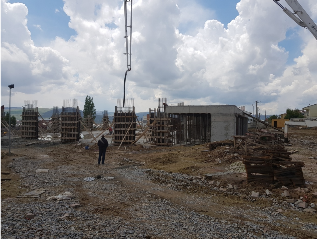
Şekil 7. Hazır beton dökümü
