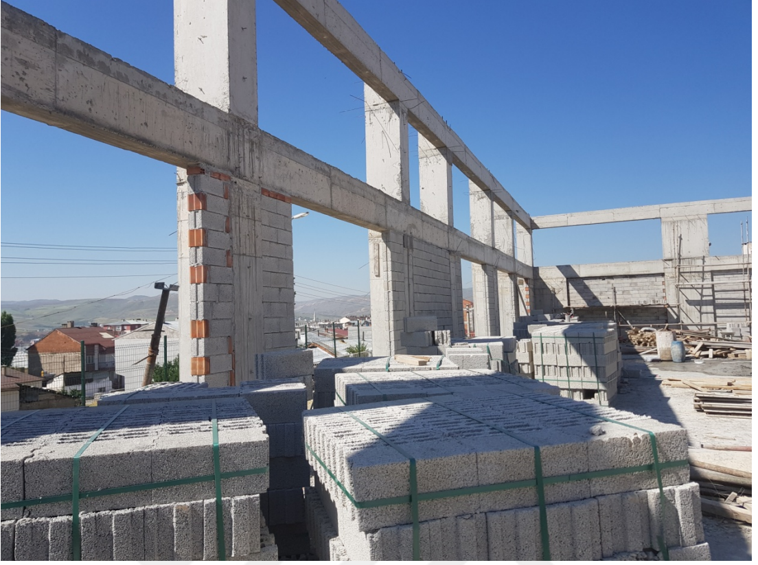
Şekil 9. Duvar örülme çalışması
