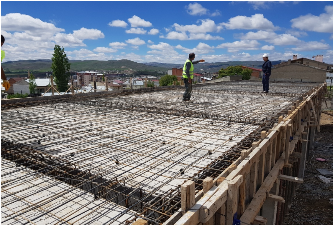
Şekil 5. Betonarme döşeme demir donatılarının işlenmesi
