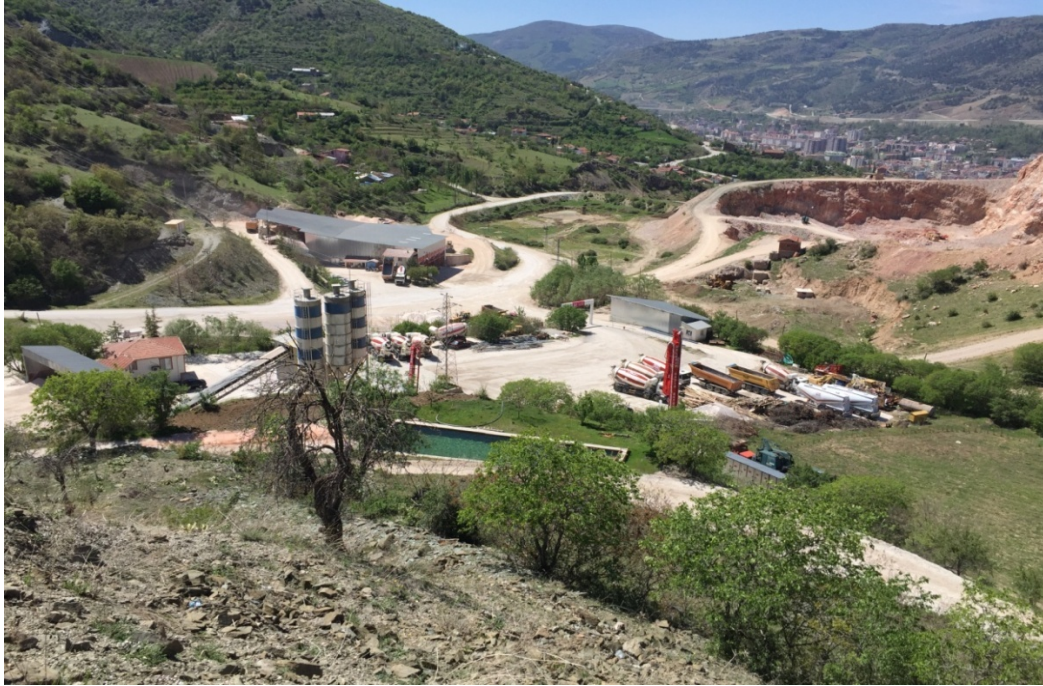
Şekil 3.2 Tesisin genel görünümü
