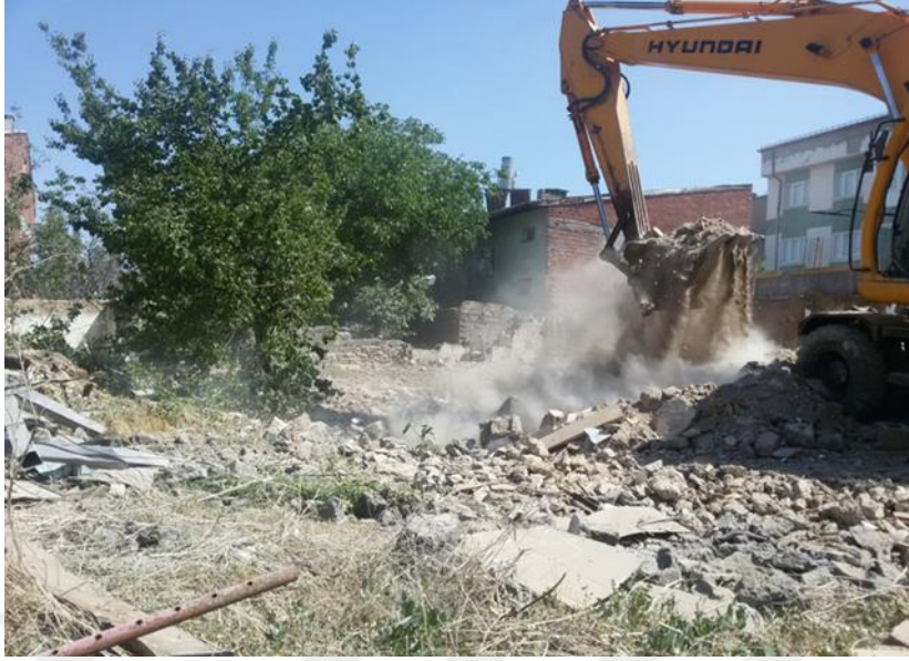
Şekil 4.43 Temel Kazısı Sırasında Toz Oluşması
