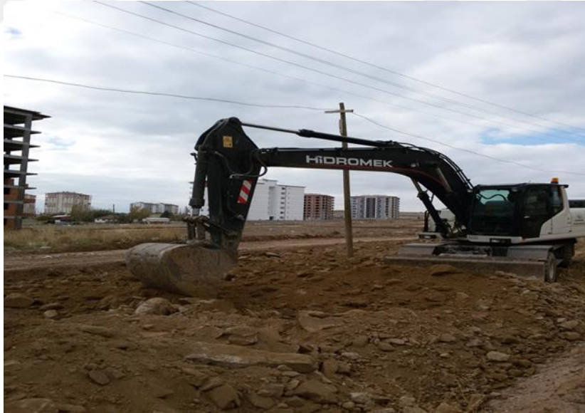
Şekil 4.34 İş Makinesinin Elektrik Hattının Altında Çalışması
