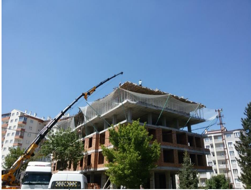
Şekil 4.12 İnşaatta Düşmelere Karşı Alınmış Önlem
