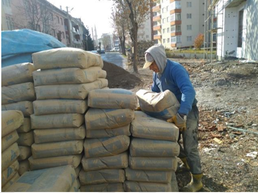
Şekil 4.44 Çimento, Alçı, Kireç v.b. İnşaat Malzemelerinin Taşınması
