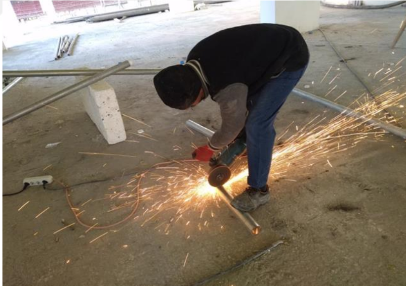
Şekil 4.36 Kesici Aletle Elektrik Kablosu Yakınında Çalışma
