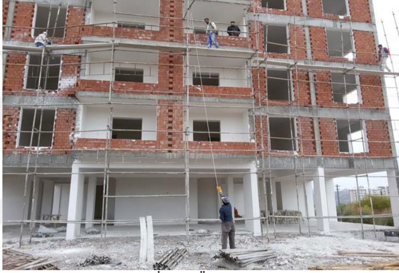
Şekil 4.1 İskele Üzerinde Çalışma
