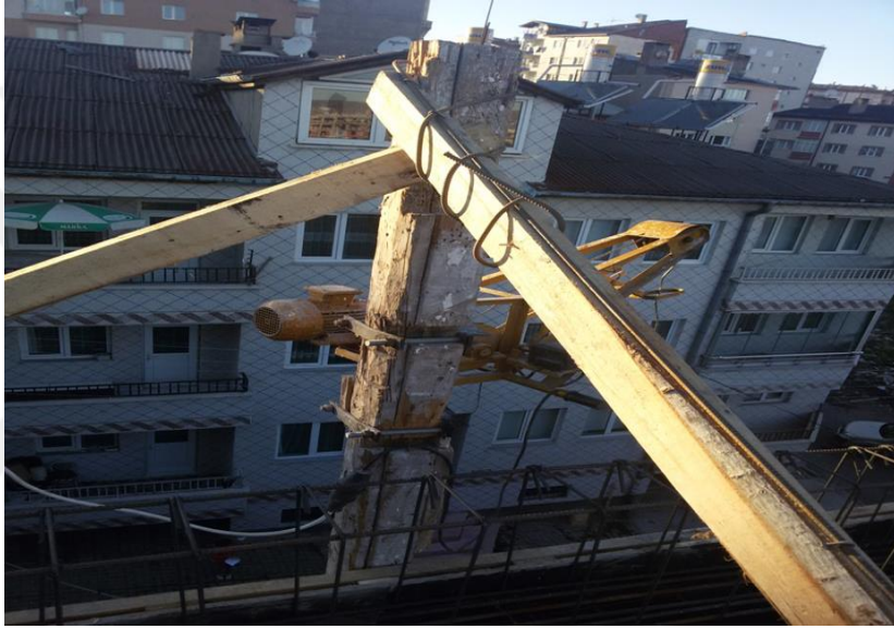
Şekil 4.11 İnşaat Alanında Asansör
