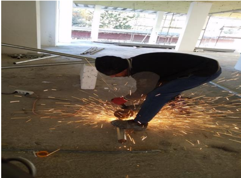
Şekil 4.45 Spiral İle Metal Kesme
