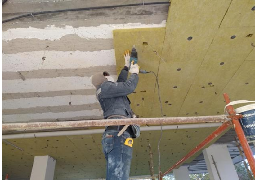
Şekil 4.28 Elektrikli Aletlerle Şantiyede Çalışma
