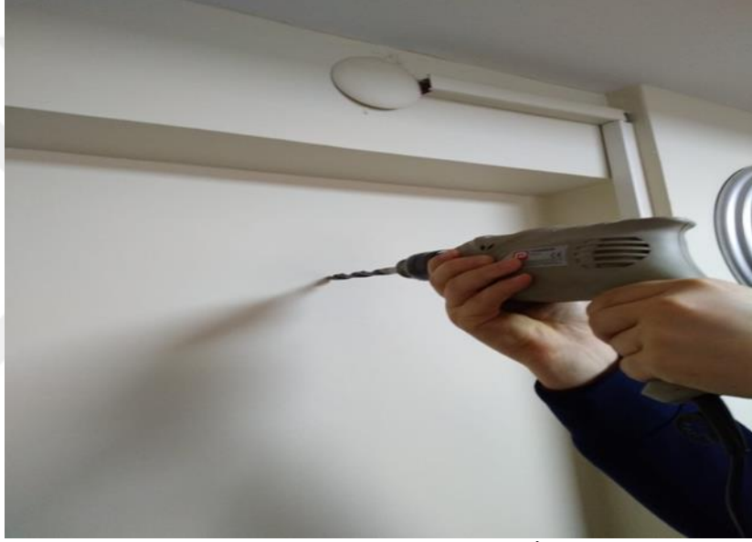
Şekil 4.42 Delici Aletle Montaj İşlemi
