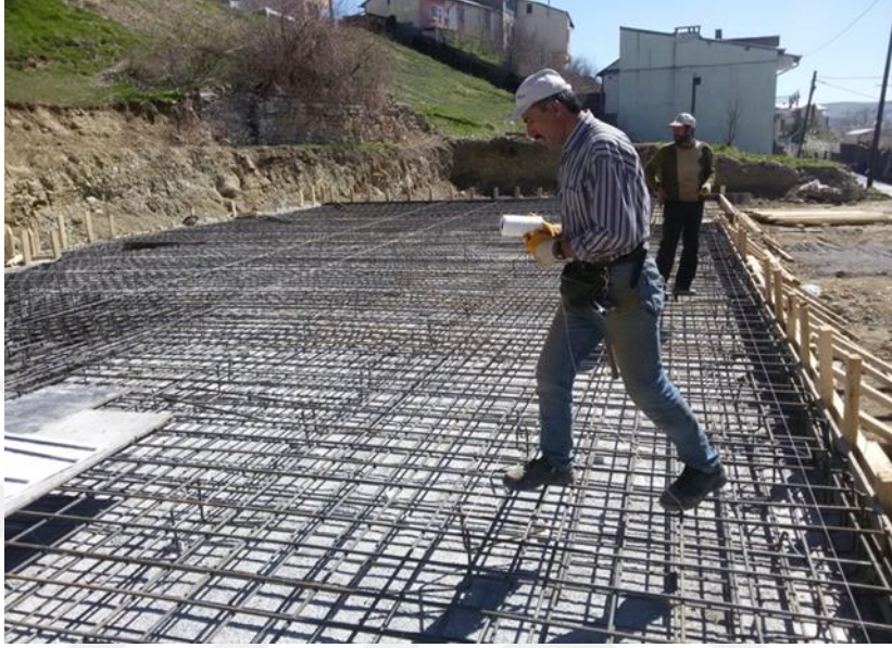
Şekil 4.14 Beton Kalıbında Demir Bağlama Çalışması
