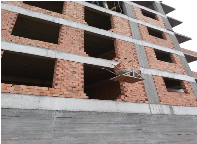
Şekil 4.10 Malzemenin Üst Katlara Çıkarılması
