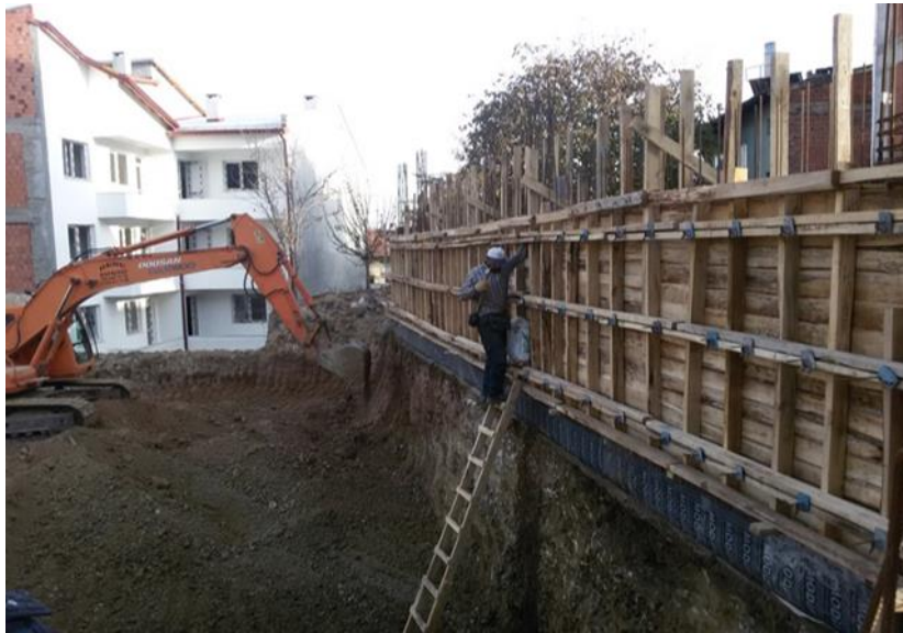
Şekil 4.22 İşçinin İş Makinesi İle Aynı Anda Çalışması
