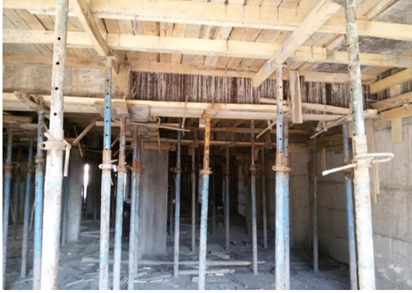
Şekil 4.18 Tabla Beton Kalıbı ve Direkleri
