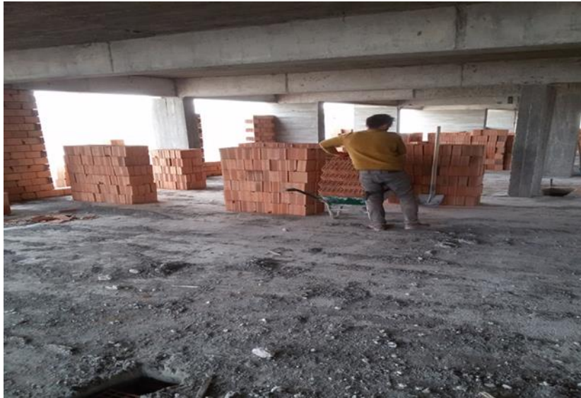
Şekil 4.13 Şantiyeye Gelen Malzemeleri Depolama ve İstifleme
