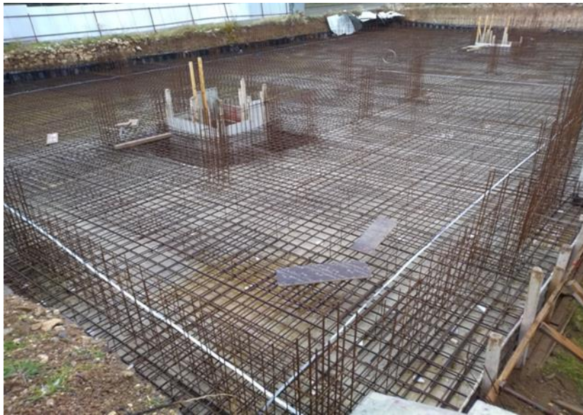
Şekil 4.31 Temel Topraklaması Yapılmış İnşaat Alanı
