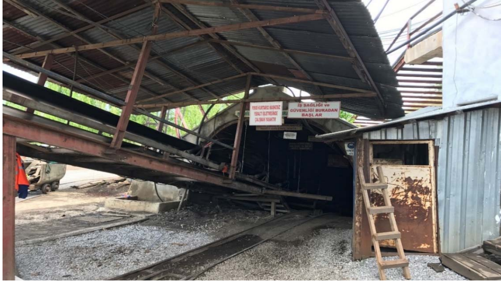
Şekil 3.5 Yeraltı işletmesi girişi (Kömür İşletmeleri A.Ş.)
