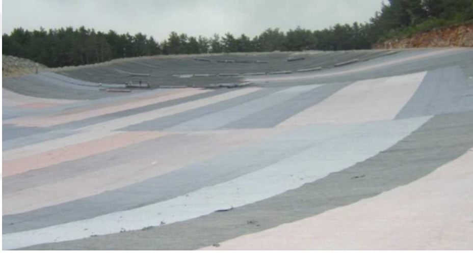
Şekil 4.10 Jeotekstil serilmesi örneği (Akyıldız, 2011).
