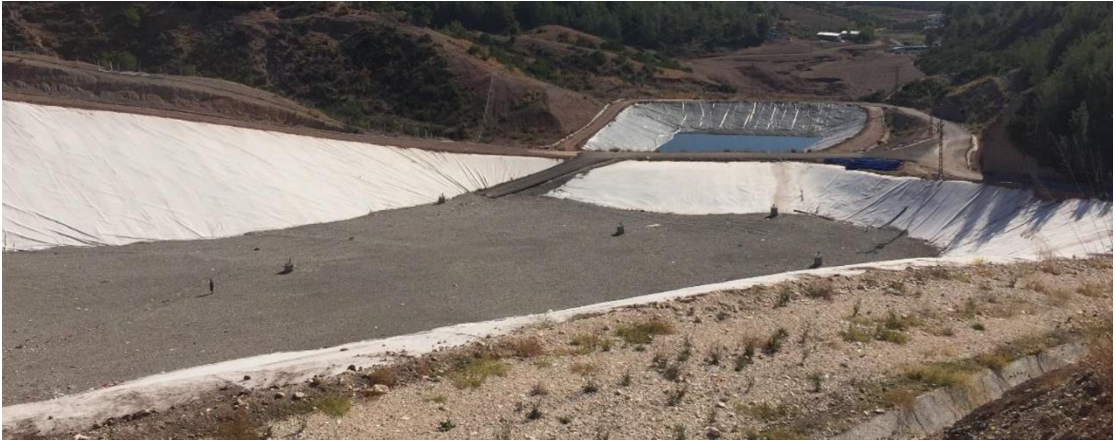
Şekil 9.6 Osmaniyeye 2. Sınıf DDT lot alanı çakıl serimi, gaz toplama bacaları ve sızıntı suyu lagünü
