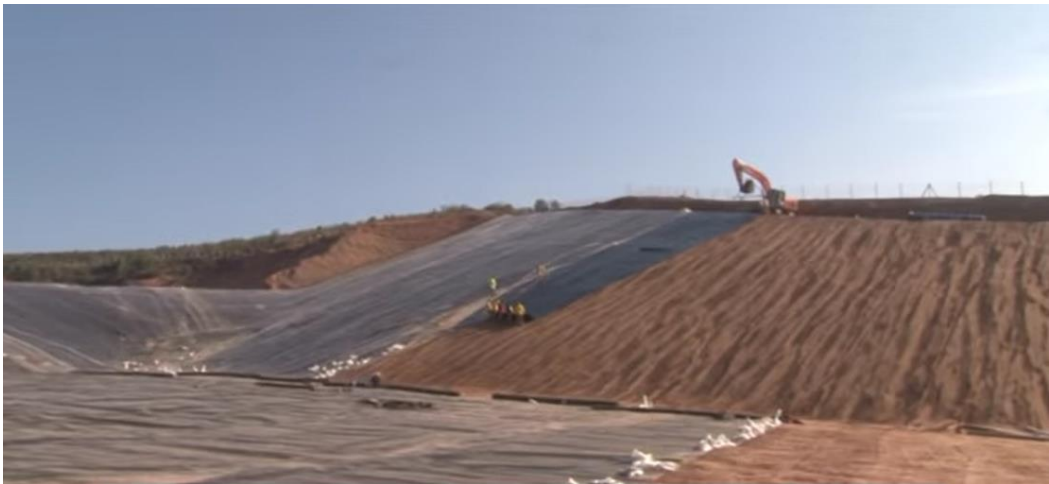
Şekil 4.9 Deponi alanına jeomembran serimi, Osmaniye örneği
