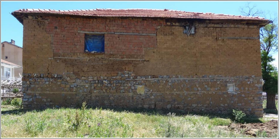
Şekil 5.11 Sürgü içinde, fay uzanımı üzerinde yer alan bir evde görülen çatlaklar ve tamirat izleri (Altunel, 2016).
