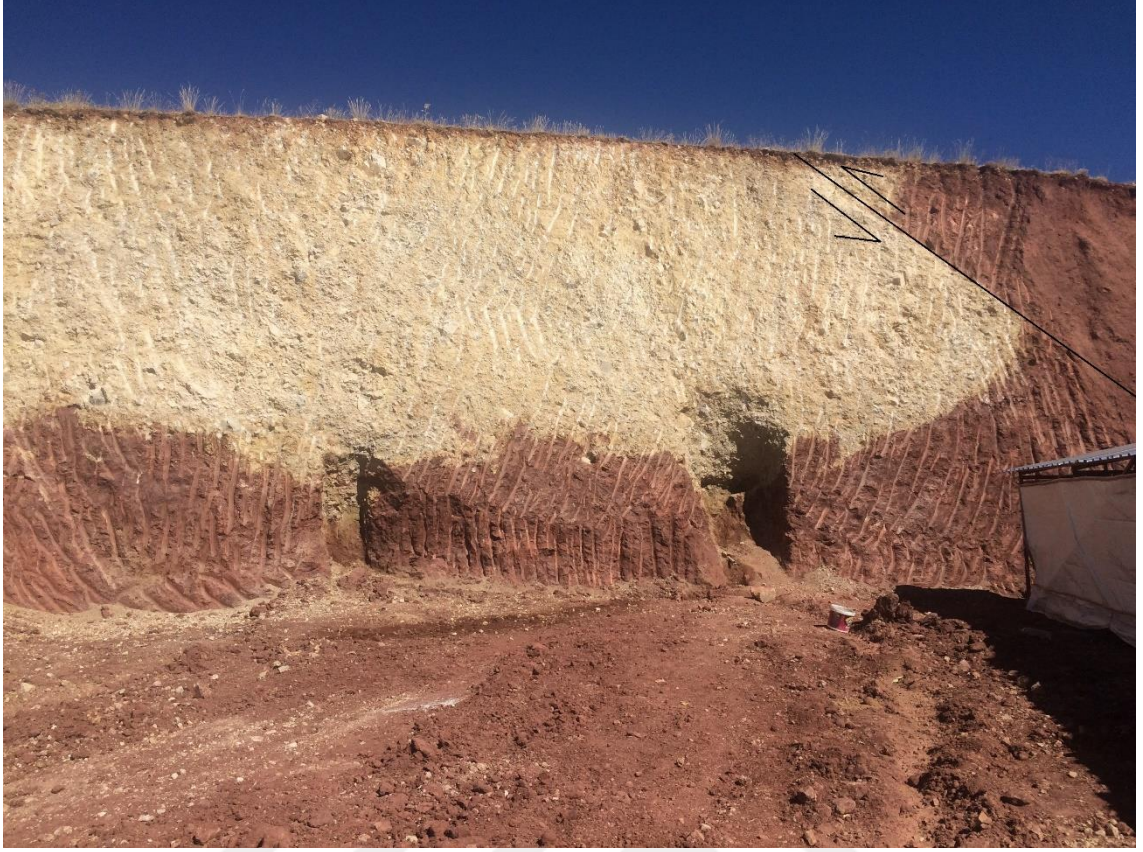
Şekil 4.6 İnceleme alanında genç çökeller içinde gözlenen olası ters fayın görünümü, Bakış yönü doğu.
