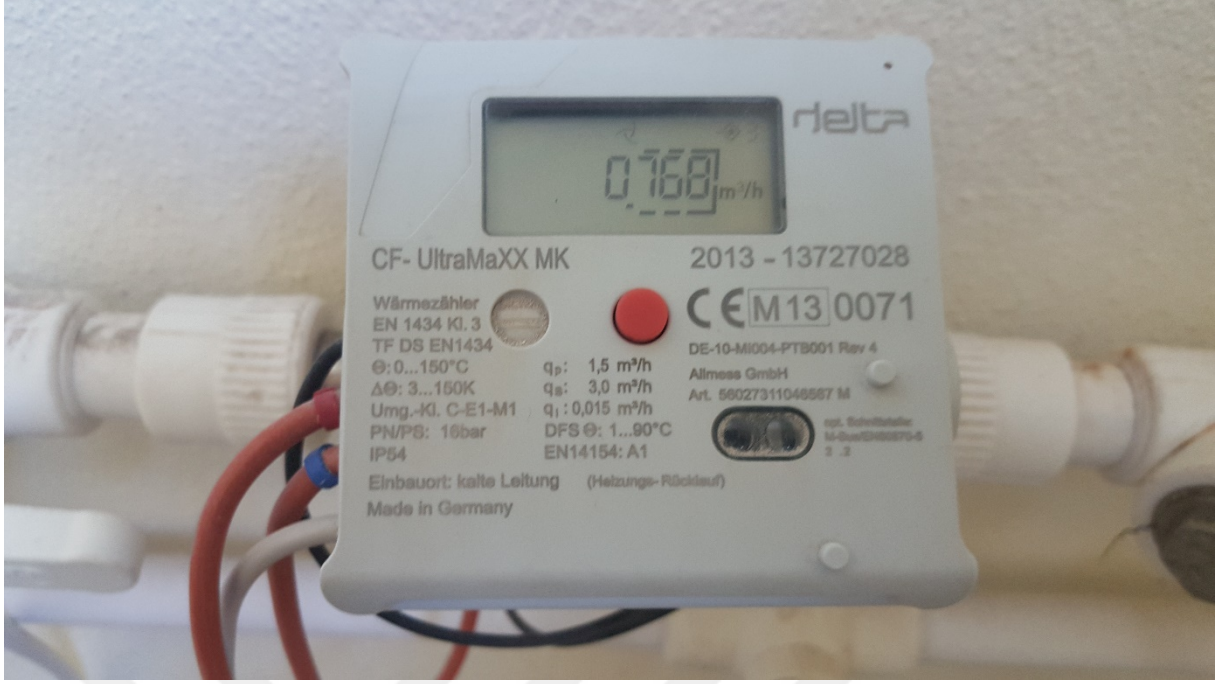
Şekil 3.12 Ultrasonik termal enerji sayaç
