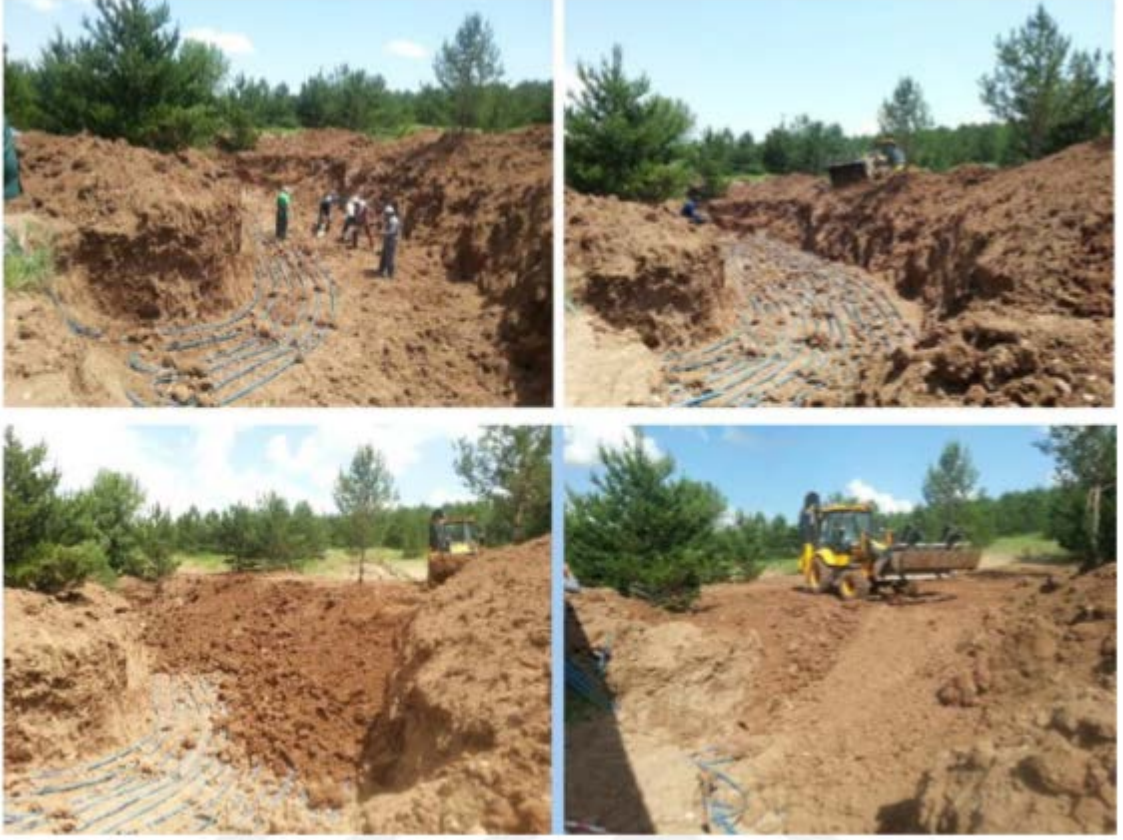
Şekil 3.3 Toprak ısı değiştiricilerinin yerleştirilmesi (Caner,2018)
