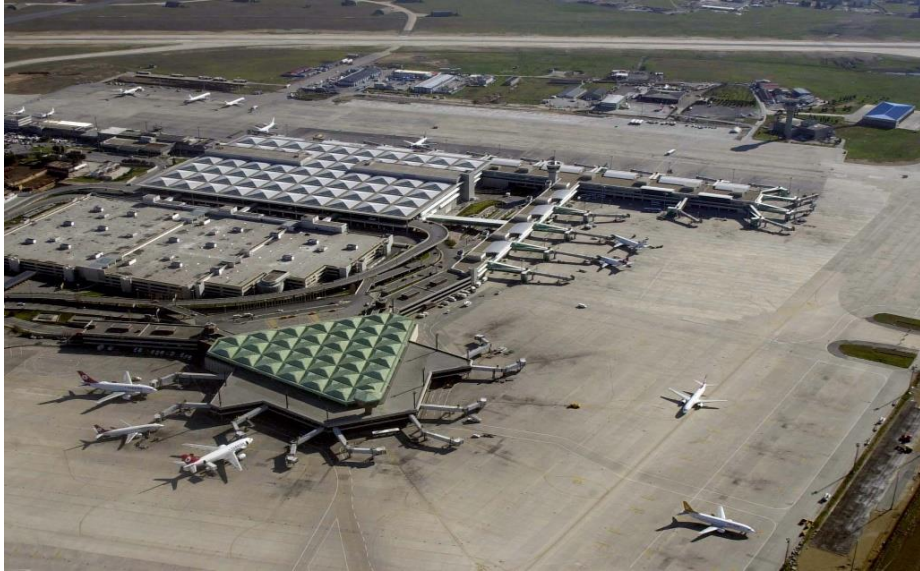
Şekil 1. 12 Atatürk Havalimanı Dış Hatlar Terminali (Mceer, 2002).
