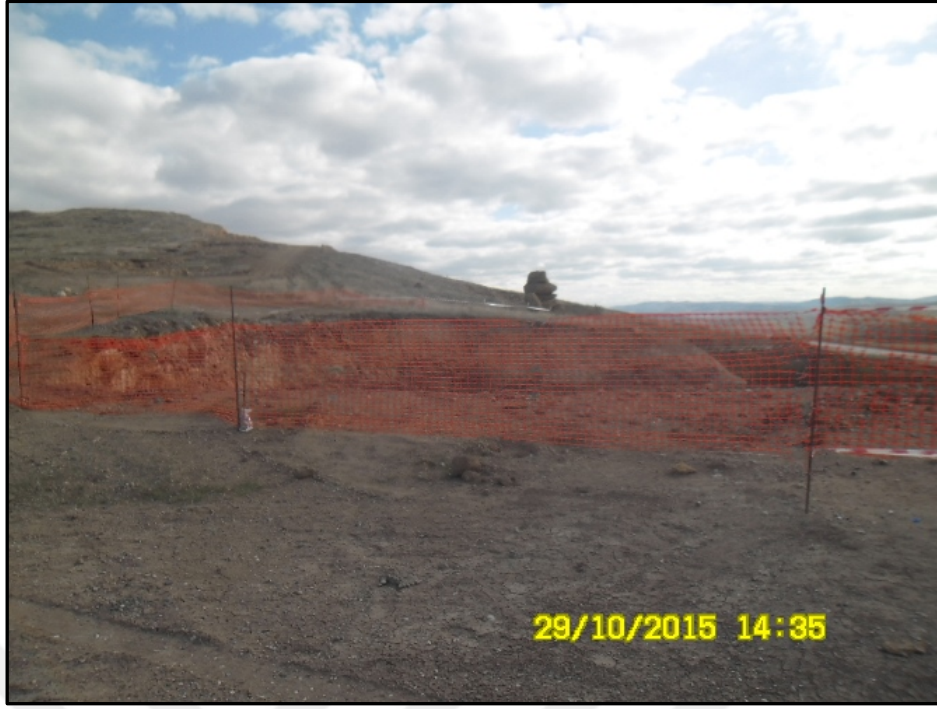
Şekil 5.43 Kazı kenar boşluklarına çekilen alan perdesi şeklindeki şerit
