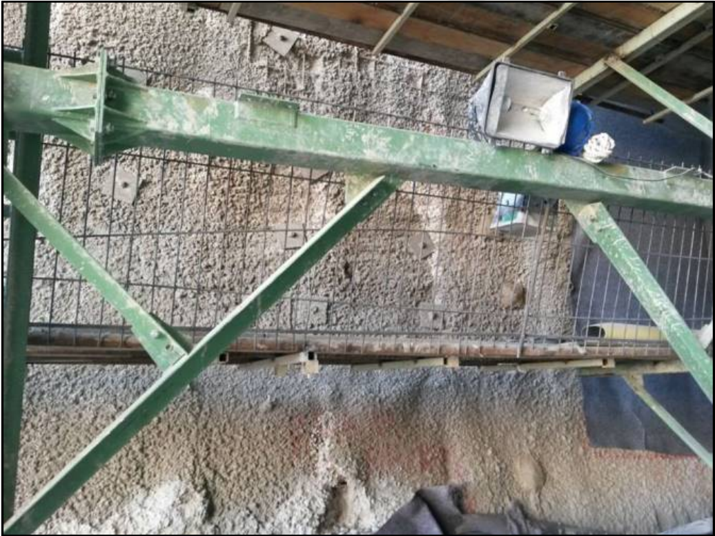
Şekil 5.32 Tünel içinde bulunan iskelelere yapılan kafes tipi kenar korkulukları
