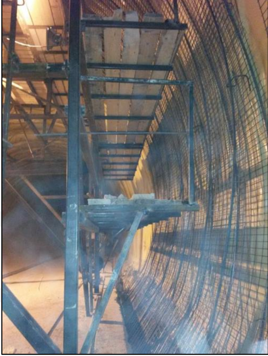
Şekil 5.34 Membran iskele çıkış noktaları kenar korkulukları
