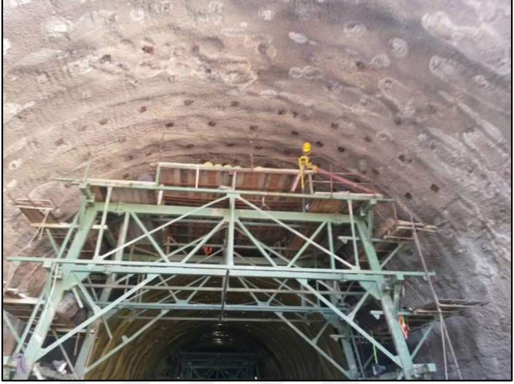
Şekil 5.31 Tünel içinde bulunan iskelelere yapılan kenar korkulukları
