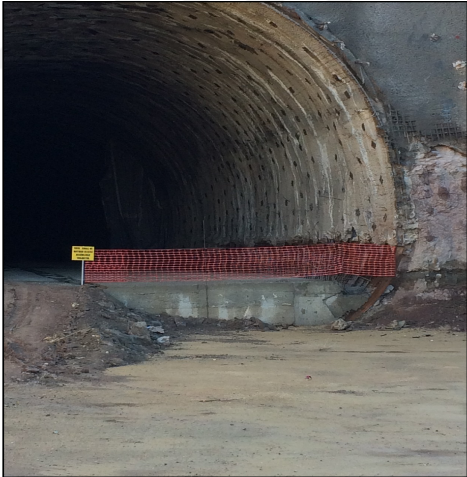
Şekil 5.30 Tünel işlerine ara verildikten sonra kapatılan tünel girişi
