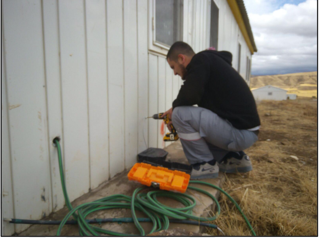
Şekil 5.4 Şantiye sahası ilaçlama çalışmaları
