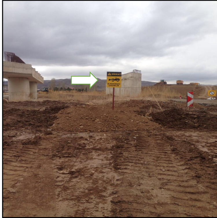
Şekil 5.42 Hafriyat sahasına yerleştirilen sarı zemin üzerine siyah piktogramlı "dikkat iş makinesi çıkabilir" levhası
