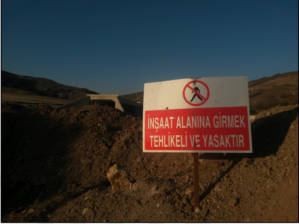
Şekil 5.19 Menfezlere asılan yasak levhası
