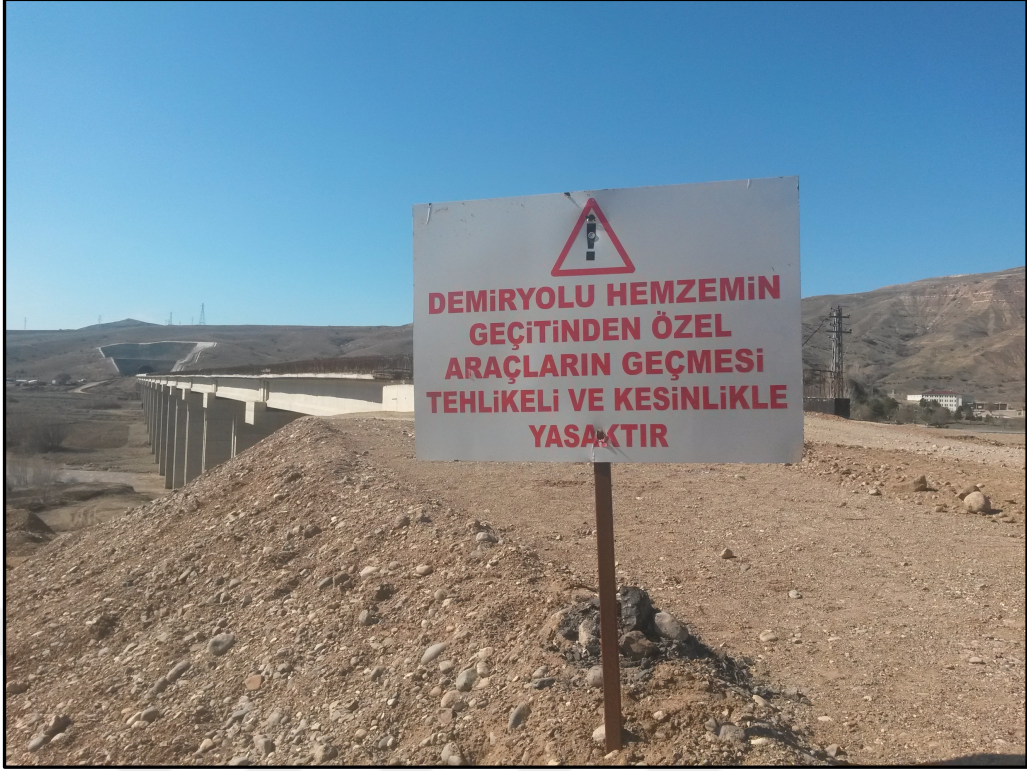
Şekil 5.17 Viyadüklere asılan yasak levhası
