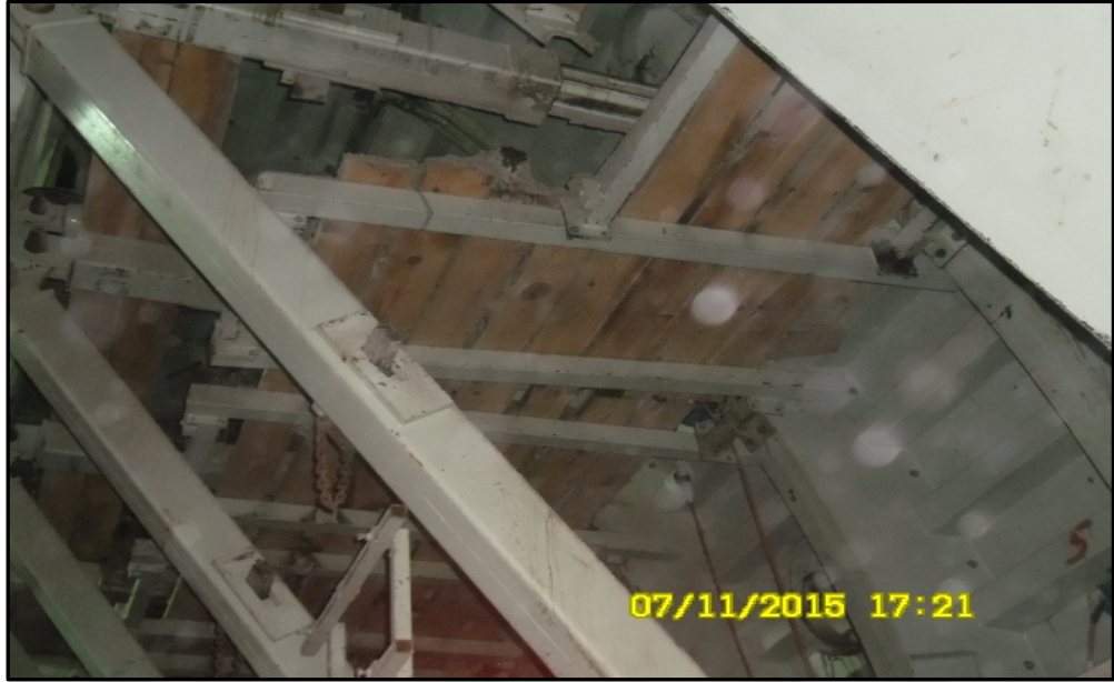
Şekil 5.35 Membran iskelelerin sabitlenen taban platformları
