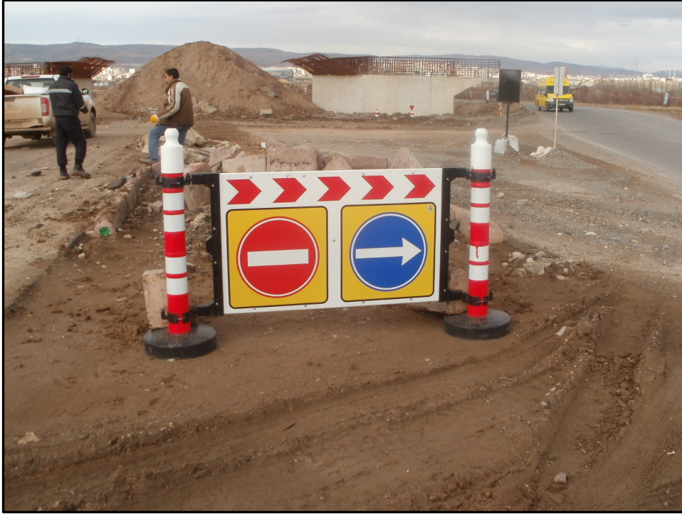
Şekil 5.40 Kazı işlemi yapılan bölgeye yerleştirilen yön levhası
