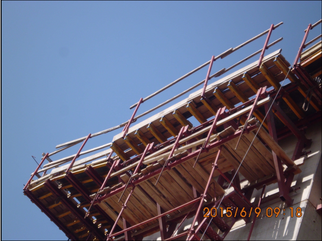
Şekil 5.20 Viyadük ayaklarının yapımında kullanılan kalıp iskele kenar korkulukları ve sabit platformlar-1
