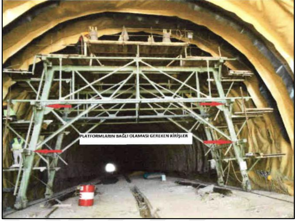
Şekil 5.24 Tünel işlerinde platformların bağlı olması gereken kirişler
