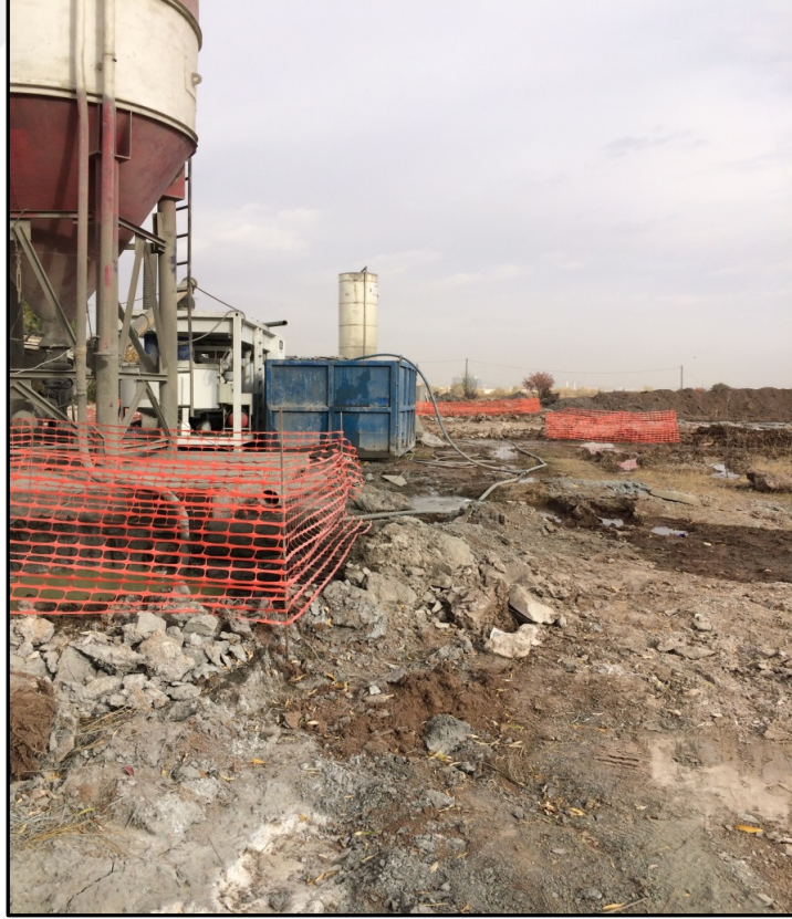
Şekil 5.47 Jet groud uygulama sahası çimento çukurlarına çekilen alan perdesi şeklindeki şeritler
