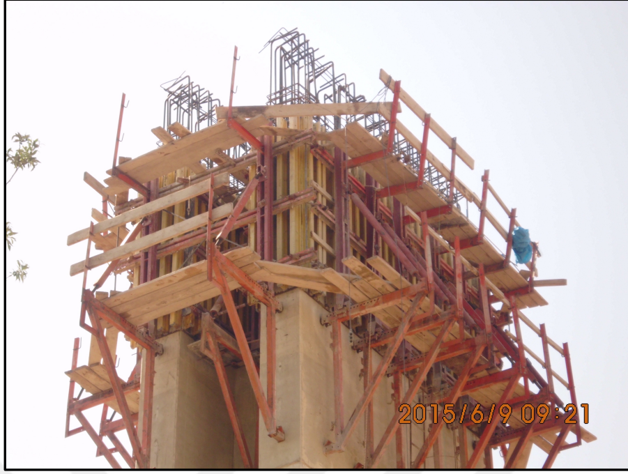
Şekil 5.21 Viyadük ayaklarının yapımında kullanılan kalıp iskele kenar korkulukları ve sabit platformlar-2
