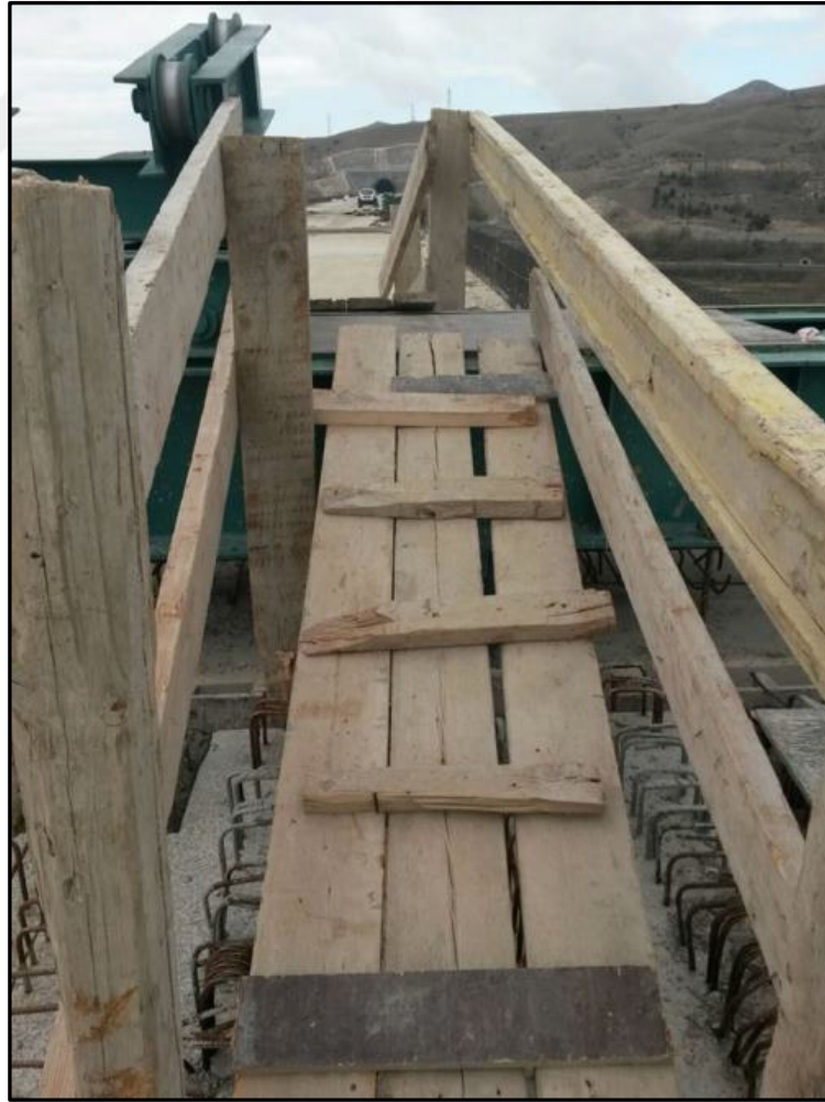
Şekil 5.22 Kiriş yerleştirme makinesine ulaşan merdiven kenar korumalıları
