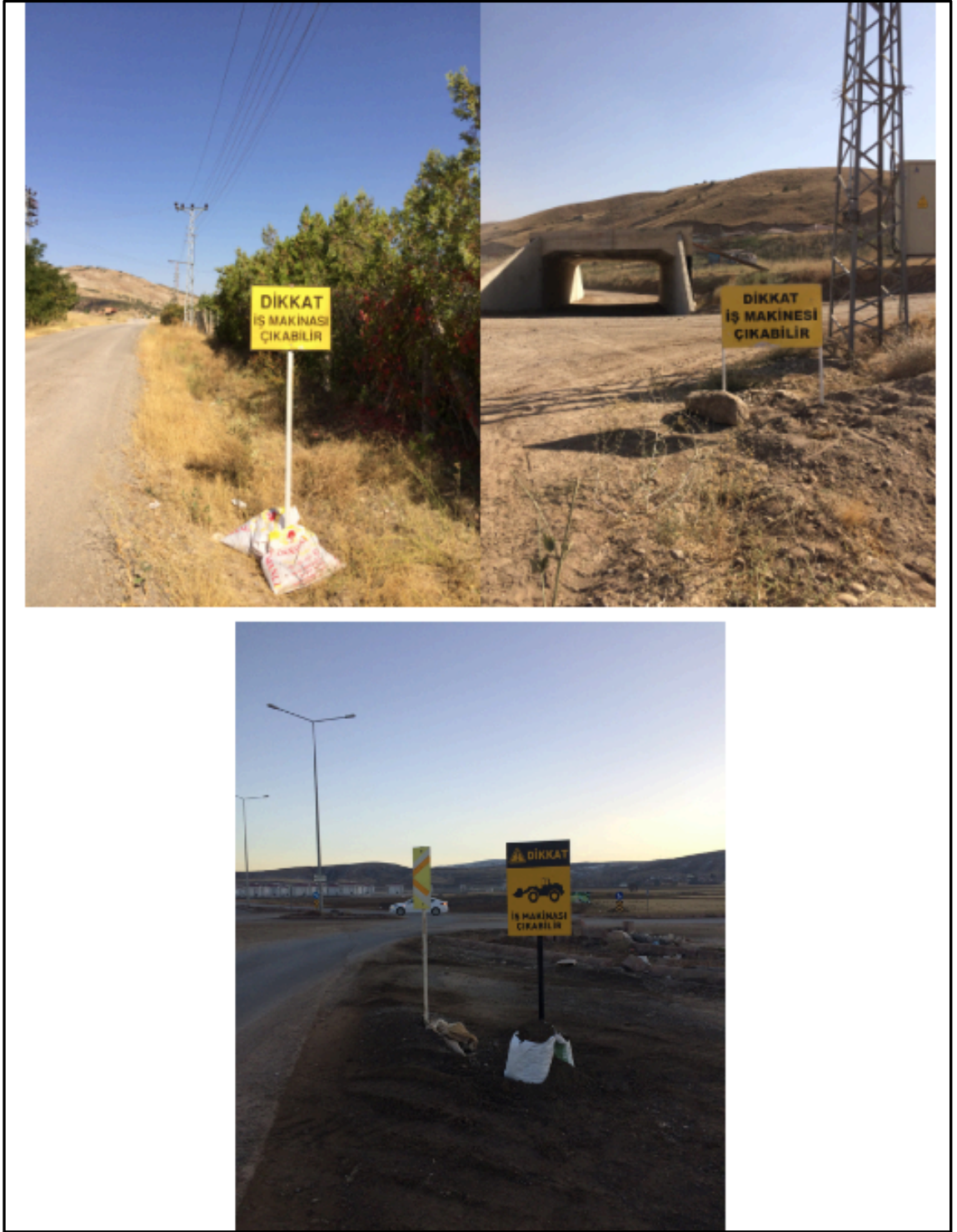
Şekil 5.38 Kazı-Dolgu yapılan sahalara yerleştirilen sarı zemin üzerine siyah piktogramlı “dikkat iş makinesi çıkabilir” levhası
