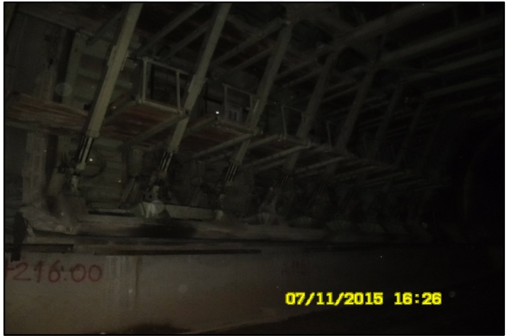
Şekil 5.36 Membran iskelelere konulan kenar korkulukları
