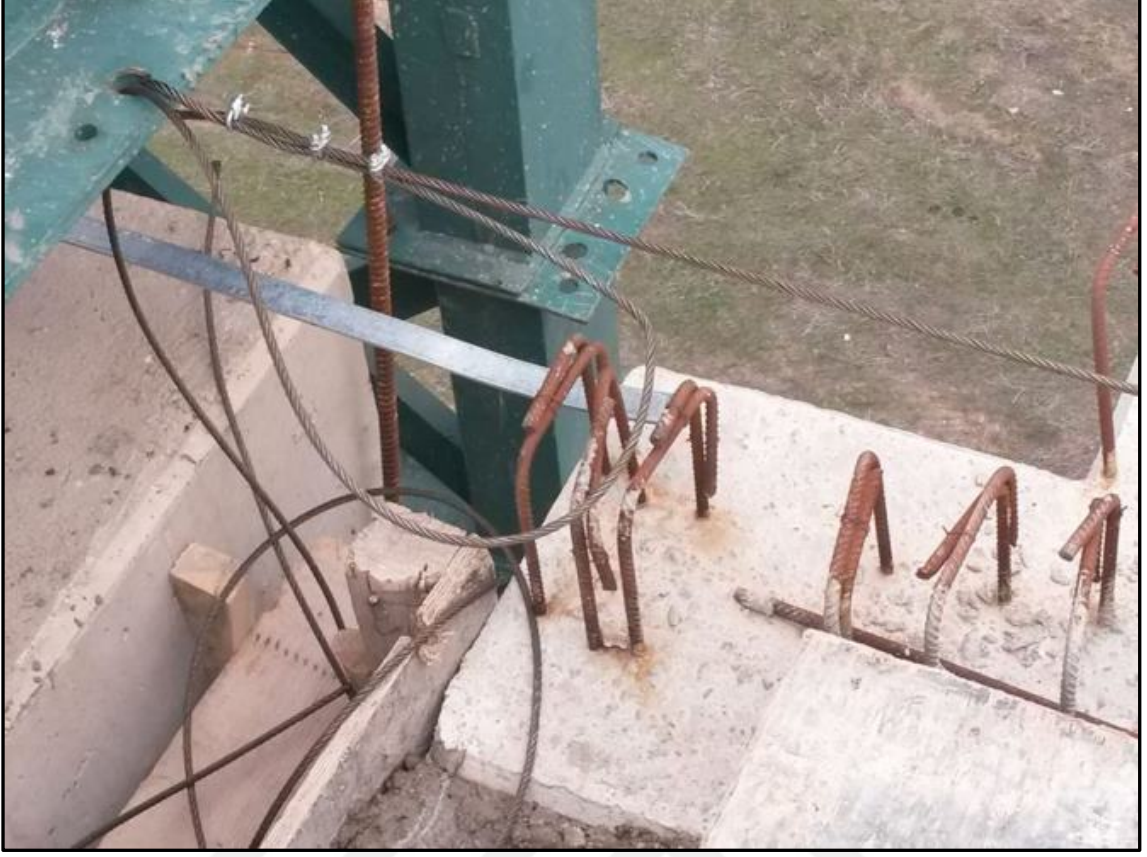
Şekil 5.23 Viyadük kenarı yatay yaşam hattı
