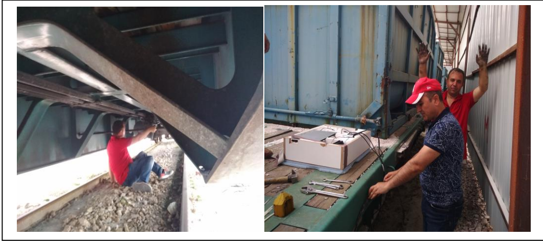
Şekil 7.12 Basınç Sensörü ve Veri Toplama Sisteminin Vagona Yerleştirilmesi
