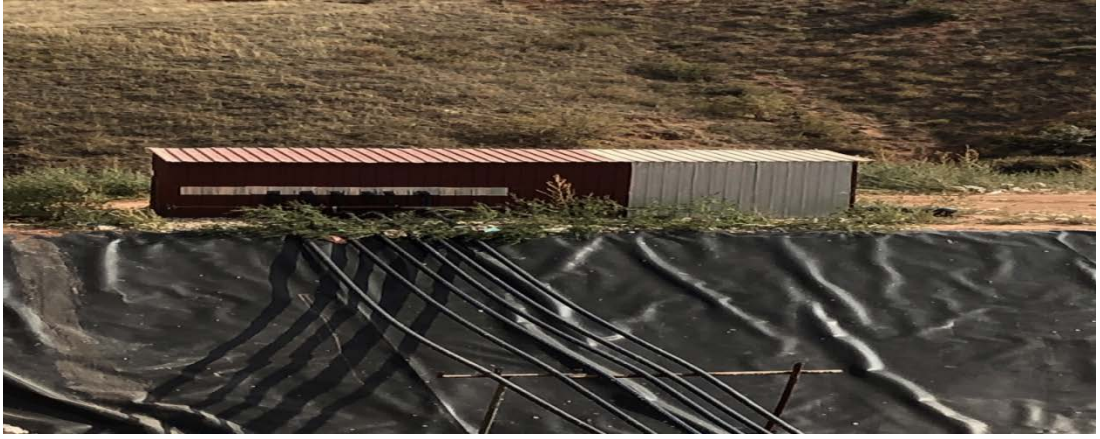
Şekil 5.11 Deponi gazını ölçüm istasyonlarına götüren boru sistemleri
