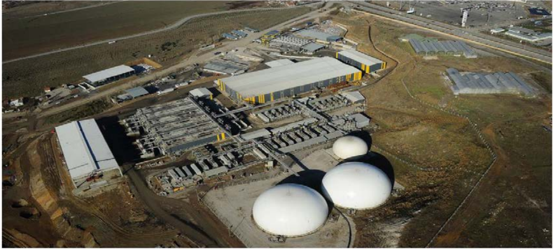
Şekil 4.4 Mamak çöplüğü biyogaz santrali (Aydın, 2013).
