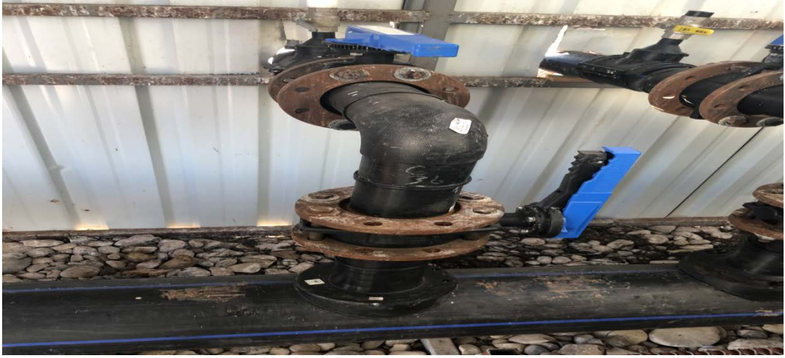
Şekil 5.13 Deponi gazı ölçümlerinin yapıldığı kapaklar
