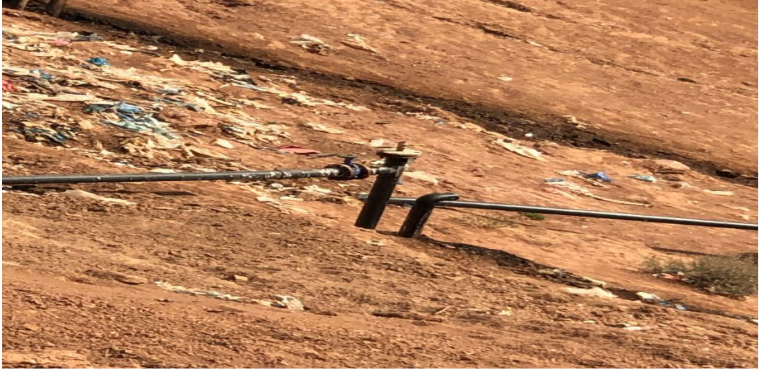
Şekil 5.10 Tesiste kullanılan sifonlar
